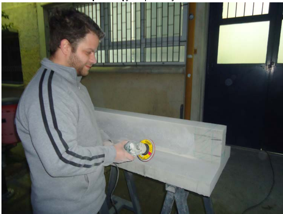
Λείανση πλαϊνής επιφάνειας πλακοδοκών
