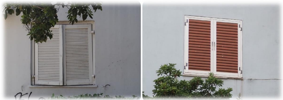
Σχήμα 2.4-7 Κούφωμα χωρίς παρεμβάσεις (ξύλινο)- Κούφωμα με παρεμβάσεις (μεταλλικό)
