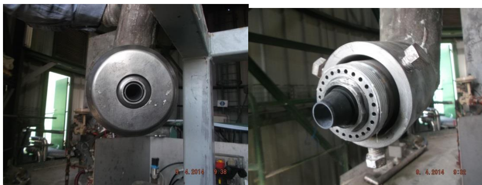
Εικόνα 26 .Μπεκ ψεκασμού του συστήματος LECHLER
