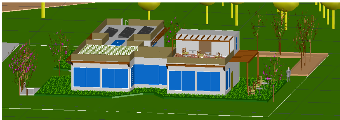
Εικόνα 14 Η δυτική όψη του κτιρίου. Έχει τοποθετηθεί φυσική βλάστηση για την προστασία του κτιρίου από την αντηλιά και τον απογευματινό ήλιο.
