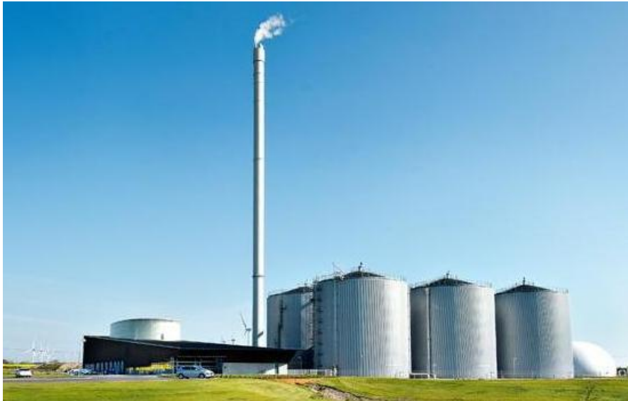
Σχήμα 6.5 Βιομηχανική Μονάδα Βιομάζας
