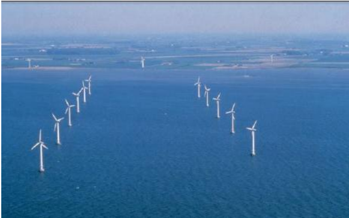
Εικόνα 24 Θαλάσσιο Αιολικό Πάρκο στο Vindeby αποτελούμενο από 11 ανεμογεννήτριες 45
