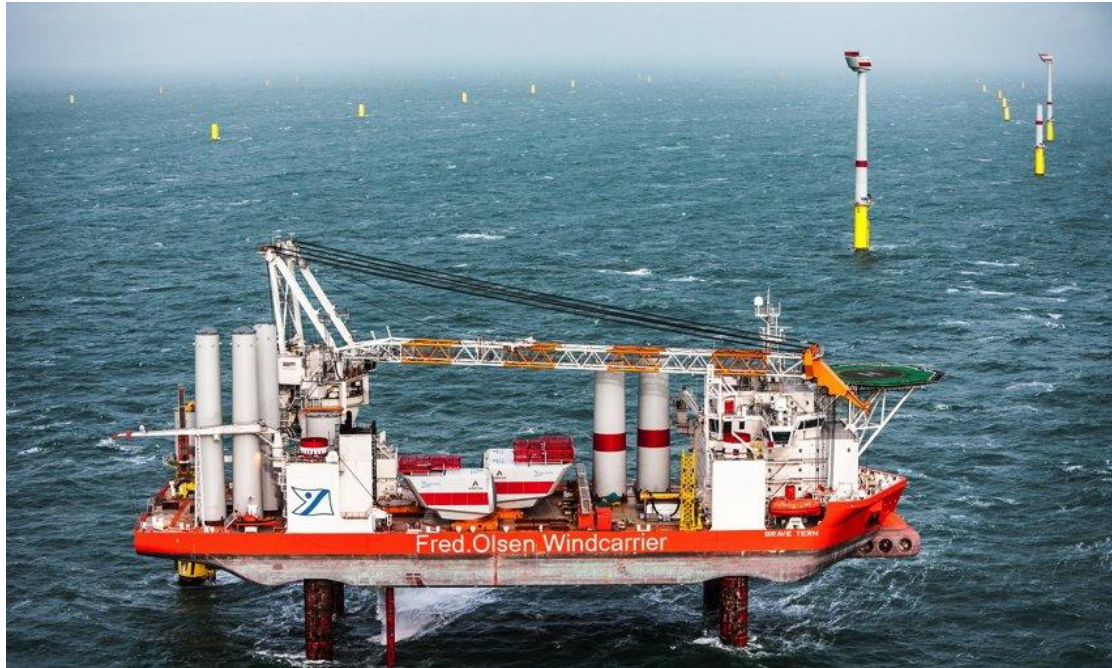
Εικόνα 20 Κατά τη διαδικασία τοποθέτησης των ανεμογεννητριών 41
