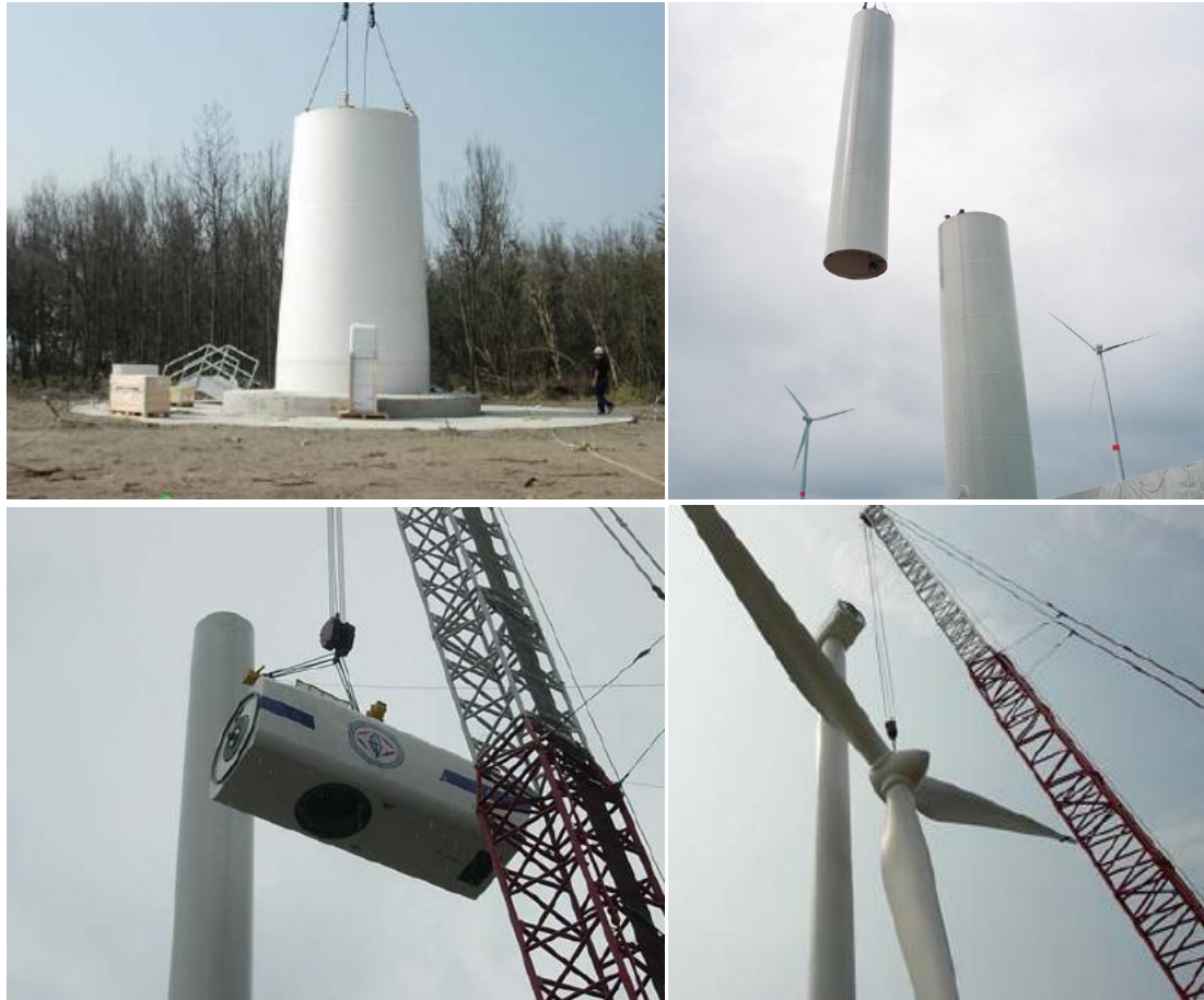
Εικόνα 13 Vestas V80 σύνδεση τμημάτων ανεμογεννήτριας 29
