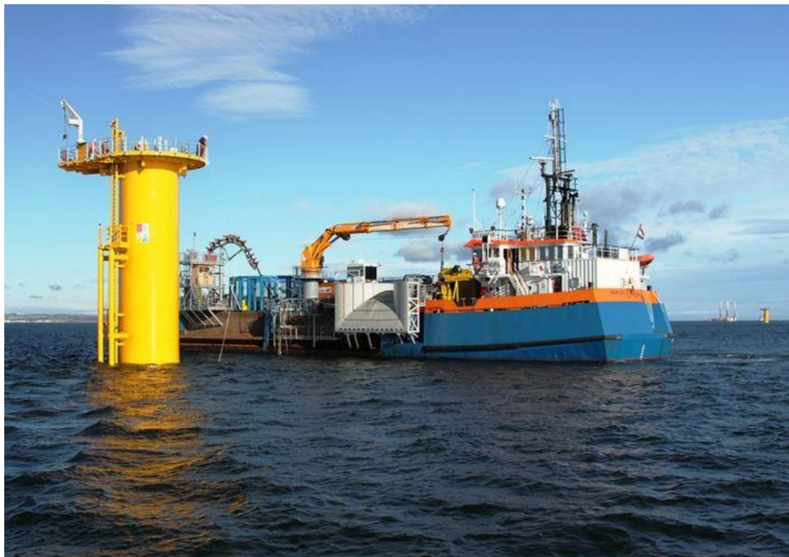
Εικόνα 21 Κατά τη διαδικασία τοποθέτησης των ανεμογεννητριών 42
