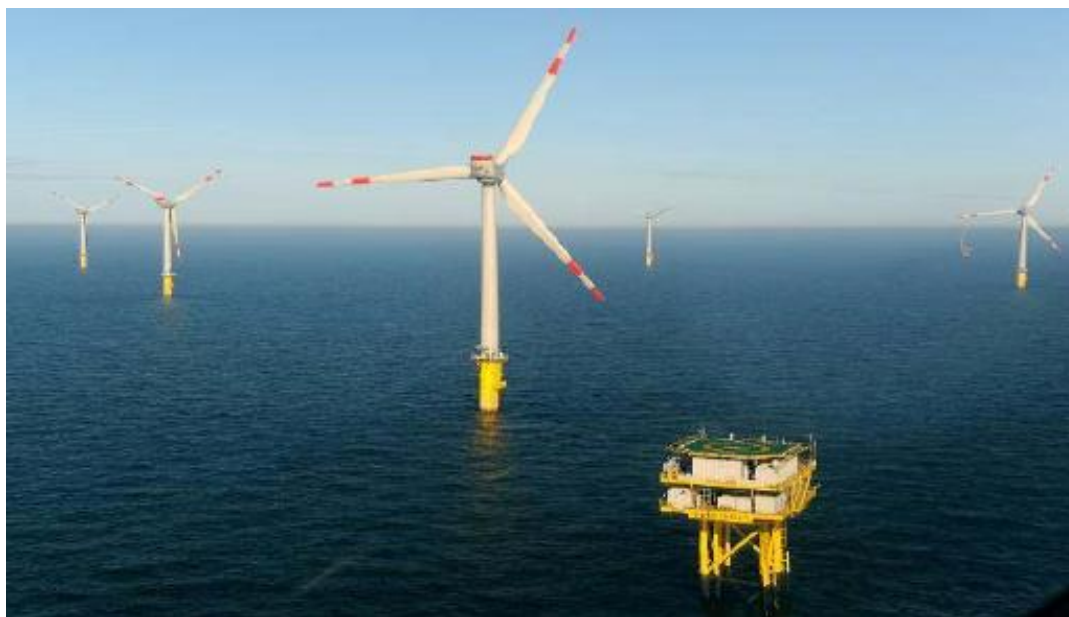
Εικόνα 29 Οι ανεμογεννήτριες και η πλατφόρμα του μετασχηματιστή 49
