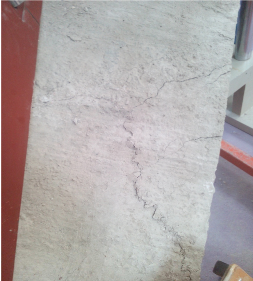
Σχήμα 2.26 Αστοχία πλάκας δοκιμίου
