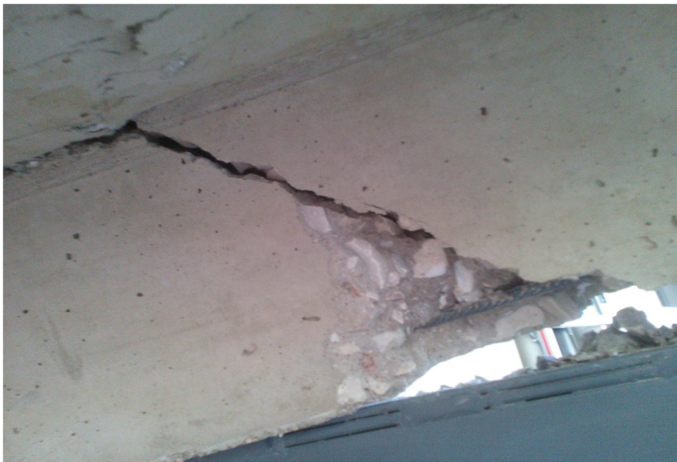
Σχήμα 2.24 Αστοχία δοκού
