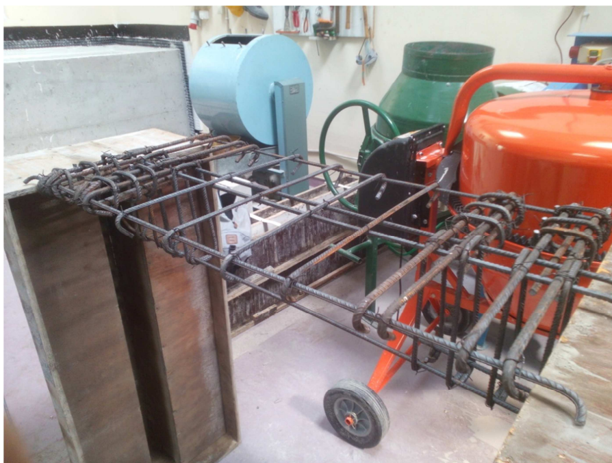
Σχήμα 2.12 Συναρμολόγηση κλωβού
