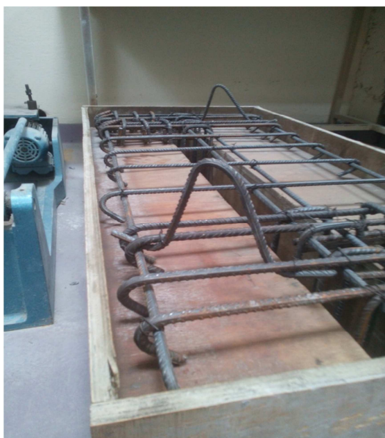
Σχήμα 2.13 Συναρμολόγηση κλωβού
