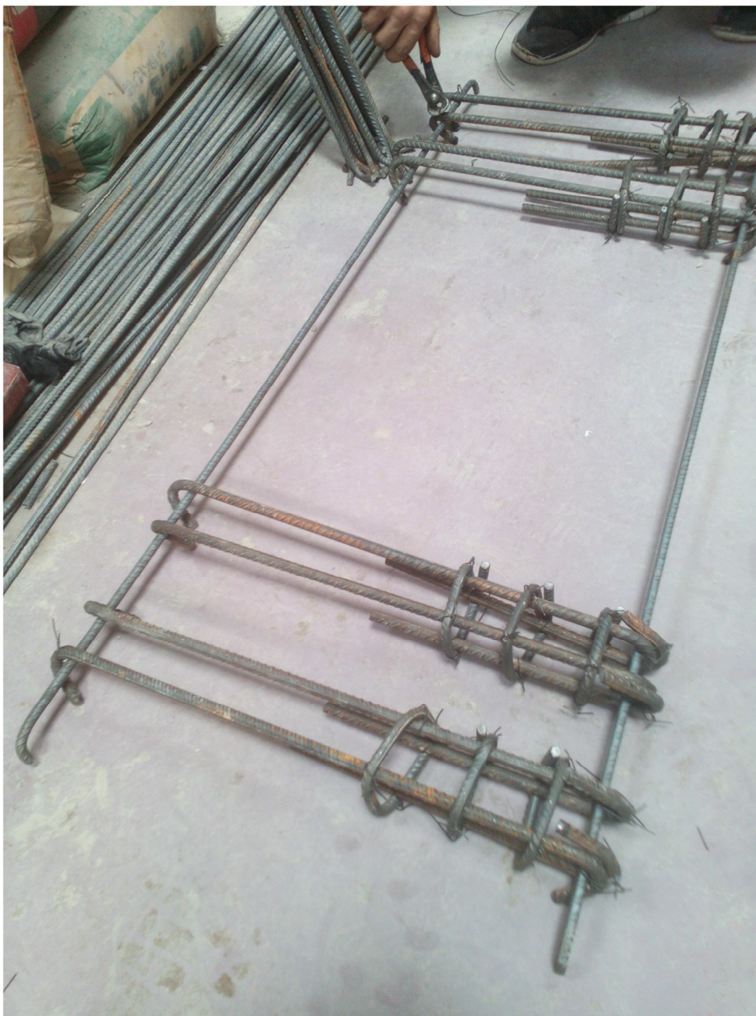
Σχήμα 2.11 Συναρμολόγηση κλωβού
