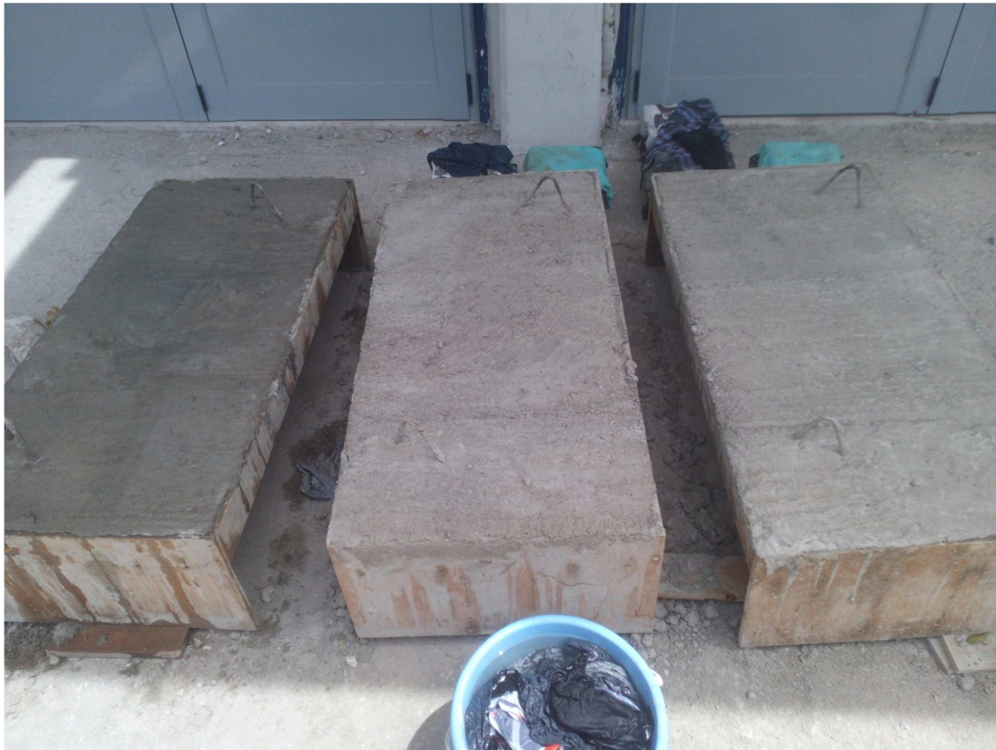
Σχήμα 2.17 Σκυροδετημένες πλακοδοκοί & μήτρες
