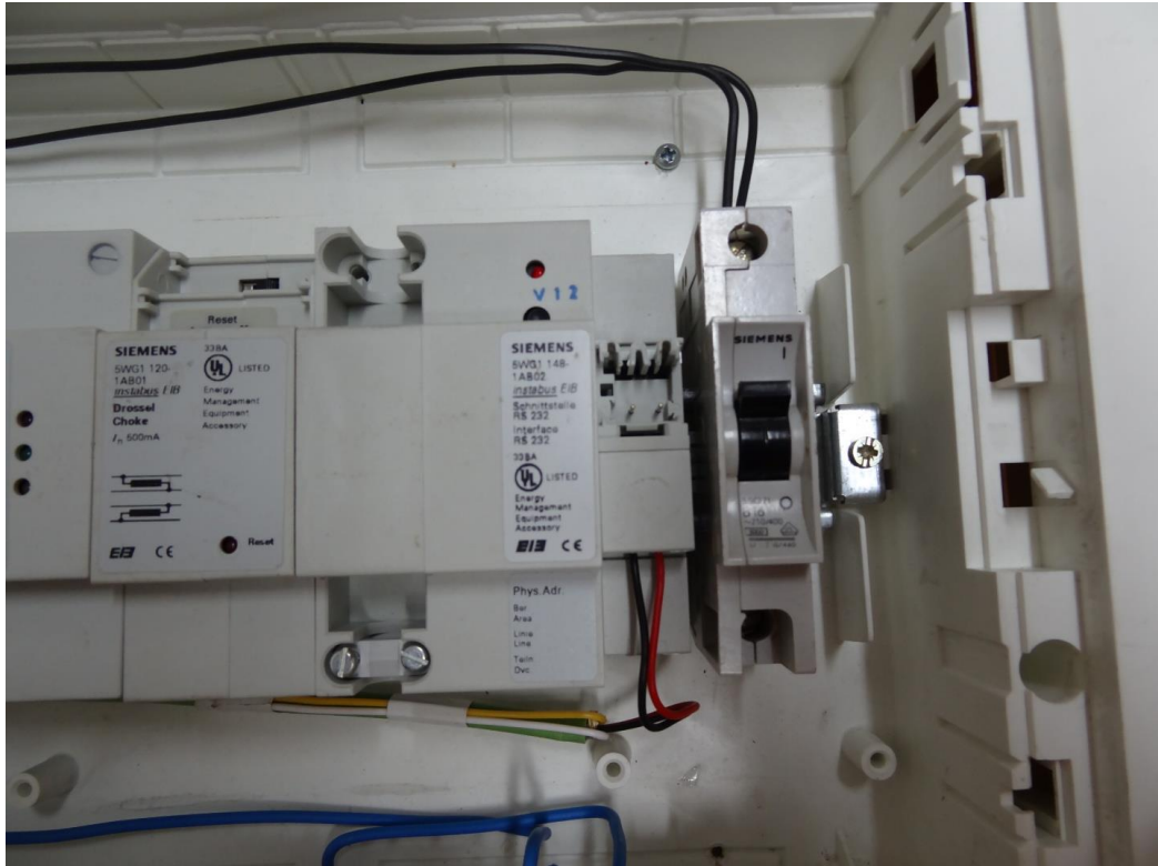
Εικόνα 2.9 Σειριακή θύρα και η ασφάλεια του πίνακα
