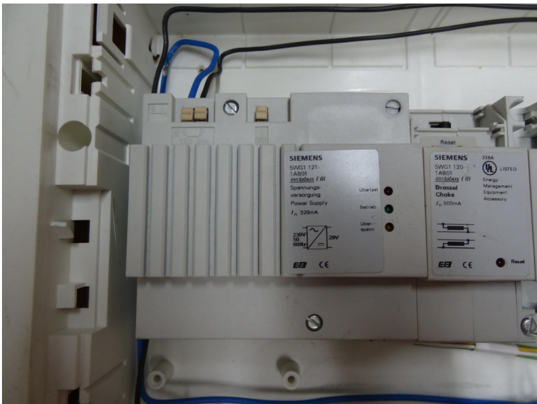
Εικόνα 2.8 Τροφοδοτικό και πηνίο του πίνακα
