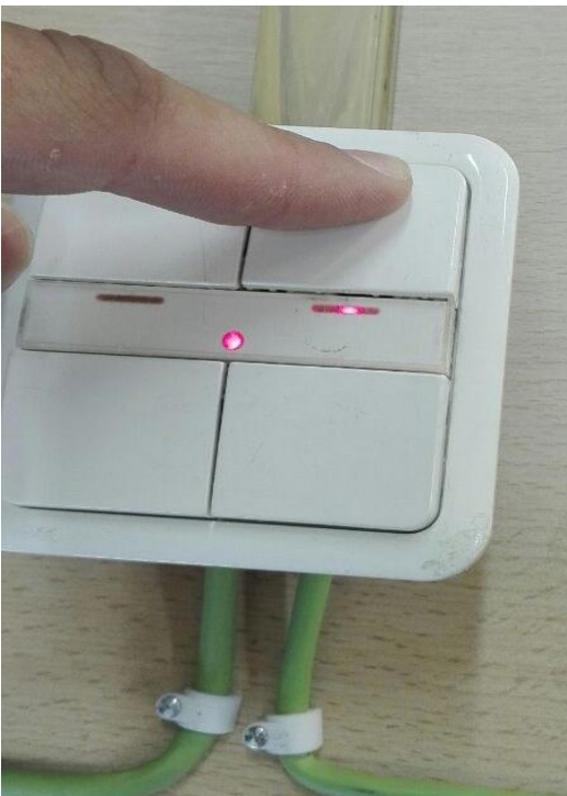
Παράρτημα ΙΙΙ - Εικόνα 7 Ανοίγοντας το φως ανάβει το LED του δεξιού διακόπτη
