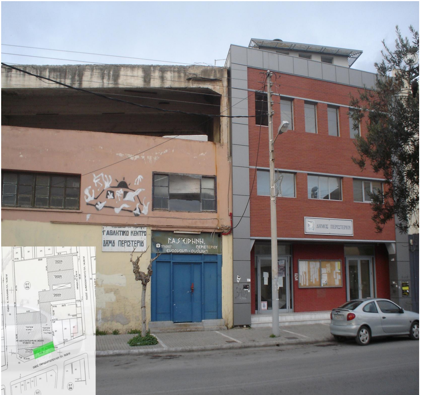
Εικόνα 5, 'Φωτογραφική αποτύπωση υφιστάμενου κτιρίου'
