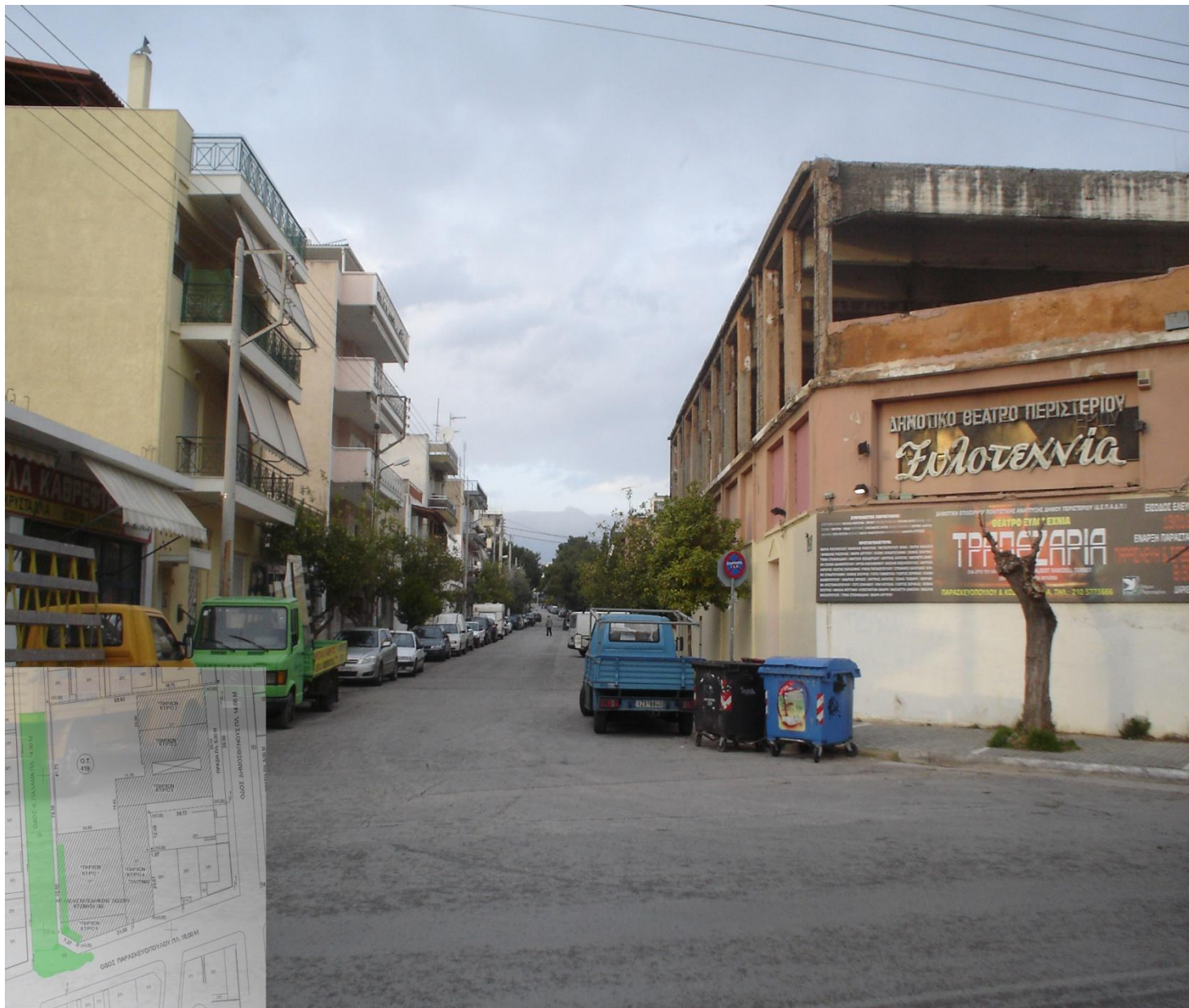
Εικόνα 6, 'Φωτογραφική αποτύπωση υφιστάμενου κτιρίου'
