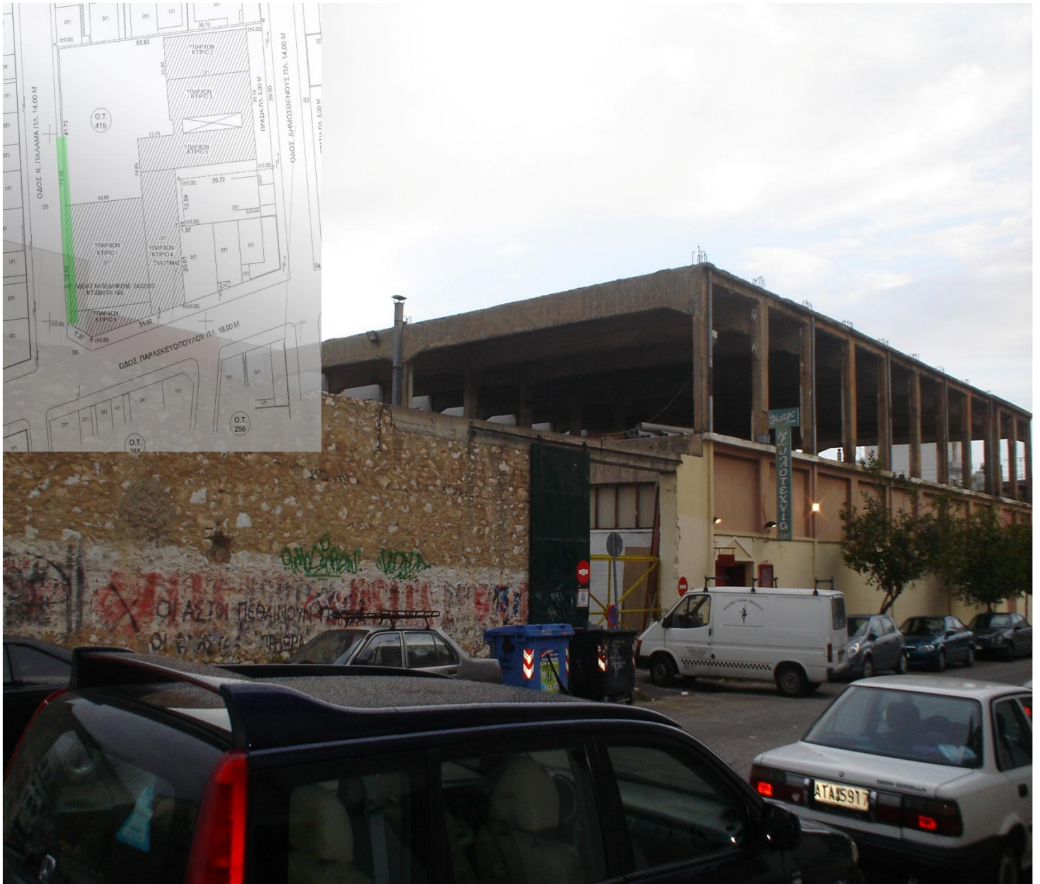
Εικόνα 7, 'Φωτογραφική αποτύπωση υφιστάμενου κτιρίου'
