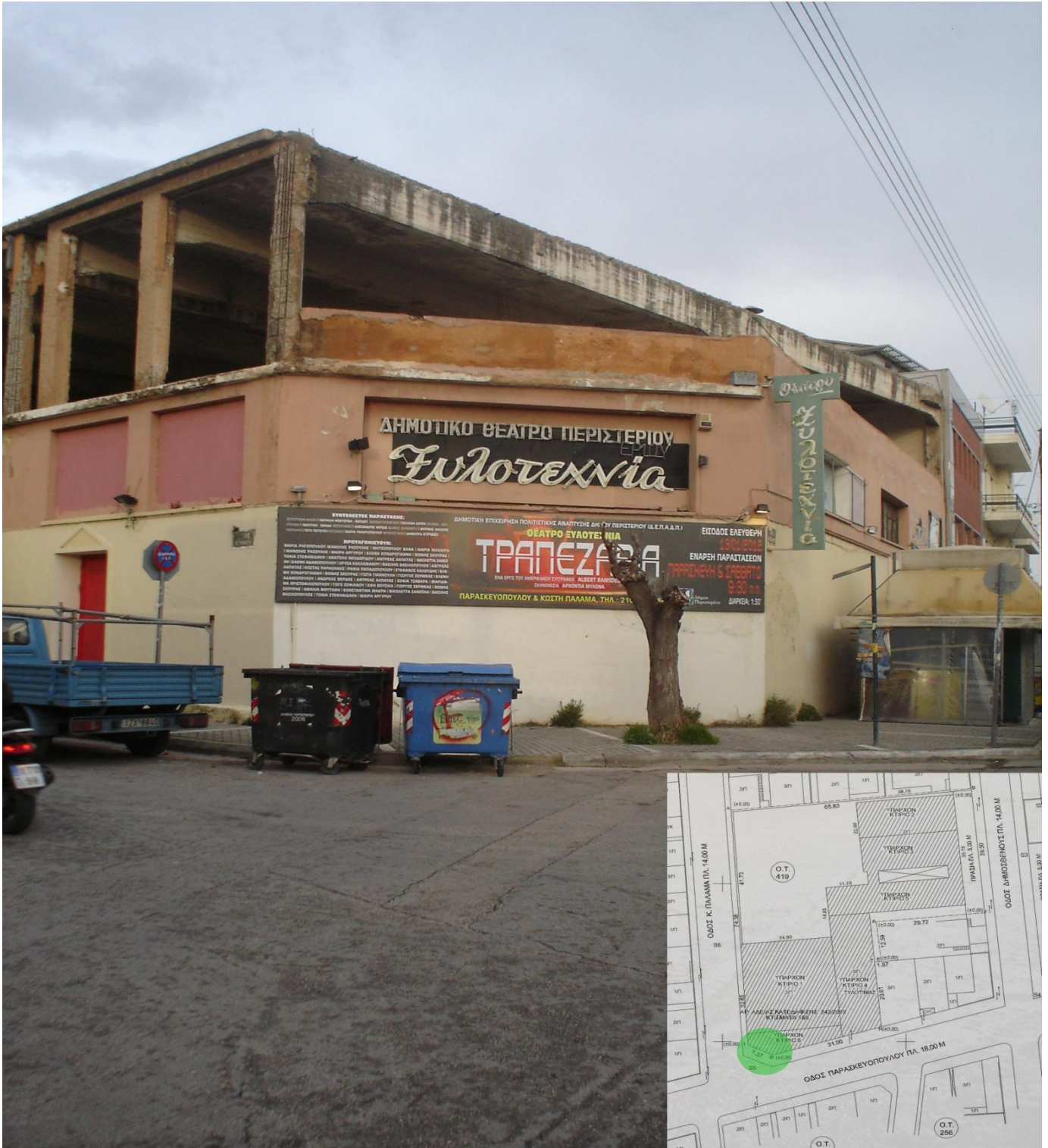
Εικόνα 3, 'Φωτογραφική αποτύπωση υφιστάμενου κτιρίου'
