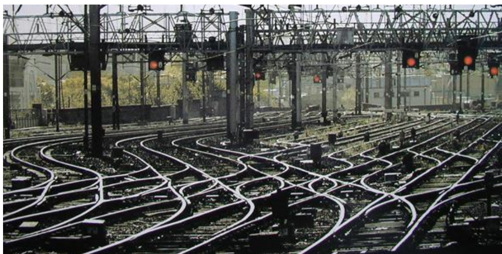
Εικόνα 13. Έγχρωμη φωτεινή σηματοδότηση ανάλογη της κατάστασης της γραμμής.
