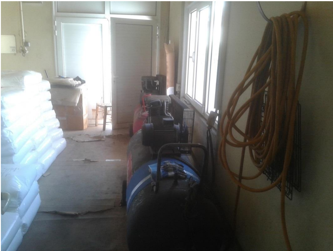
Εικόνα 67 Αεροσυμπιεστές φιλτροπρεσών
