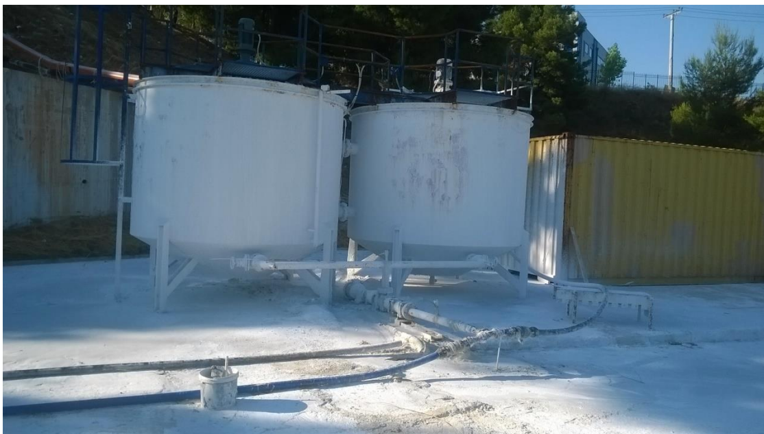
Εικόνα 28 Διάταξη ασβέστη
