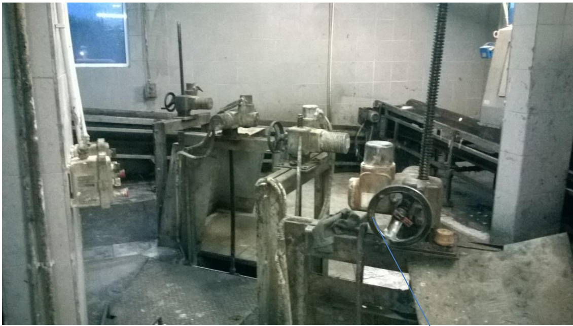
Εικόνα 22 Θυροφράγματα προεπεξεργασίας
