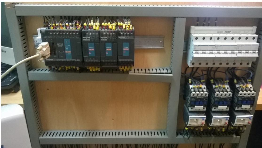
Εικόνα 2 Σύστημα αυτοματισμού με PLC της Fatek
