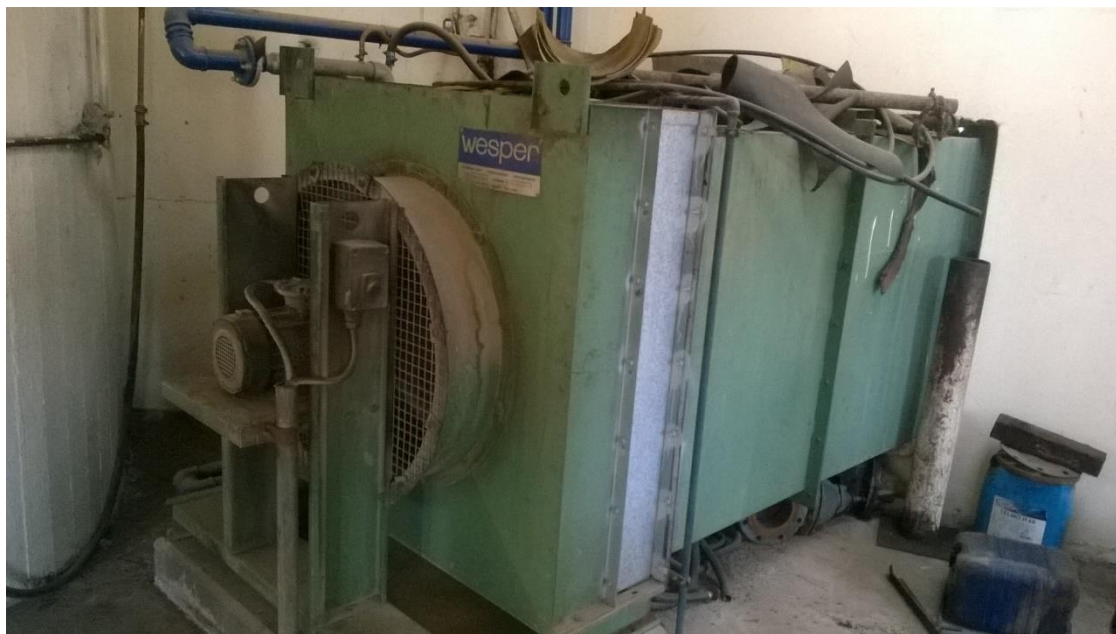
Εικόνα 43 Αεροψύκτης συμπιεστών
