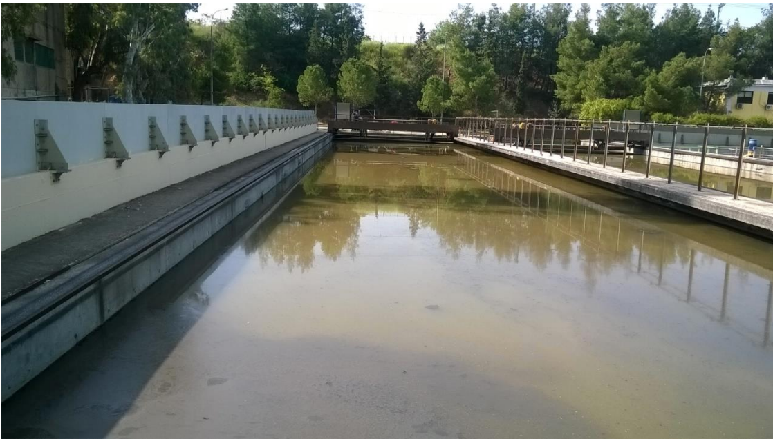
Εικόνα 48 Δεξαμενές καθίζησης
