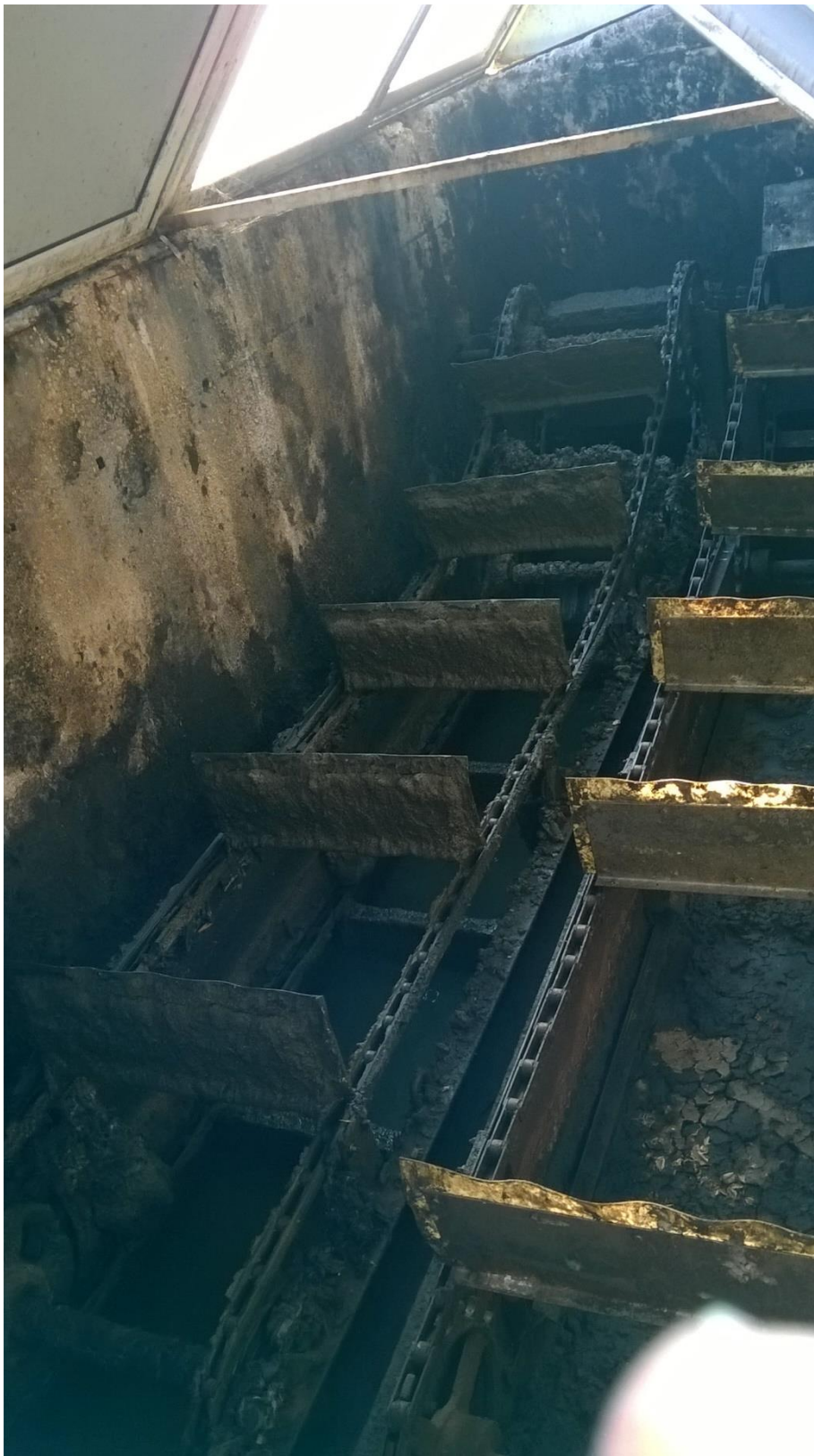
Εικόνα 26 Πτερύγια Λιποσυλλέκτη
