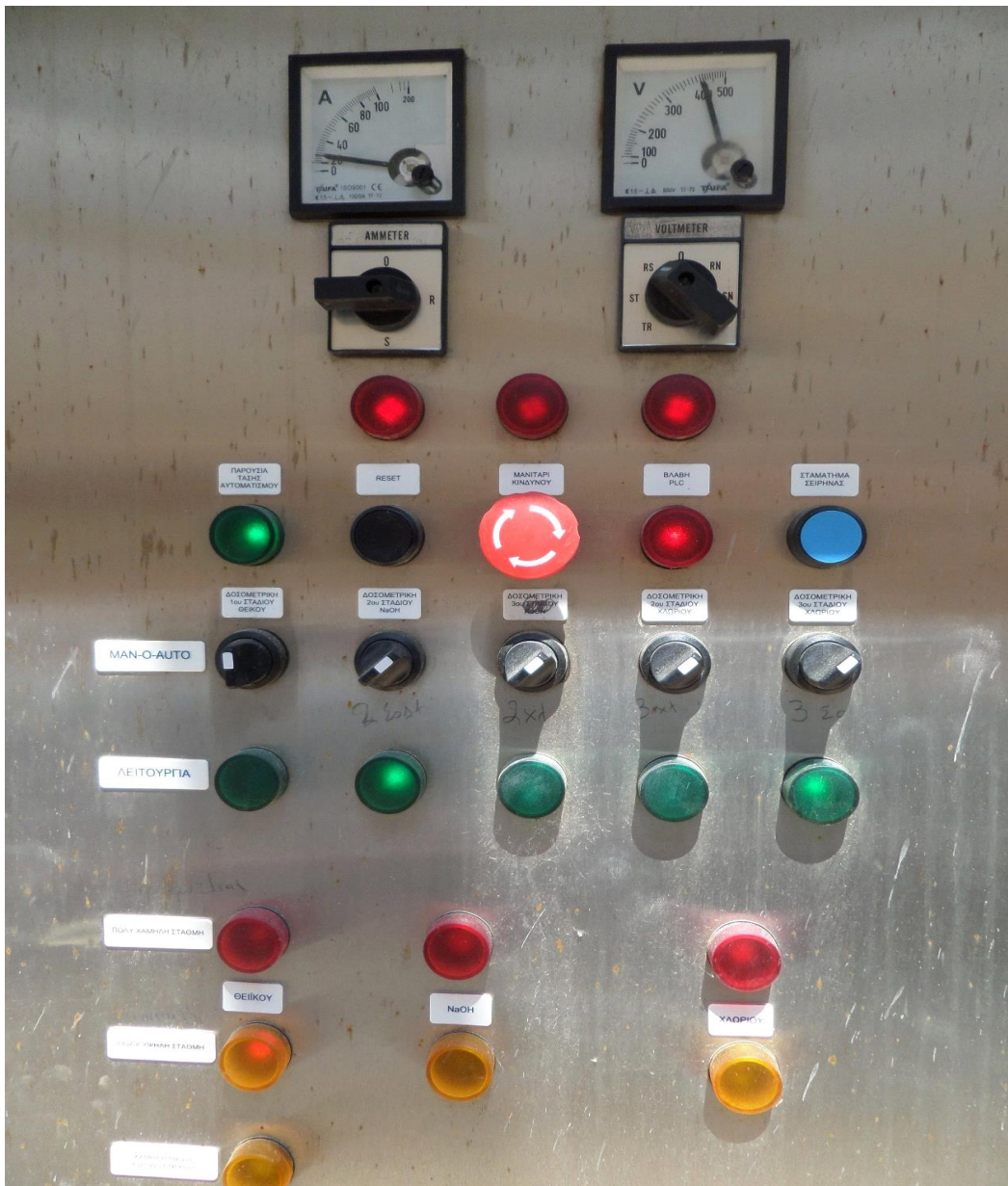
Εικόνα 32 Πίνακας απόσμησης
