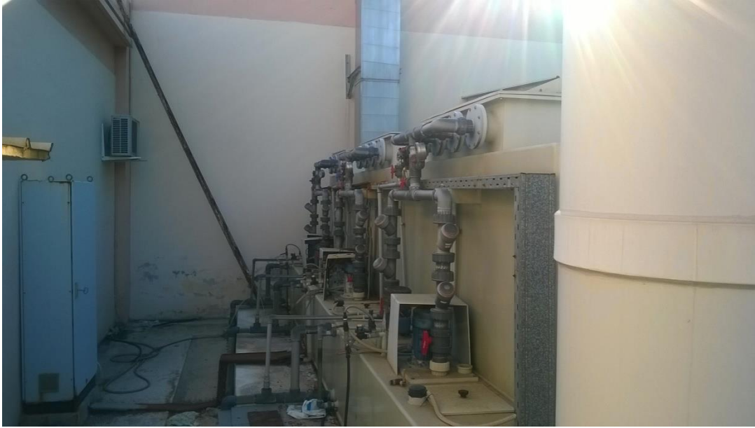
Εικόνα 68 Απόσμιση αφυδάτωσης
