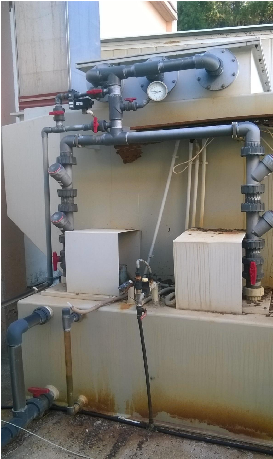
Εικόνα 69 Δεξαμενή απόσμησης
