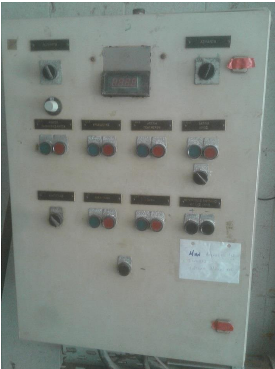
Εικόνα 73 Πίνακας αφυδάτωσης
