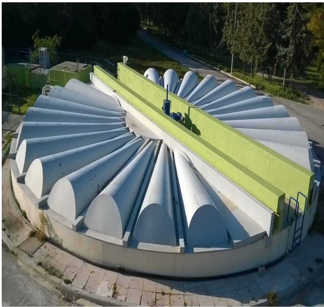
Εικόνα 33 Διαχωριστές υγρών στερεών
