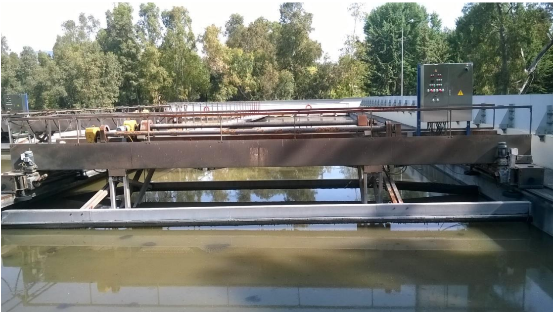
Εικόνα 49 Γέφυρα δεξαμενής καθίζησης
