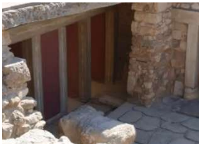
Εικόνα 69 Η ξυλοδεσιά, ενσωματωνόταν στον τοίχο και τον έκανε ελαστικό και ανθεκτικότερο στις σεισμικές δονήσεις.
