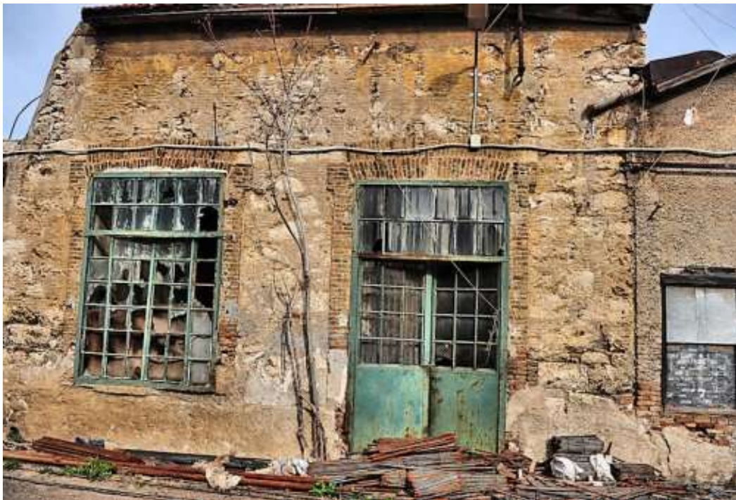
Εικόνα 113 Λιθόκτιστο κτίριο της αρχικής εγκατάστασης
