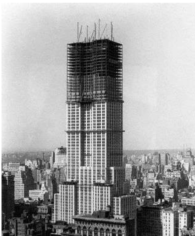
Εικόνα 120 Κατά την κατασκευή του ουρανοξύστη
