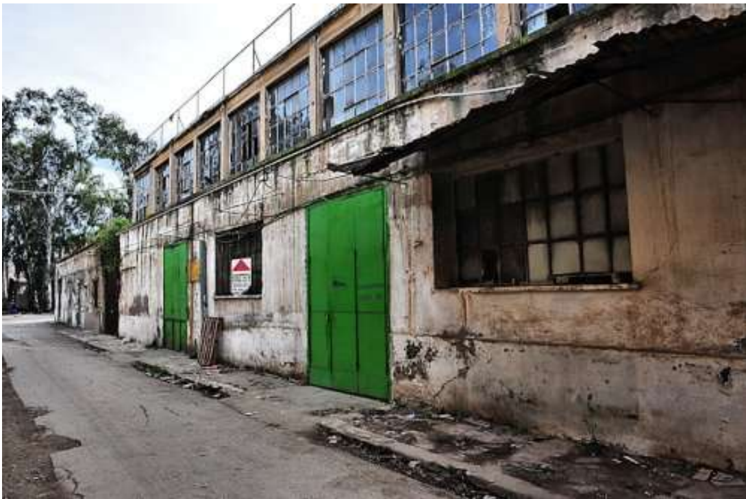
Εικόνα 116 Εσωτερική άποψη του εργοστασίου. Κτήριο της δεκαετίας του 1930
