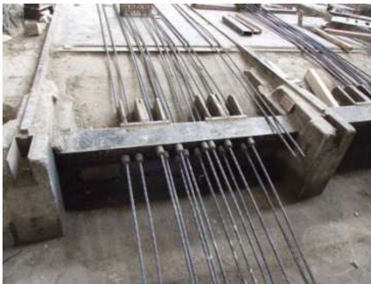
Εικόνα 15 Χάλυβας προέντασης σε προκατασκευασμένο δοκάρι στο εργοστάσιο
