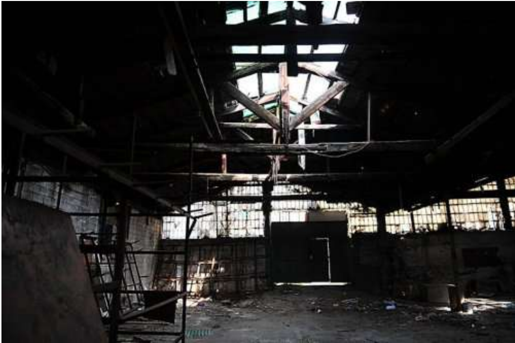
Εικόνα 112 Εσωτερικό κτιρίου με δόρυγτη στέγη
