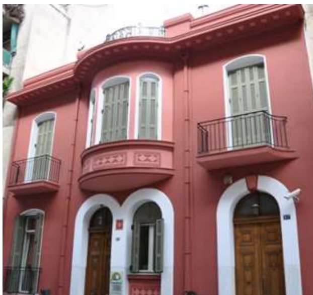
Εικόνα 59 Διατηρητέο κτίριο στη περιοχή της Κυψέλης με έρκερ στο μεσαίο άνοιγμα της πρόσοψης
