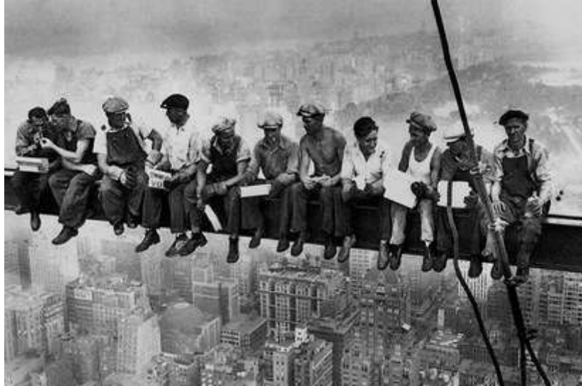
Εικόνα 118 Κατά την κατασκευή του ουρανοξύστη
