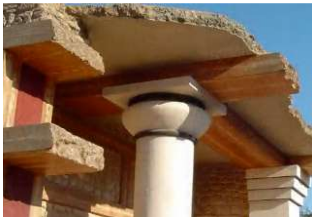
Εικόνα 68 Λίθيني ορθοστάτες δοκαριών και πλακών
