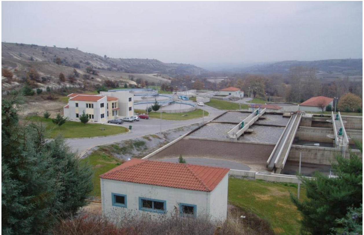
3.4.2 Φωτογραφία με άλλη άποψη της ΕΕΛ Κοζάνης. ΠΗΓΗ: ( http://www.ekkentros.com.gr )
