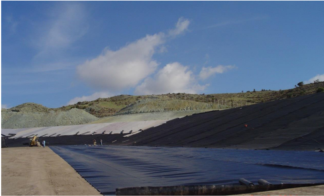
Εικόνα 15: Διάστρωση συνθετικής μεμβράνης ΠΗΓΗ: «Περιβαλλοντική Τεχνολογία», Παραλίκα Μαρία
