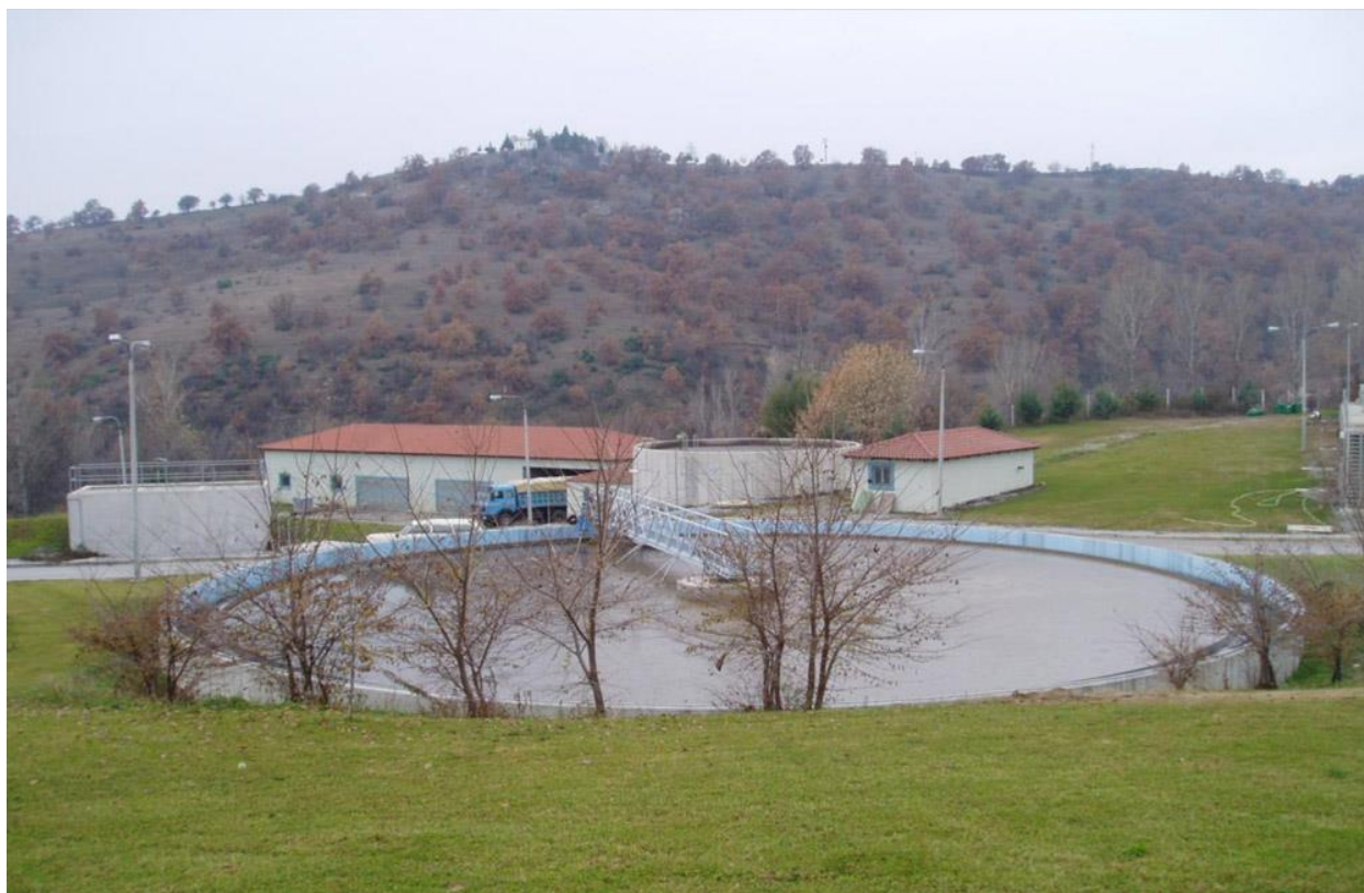
3.4.3 Άποψη της ΕΕΛ Κοζάνης. ΠΗΓΗ: ( http://www.ekkentros.com.gr )
