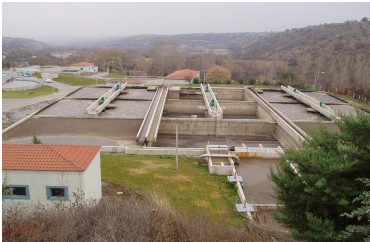
3.4.1 Φωτογραφία με γενική άποψη της ΕΕΛ Κοζάνης. ΠΗΓΗ: http://www.ekkentros.com.gr
