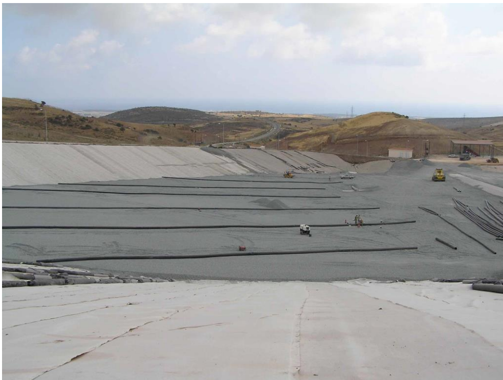
Εικόνα 16: Κατασκευή δικτύου συλλογής-διαχείρισης των στραγγισμάτων ΠΗΓΗ: «Περιβαλλοντική Τεχνολογία», Παραλίκα Μαρία
