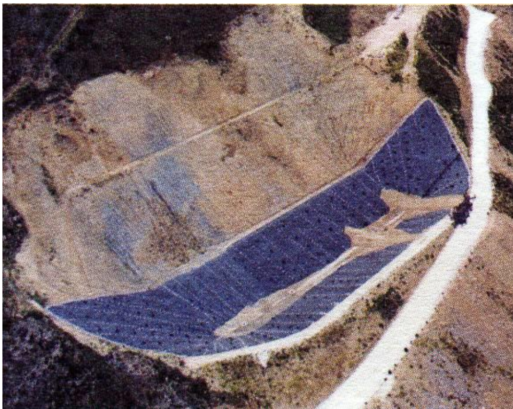
Εικόνα 14: Γενική άποψη ΧΥΤΑ σε φάση κατασκευής ΠΗΓΗ: «Περιβαλλοντική Τεχνολογία», Παραλίκα Μαρία
