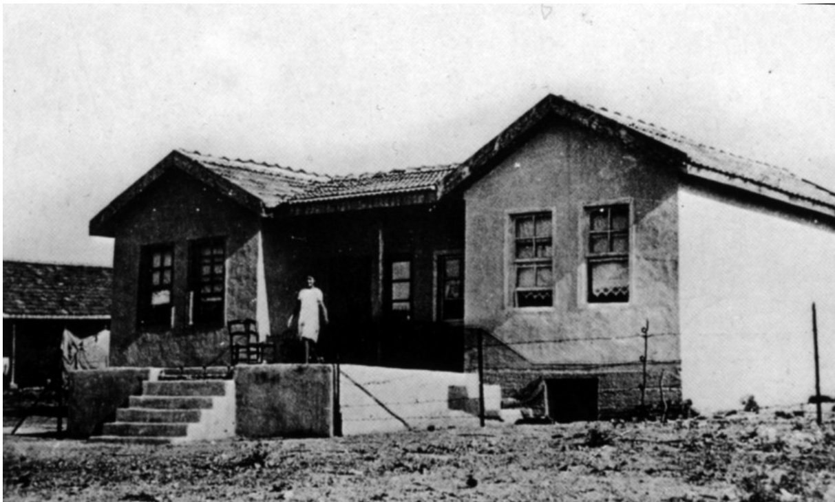
Εικόνα 8 Τύπος αγροτικού σπιτιού για δύο οικογένειες, από αυτά που κατασκεύαζε η επιτροπή αποκαταστάσεως προσφύγων, 1925 4
