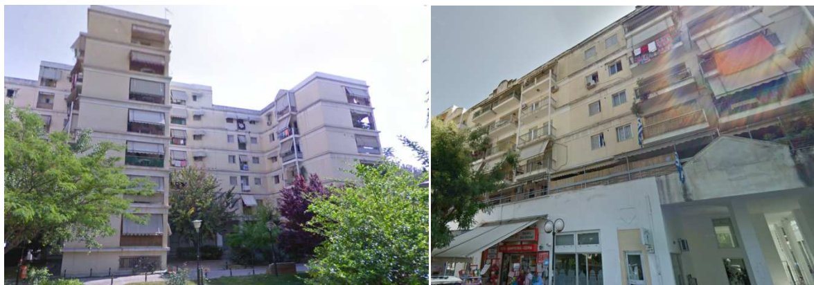
Εικόνα 41 Εσωτερικά και εξωτερικά του οικοδομικού τετραγώνου όπως είναι σήμερα
