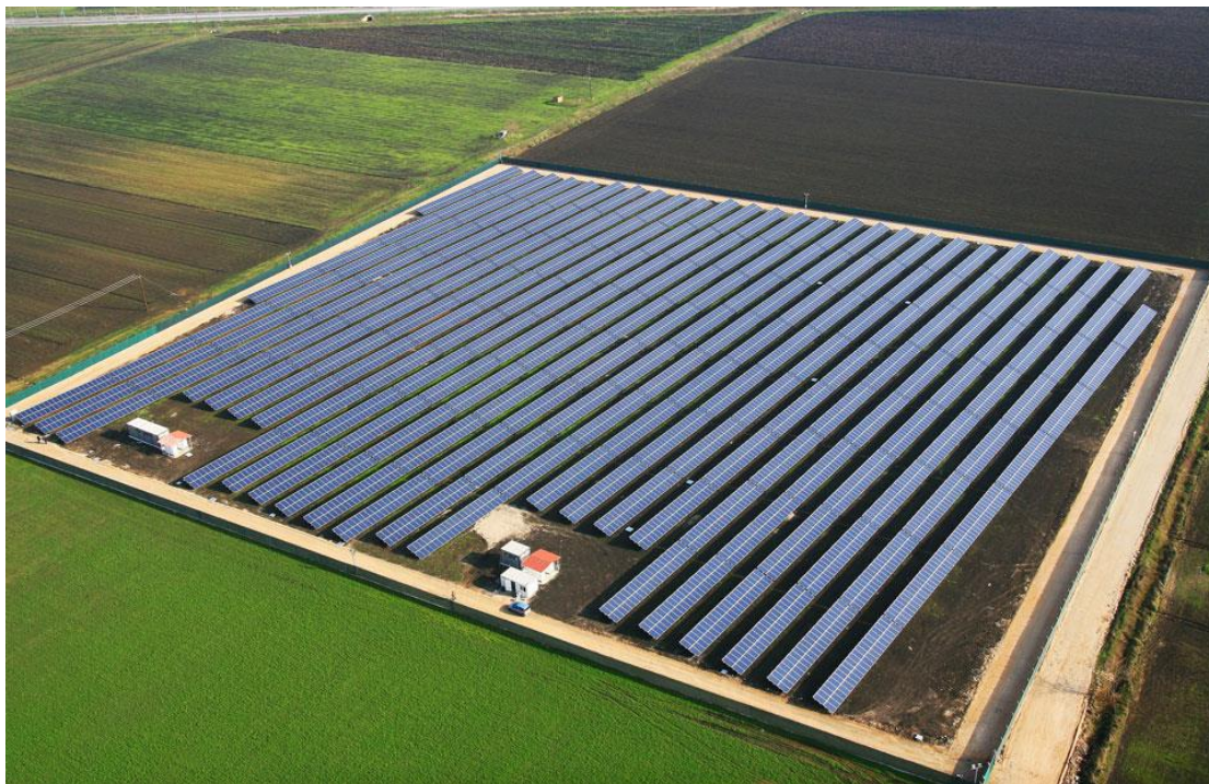
Σχήμα 3.13: Φωτοβολταϊκό πάρκο στην Καρδίτσα με ισχύ 2MW
