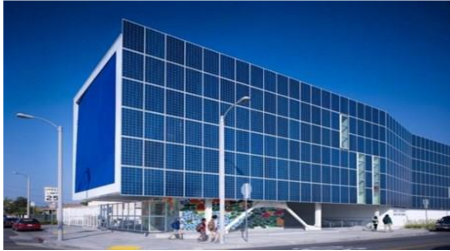
Σχήμα 3.6: Κτίριο με φωτοβολταϊκή πρόσοψη
