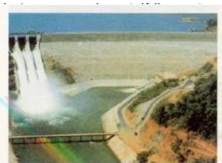
Σχήμα 2.3: Μεγάλο υδροηλεκτρικό έργο
