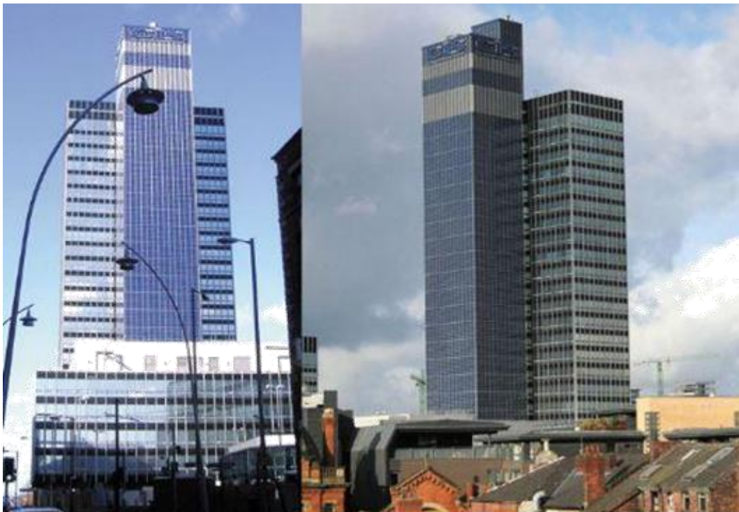
Σχήμα 3.7: Ο πύργος CIS στο Manchester της Μ. Βρετανίας με φωτοβολταϊκή πρόσοψη
