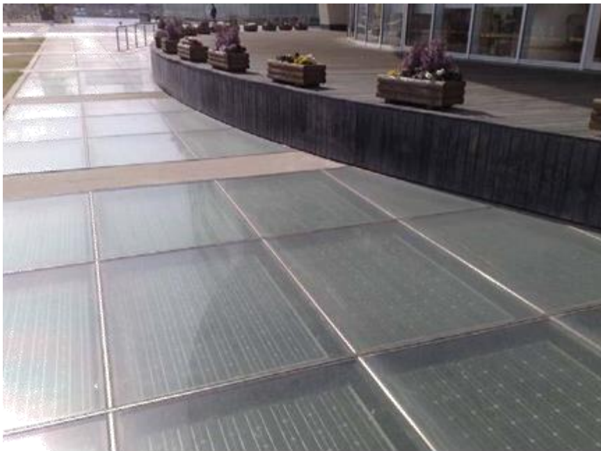
Σχήμα 3.15: Φωτοβολταϊκά σε πεζοδρόμιο
