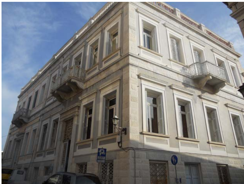
Εικ.21 Δίδυμο, μεγάλου όγκου, κτίριο που χτίστηκε στα 1887-88. Όψεις με αδρά λαξευμένα μαρμάρινα στοιχεία, τοίχοι σοβατισμένοι και χρωματισμένοι. Χυτές σιδεριές στα μπαλκόνια επί της πλατείας, σύμφωνα με την μόδα της εποχής, σφυρήλατες κλασικές στις πλάγιες όψεις. Στο εσωτερικό ξύλινη σκάλα, χρωματιστά βιτρό και αξιόλογος ζωγραφικός διάκοσμος.
