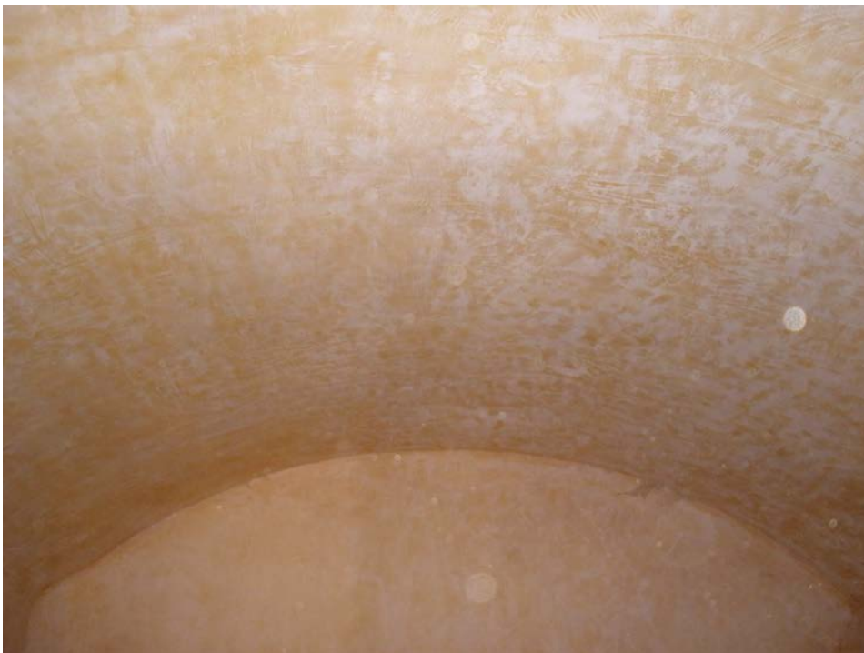
Εικ.36 Υπόγεια δεξαμενή νεοκλασικής κατοικίας με επίχρισμα πορσελάνης.
