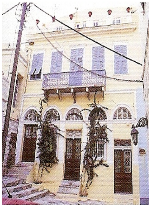
(α) Αρχικά η όψη του κτιρίου
