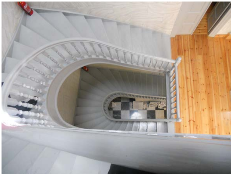
Εικ.40 Ξύλινη μνημειακή σκάλα στο κτίριο Βελισσαρόπουλου.
