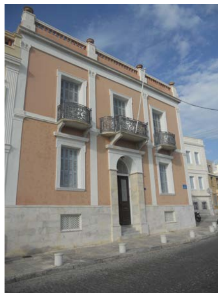
Εικ.24 Σπίτι στην περιοχή του Αγ. Νικολάου στα χρώματα του νεοκλασικού τύπου.
