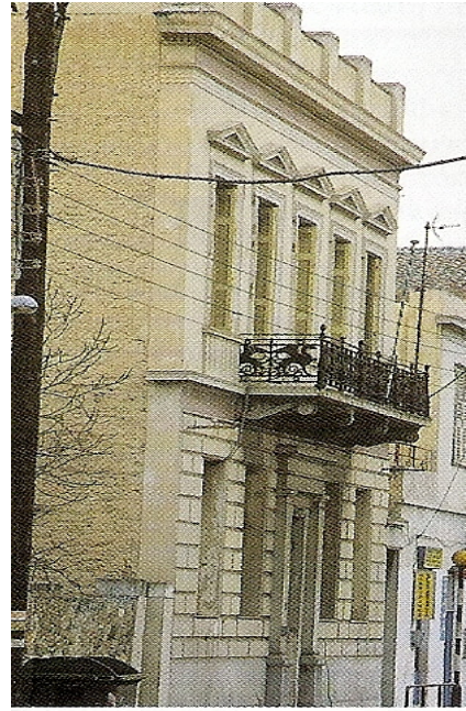
Εικ.16 Νεοκλασικό αθηναϊκού τύπου, στην οδό Μανδηλαρά. Ισόγειο με επίπλαστη ισόδομη λιθοδομή διαμορφωμένη από σοβά. Χτισμένο στα τέλη του 19 ου αι.
