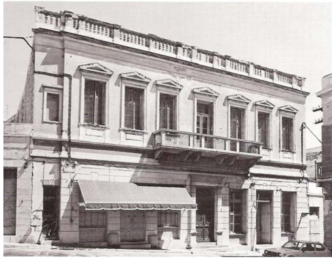
Εικ.19 Οικία Κ. Πετρίτση. Χτίστηκε το 1890. Απόλυτη συμμετρία, σοβατισμένο με χαραγμένους αρμούς στο ισόγειο. Αετώματα στα ανοίγματα του ορόφου, στέψη με κολονάκια και μαρμάρινο μπαλκόνι. Πατώματα με σιδηροδοκούς και εσωτερική κυκλική μαρμάρινη σκάλα.
