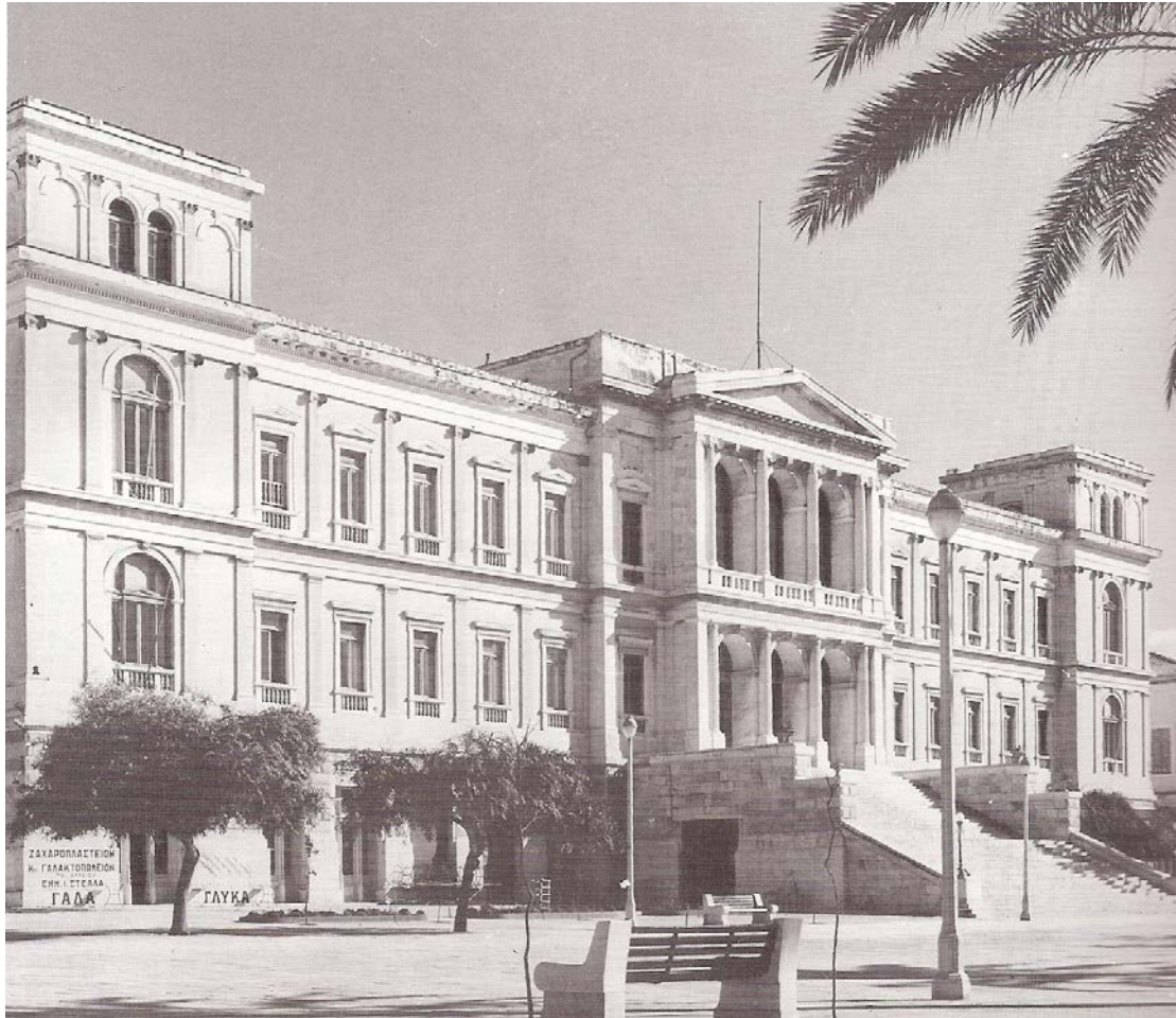
Εικ.8 Το Δημαρχείο της Ερμούπολης. Θεμελιώθηκε στα 1876 με σχέδια του Ernest Ziller.
