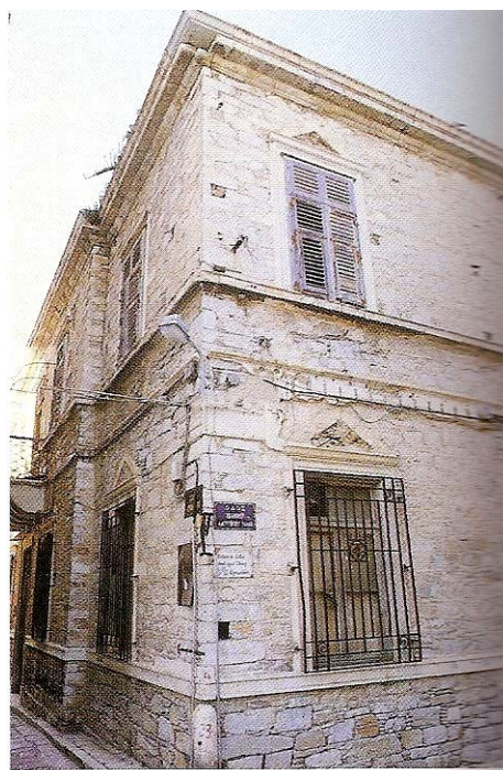
Εικ.48 Εξωτερικές όψεις του κτιρίου πριν την αποκατάσταση
