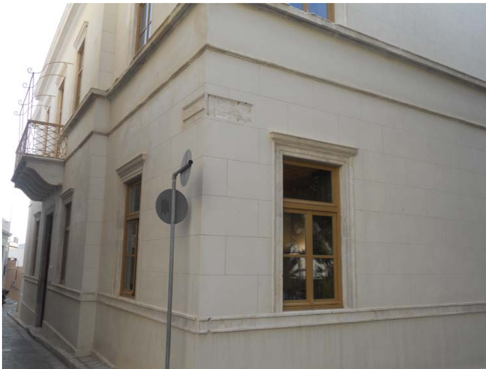
Εικ.53 Η εξωτερική όψη του κτιρίου Πρασσακάκη μετά την αποκατάσταση.
