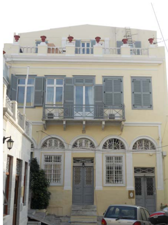
(β) Σημερινή όψη του κτιρίου
