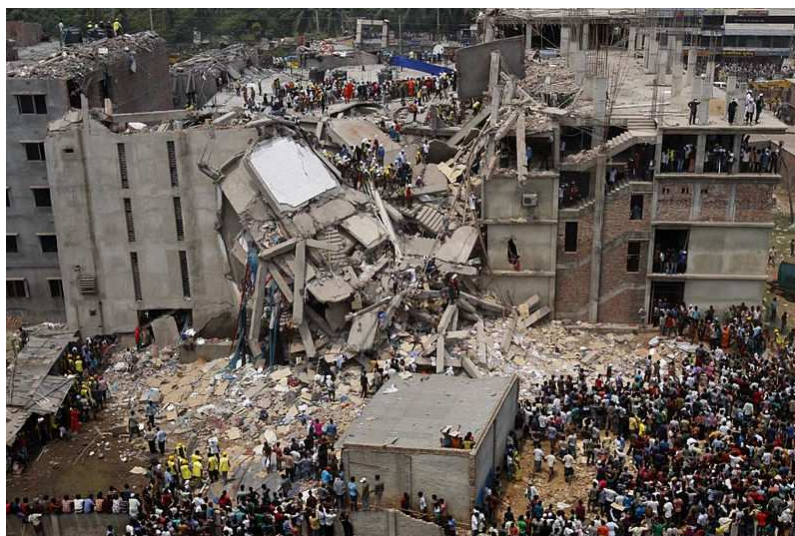
Εικόνα 3.7: Εναέρια φωτογραφία του κτιρίου Ράνα Πλάζα έπειτα από τη κατάρρευση.
