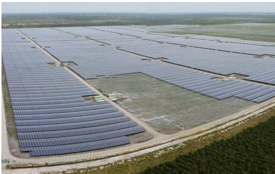
Εικόνα 4:Το φωτοβολταϊκό πάρκο Cestas συνδεδεμένο στο δίκτυο Πηγή: http://www.naftemporiki.gr/story/1035582/
