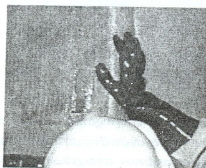
Εφαρμογή προ-εμποτισμένου υφάσματος σε υποστύλωμα
