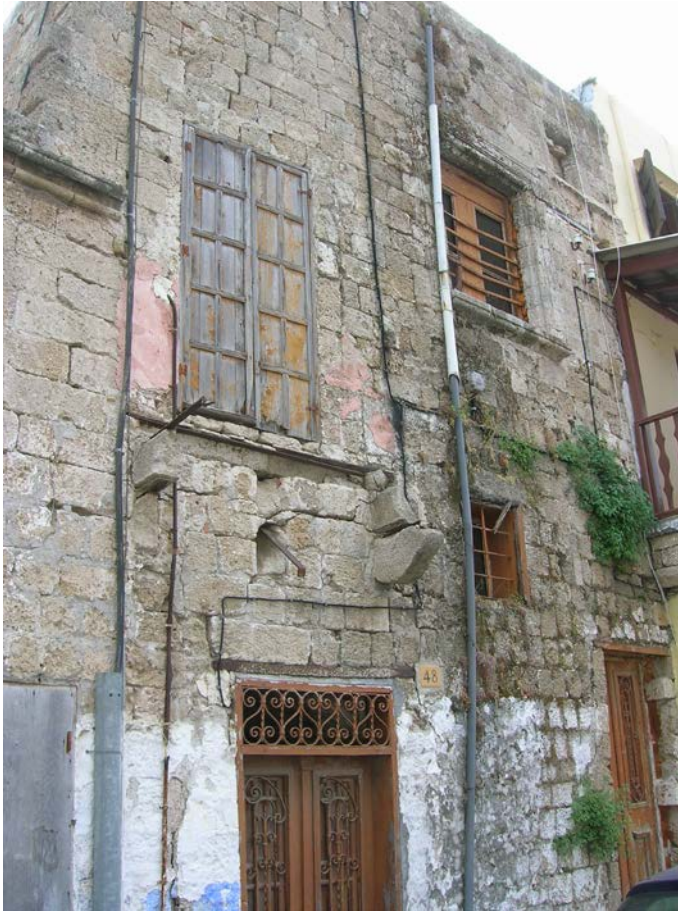
Φωτ. 30 : Λεπτομέρεια υπολείμματος εξώστη επί της προσόψεως της οδού Θησέως ιδιοκτησίας Δωροθέας Μαυράκη
