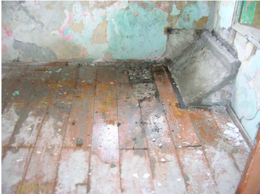
Φωτ. 23 : Νερά στο πάτωμα του δωματίου «Α1» από την διαπερατή οροφή του
