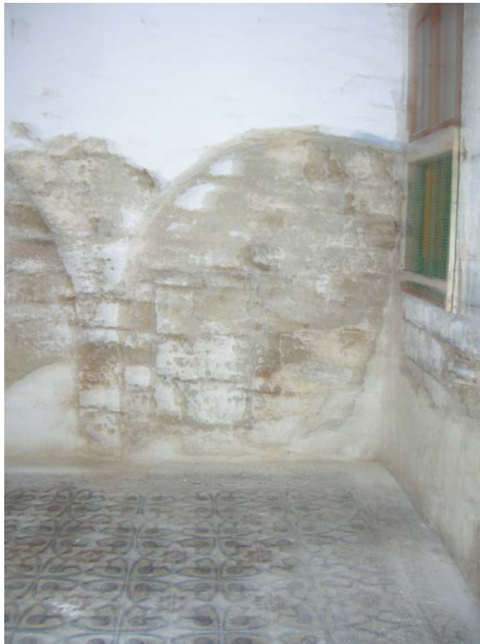
Φωτ. 3 : Λεπτομέρεια δαπέδου και δυτικού τοίχου δωματίου «1»
