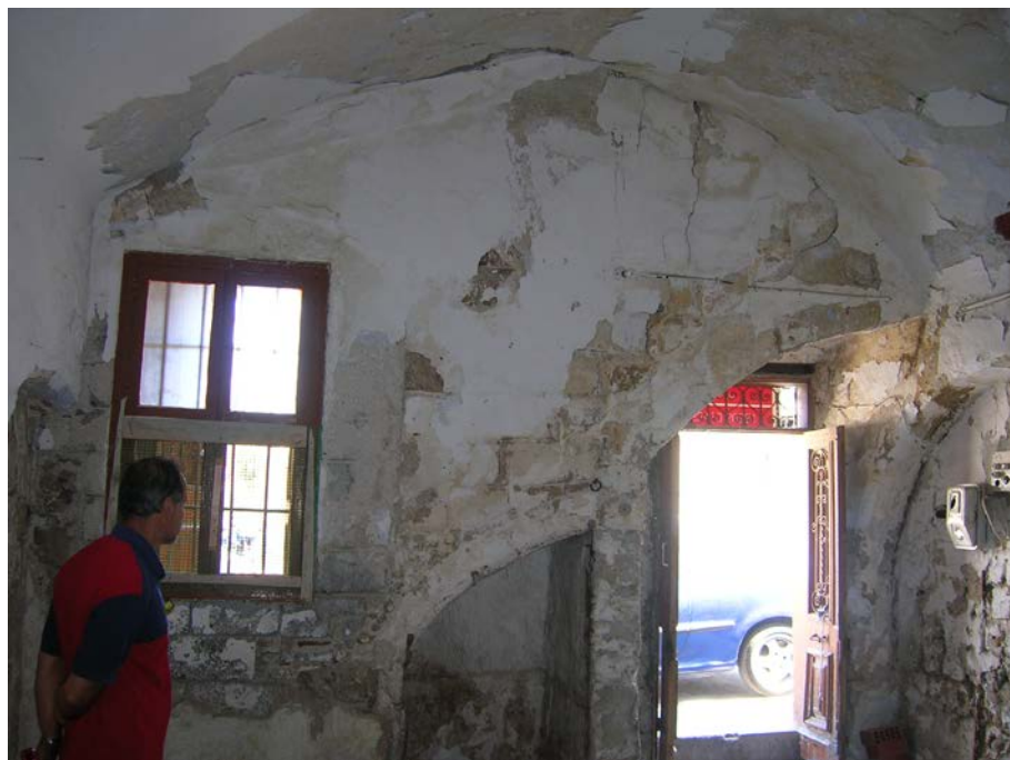
Φωτ. 4 : Θολωτή οροφή δωματίου «1»
