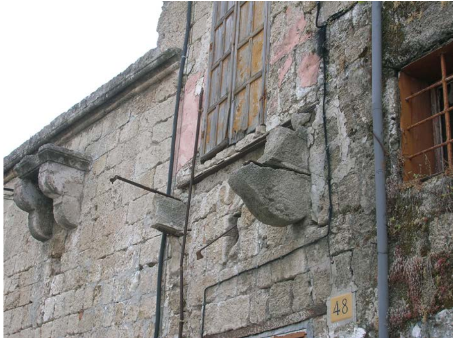
Φωτ. 28 : Λεπτομέρεια υπολείμματος εξώστη επί της προσόψεως της οδού Θησέως ιδιοκτησίας Δωροθέας Μαυράκη
