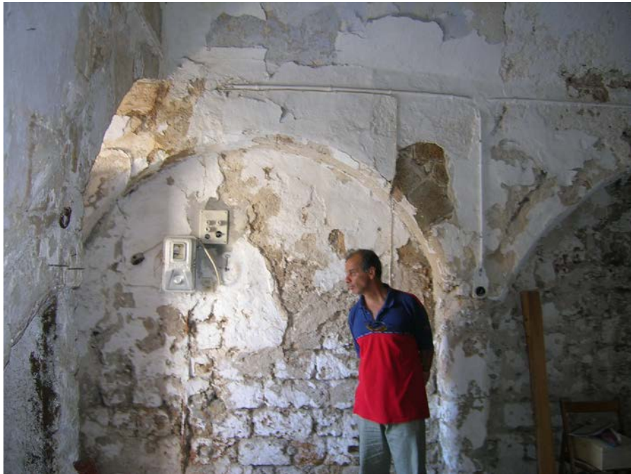
Φωτ. 5 : Τμήμα ανατολικού τοίχου δωματίου «1»
