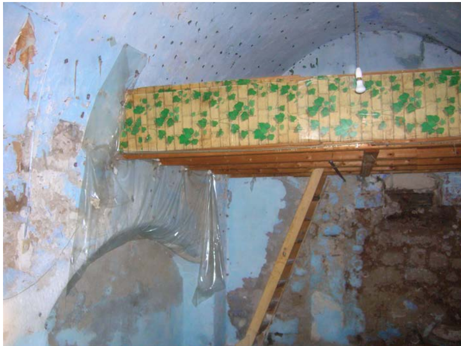
Φωτ. 7 : Θολωτή οροφή δωματίου «3» και αψίδα στον βόρειο τοίχο του .
