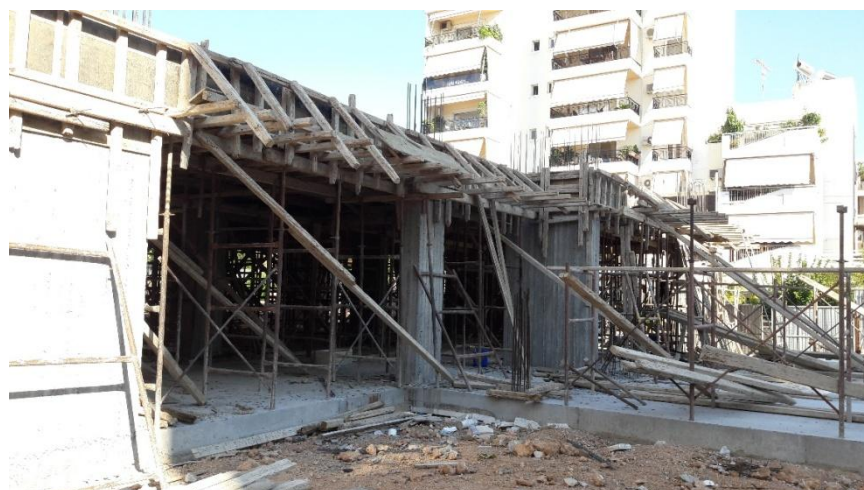
Εικ.4 Σκυροδέτηση ισογείου για την ανέγερση του βρεφονηπιακού σταθμού επί των οδών Π. Ράλλη, Κομνηνών & Αχιλλέως στη Νίκαια
