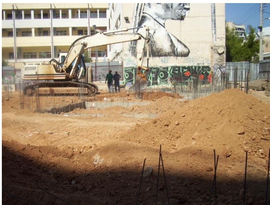
Εικ.2 Εργασίες μπαζώματος για την ανέγερση του βρεφονηπιακού σταθμού επί των οδών Π. Ράλλη, Κομνηνών & Αχιλλέως στη Νίκαια
