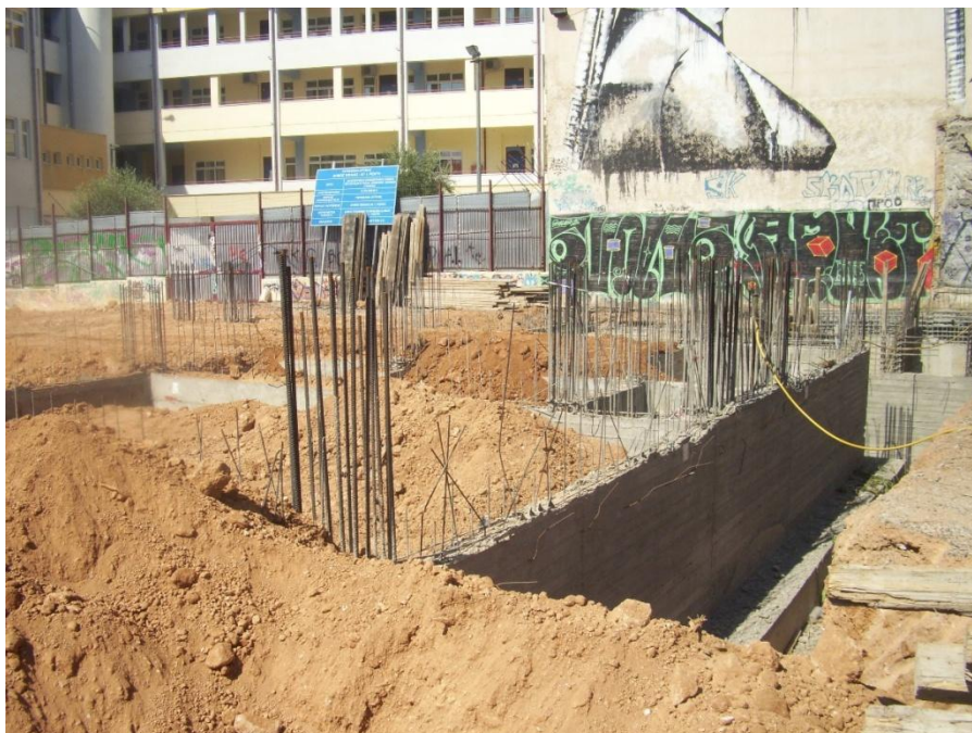
Εικ.1 Εκσκαφές και μπάζωμα για την ανέγερση του βρεφονηπιακού σταθμού επί των οδών Π. Ράλλη, Κομνηνών & Αχιλλέως στη Νίκαια
