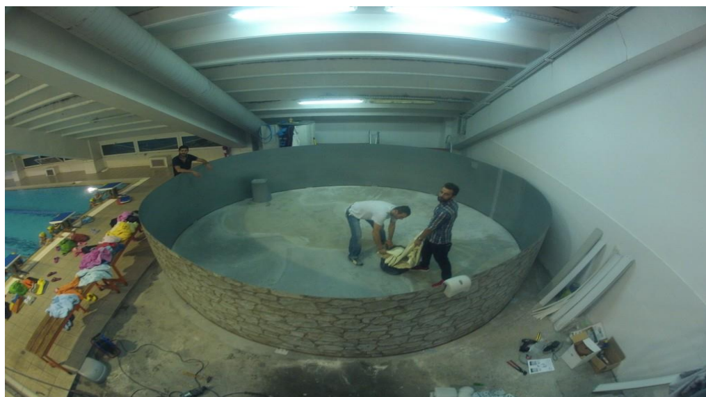
Εικόνα 2.5 Υπέργειες πισίνες: στήσιμο τοιχωμάτων
