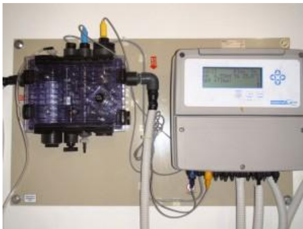
Εικόνα 3.23 Δοσομετρική αντλία ελέγχου pH, η οποία διαθέτει ρύθμιση παροχής (0+100%) και διπλή βαλβίδα PTFE
