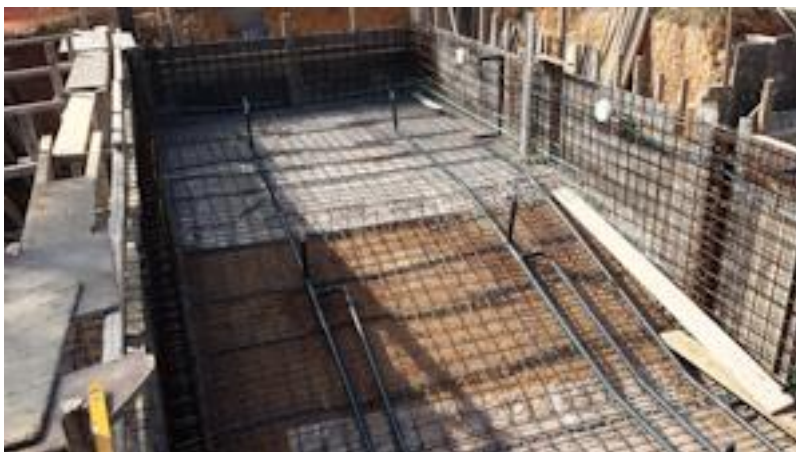
Εικόνα 1.1. Υπό κατασκευή πισίνα οπλισμένου σκυροδέματος
