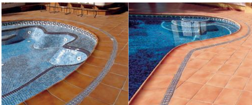
Εικόνα 3.3 Επένδυση εξωτερικού χώρου της πισίνας, με πλακάκι
