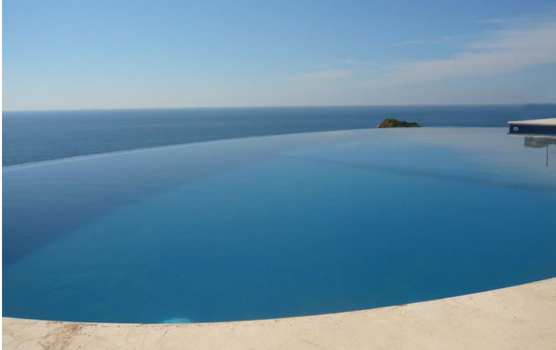
Εικόνα 1.5 Πισίνα με πλευρικό κανάλι υπερχείλισης
