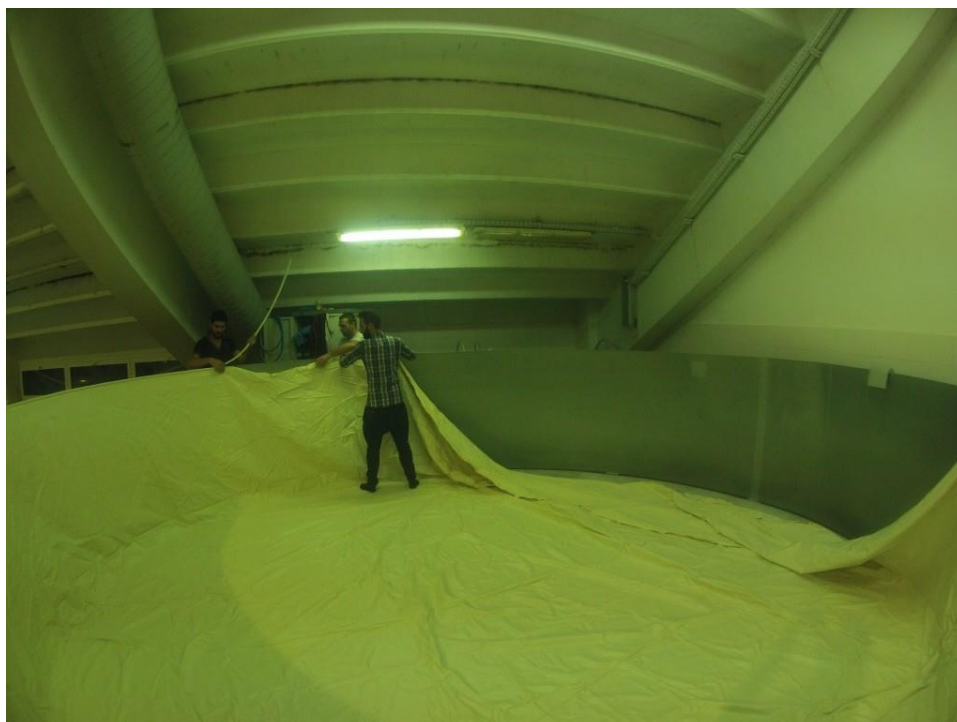
Εικόνα 2.6 Υπέργειες πισίνες: τοποθέτηση liner
