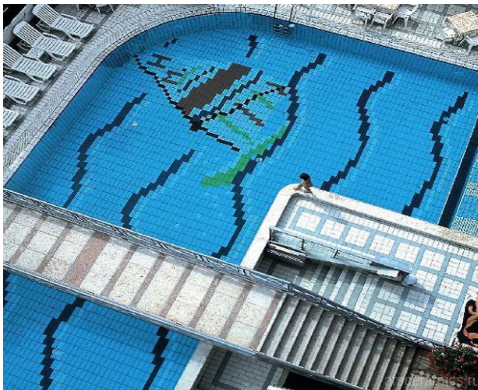
Εικόνα 3.4 Επένδυση εσωτερικού χώρου της πισίνας με πλακάκι
