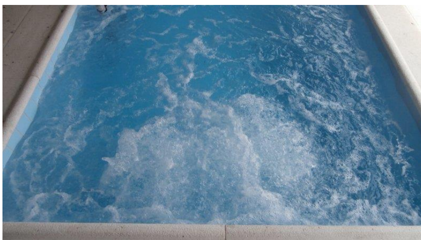
Εικόνα 3.33 Άποψη διαδρόμου για αερομασάζ
