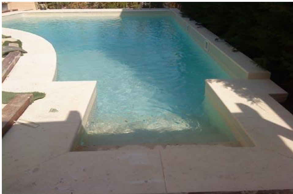
Εικόνα 3.6 Επένδυση πισίνας με Liner
