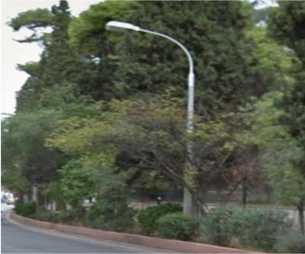
Εικόνα 3.23 Φωτιστικό σώμα στα 12 μέτρα, τύπου semi cutoff, σε μονόπλευρη διάταξη επί της λεωφόρου Δεκελείας, με φωτεινή πηγή Na 400 Watt
