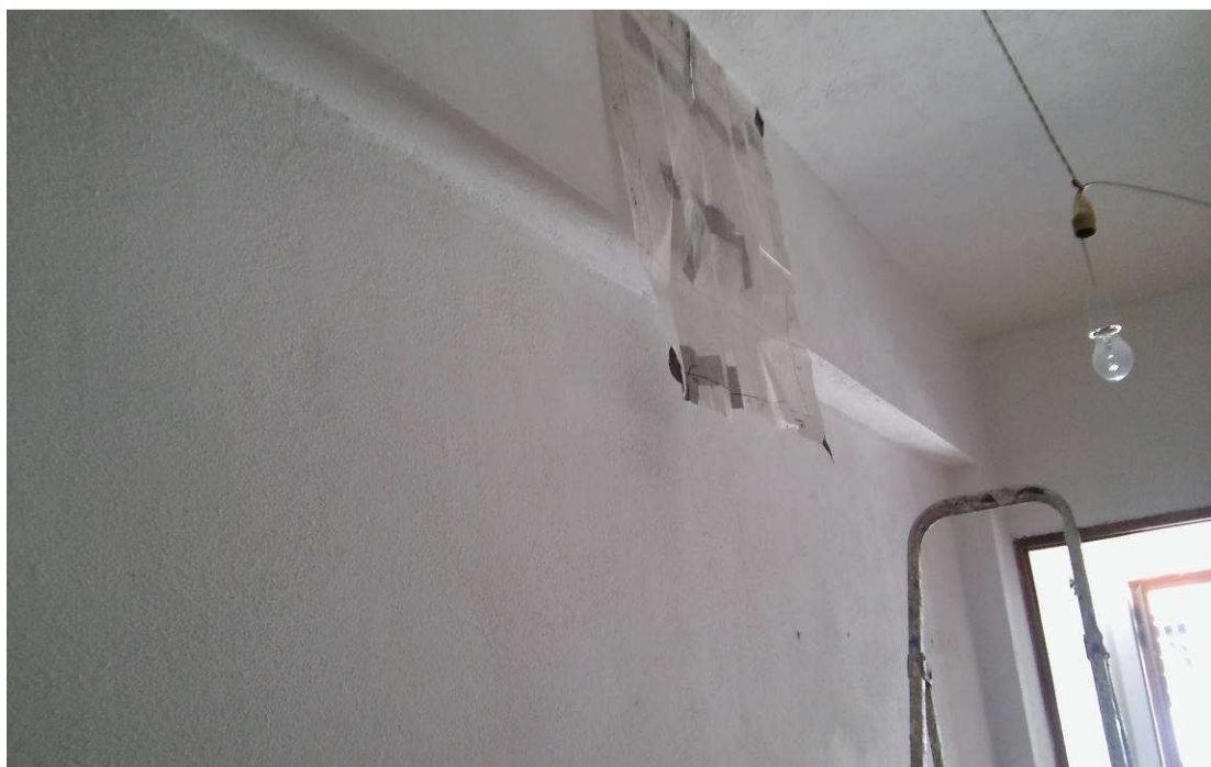
Εικόνα 41. Μembrάνη αποτύπωσης οπλισμού στο Δ1
