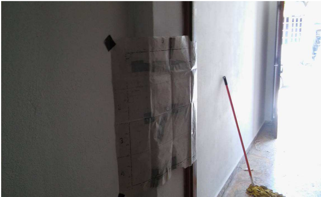
Εικόνα 35. Μεμβράνη αποτύπωσης οπλισμού στο K5
