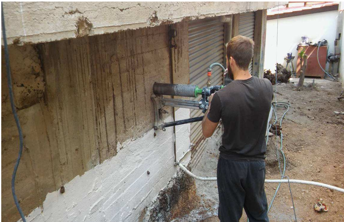
Εικόνα 28. Αποκοπή πυρήνων σκυροδέματος
