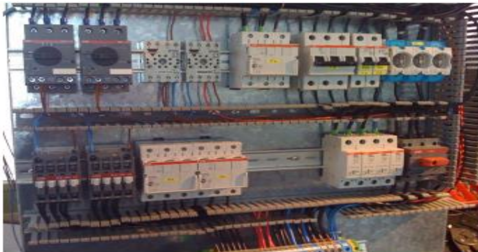
Εικόνα 1.3:Πίνακας αυτοματισμού με ενσύρματη λογική
