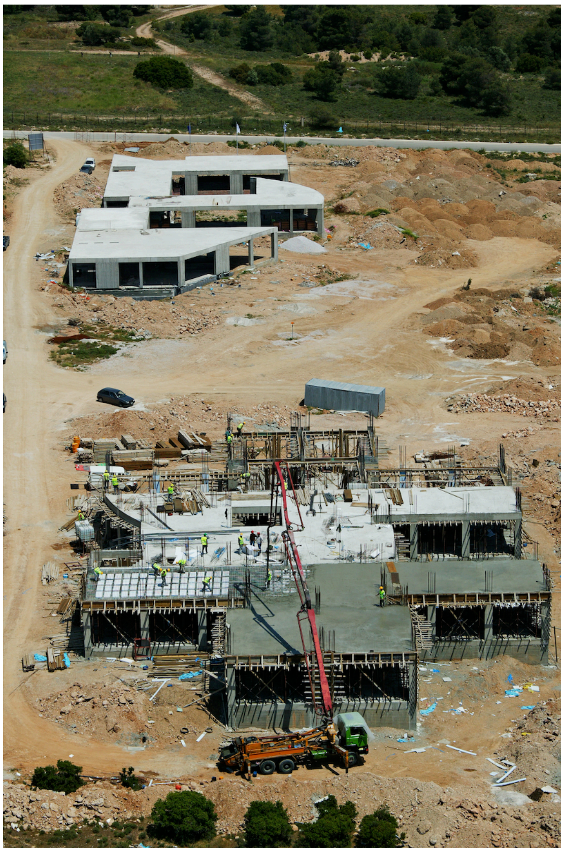
Εναέρια λήψη φωτογραφίας κατά την εργασία σκυροδέτησης. Φαίνεται ότι πληρούνται τα μέτρα ασφαλείας.
