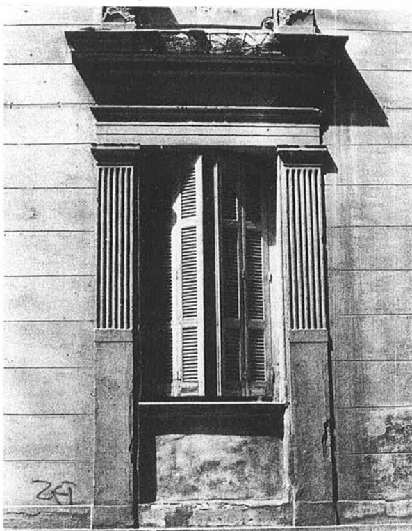
Εικ. 7 Εφαρμογή παραστάδων με ραβδώσεις, στη πλαisiώση παραθύρου. .(πηγή εικόνας βιβλίο «Μισός αιώνας Αθηναϊκής Αρχιτεκτονικής 1875-1925»Μπίρης Μάνος)σελ.90
