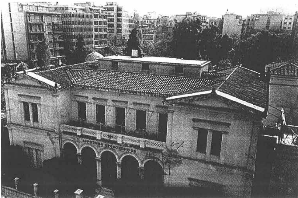
Φωτ. 6. Η στέγη του Βρεφοκομείου πριν από την αφαίρεση του επικτίσματος. Διακρίνονται επίσης δεξιά τα δώματα και παλαιά στηθαία του δυτικού πλευρικού γκισματος, ο κεραμοσκεπής βρεφικός σταθμός της νοτιοδυτικής πλευράς της Πλατείας Ελευθερίας και στο βάθος αριστερά ο τρούλλος του ναού των Αγ. Αναργύρων (Αρχείο ΥΠΠΟ/ΔΗΚΑΝΜ).
