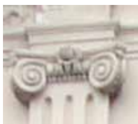
Λεπτ.1 Πεσσός με Κιονόκρανο Ιωνικού ρυθμού. (τρεις κάθετες σκοτιές, αντί τις ραβδώσεις)
