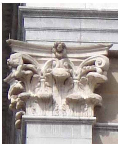
Λεπτ. 1 Πεσσός με Κιονόκρανο Κορινθιακού ρυθμού.
