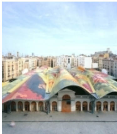
Εικ.4 Άνοψη Στέγης
