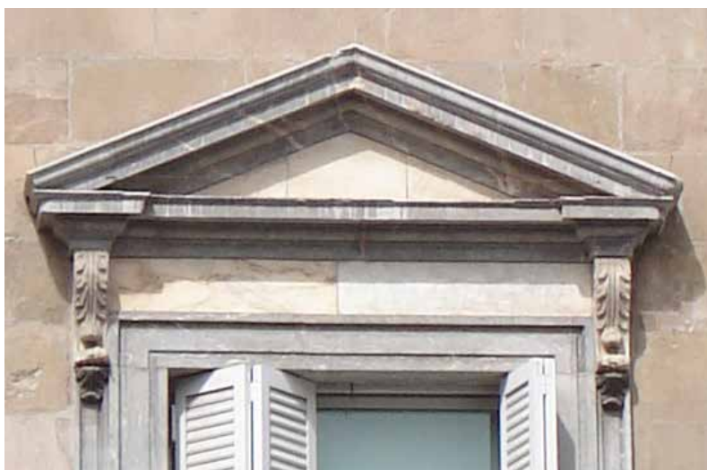
Λεπτ.5 Αέτωμα που στολίζει το πρέκι του παραθύρου, απλό χωρίς κυμάτια ή οδόντες.
