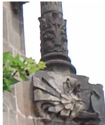
Λεπτ. 3 Βάση με στολισμένη με άνθη και διπλή σπείρα, και πλίνθο μικρότερο από τη διατομή της βάσης.
