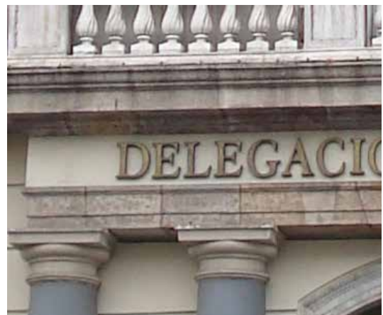
Λεπτ.7 Θριγκός Δωρικού ρυθμού Χωρίς ζωφόρο και δυο ζώνες στο επιστύλιο. Δωρικό Κιονόκρανο.
