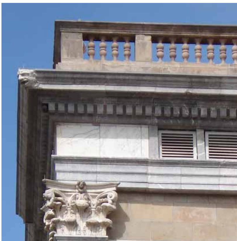
Λεπτ.6 Θριγκός με επιστύλιο που έχει τρεις ζώνες, έλλειψη ζωφόρου, και γείσο με οδόντες. Υπάρχει σίμη, που εμποδίζει τα νερά να υπερχειλίζουν και μια κεφαλή με μορφή υδρορροής.
