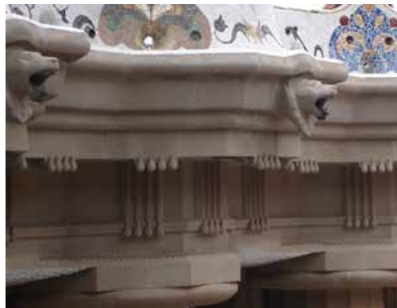
Λεπτ. 3 Θριγικός Δωρικού ρυθμού, χωρίς γείσο και εμφανείς σταγόνες στο επιστύλιο. Και λεοντοκεφαλή μορφή υδρορροής.
