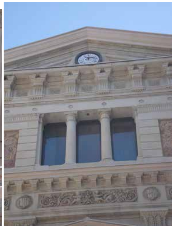
Λεπτ.2 Αέτωμα, θριγκός με τεράστιους οδόντες και τύμπανο.
