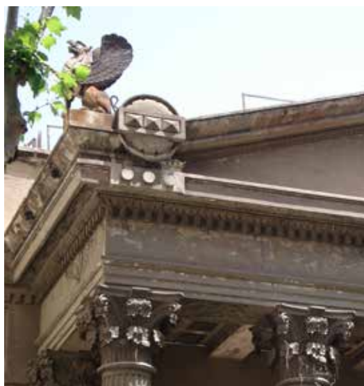
Λεπτ. 4 Θριγκός και Αέτωμα Κορινθιακού ρυθμού
