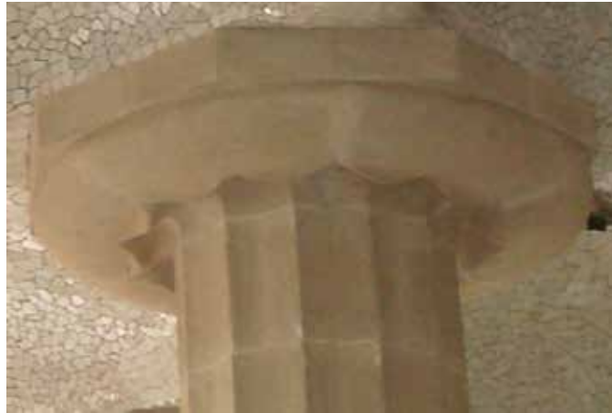
Λεπτ.1 Κολώνα Δωρικού ρυθμού, με διαφοροποίηση στο εχινό και χωρίς μάντα.
