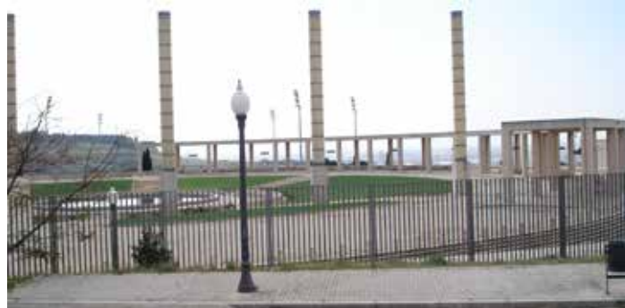
Εικ. 3 Στοά με κιονοστοιχία σε εξωτερική αυλή.
