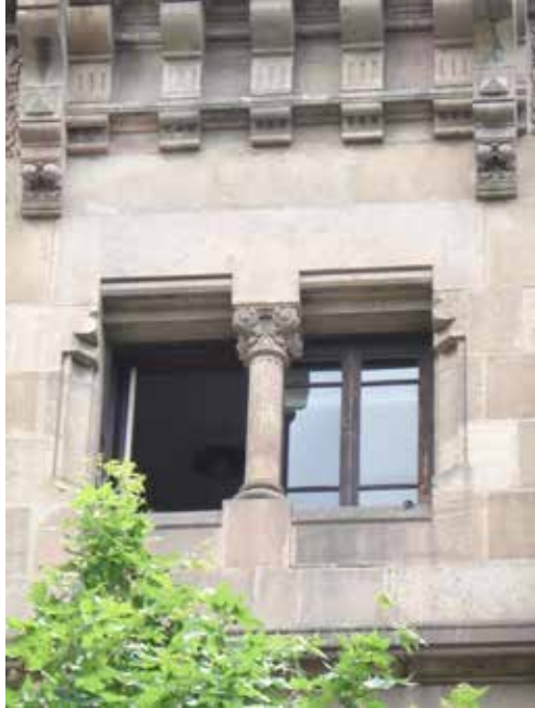
Εικ. 2 Κολώνα Ιωνικού ρυθμού και θριγκός Δωρικού ρυθμού.
