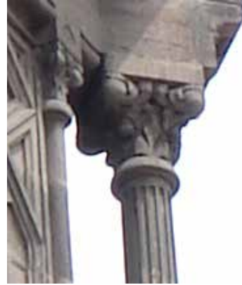
Λεπτ.2 Κιονόκρανο Ιωνικού ρυθμού με αντικατάσταση του έλικα.
