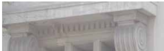
Λεπτ.2 Οδόντες στο κάτω μέρος του μπαλκονιού.
