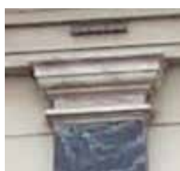
Λεπτ. 3 Πεσσός με Κιονόκρανο Δωρικού ρυθμού. (τετραγωνισμένος εχινός)
