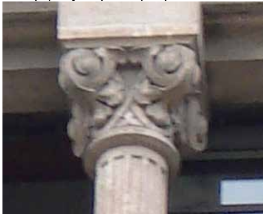
Λεπτ. 1 Κιονόκρανο Ιωνικού ρυθμού με παραλλαγή αντί για έλικες έχει στις τέσσερις γωνίες σφαιρίδια ντυμένα με φύλλα.
