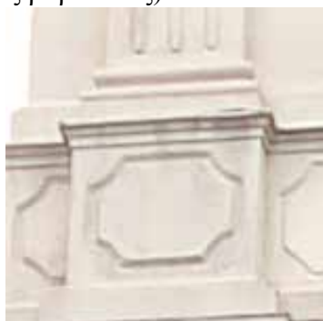
Λεπτ. 2 Βάση με διπλή Σπείρα, και διακόσμηση του Πλίνθου.
