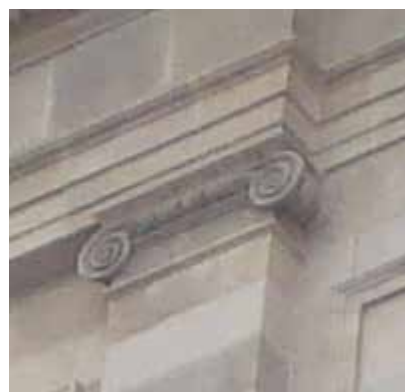
Λεπτ.1 Πεσσός και Επιστύλιο με κιονόκρανο Ιωνικού ρυθμού.
