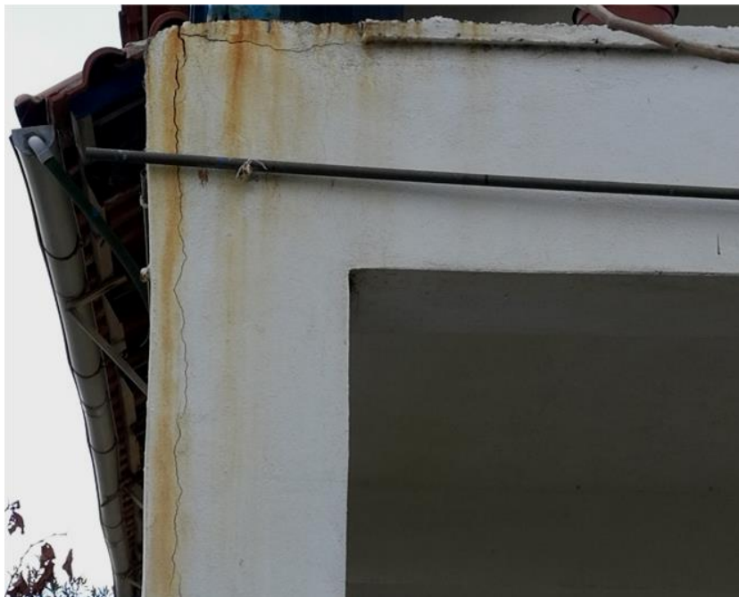
Εικόνα 3: Ρωγμές σε αυθαίρετη κατασκευή (1). Πηγή: φωτογράφιση ίδιας. όπου έχουν τραβηχτεί οι φωτογραφίες. Πηγή: Google Maps
