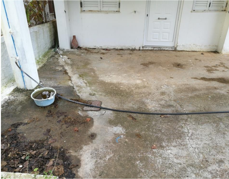
Εικόνα 17: Αυθαίρετος βόθρος σε κατοικία (1). Πηγή: φωτογράφιση ίδιας.
