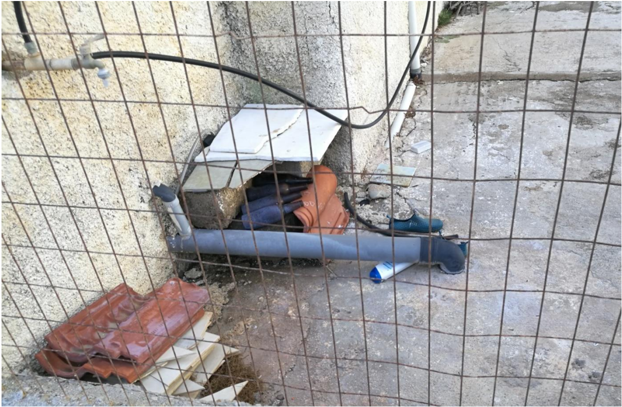
Εικόνα 20: Άμεση σύνδεση με το υπέδαφος (1). Πηγή: φωτογράφιση ίδιας.
