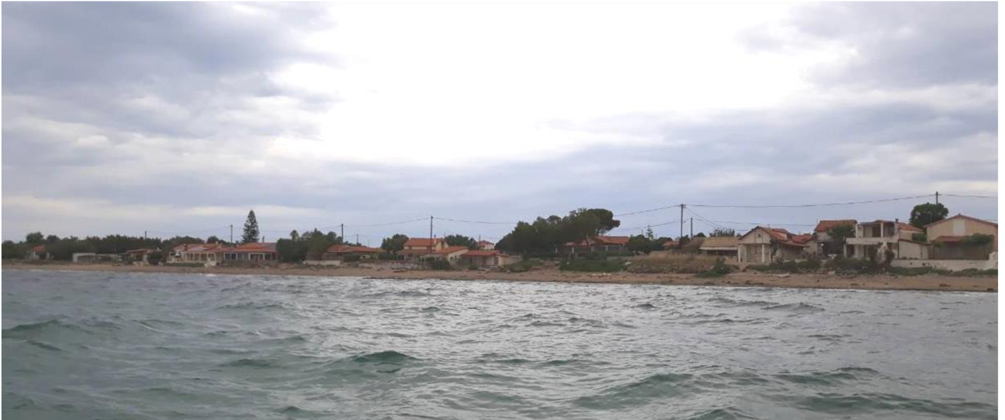
Εικόνα 10: Λήψη των αυθαιρέτων της παραλιακής ζώνης από τη θάλασσα (4). Πηγή: Προσωπικό αρχείο
