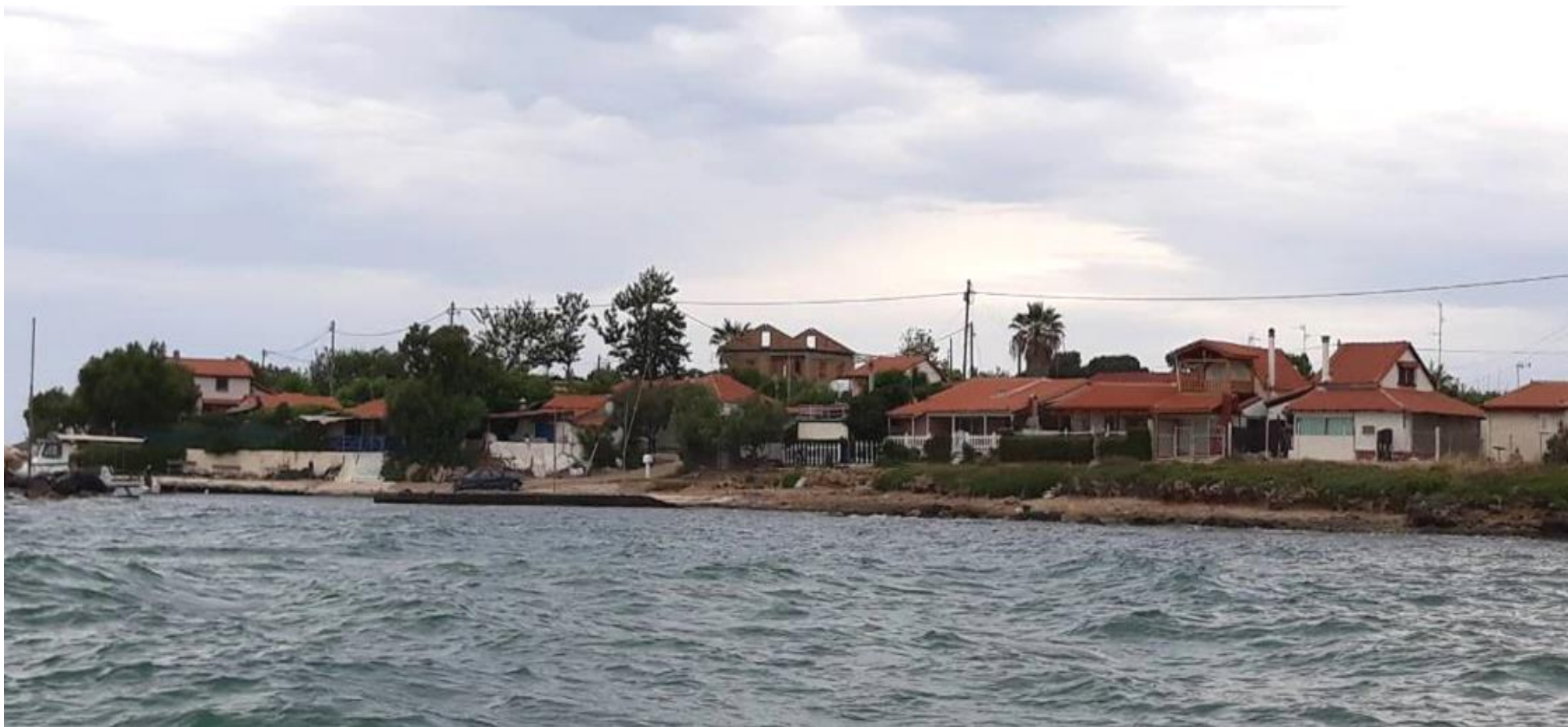
Εικόνα 8: Λήψη των αυθαιρέτων της παραλιακής ζώνης από τη θάλασσα (2). Πηγή: Προσωπικό αρχείο
