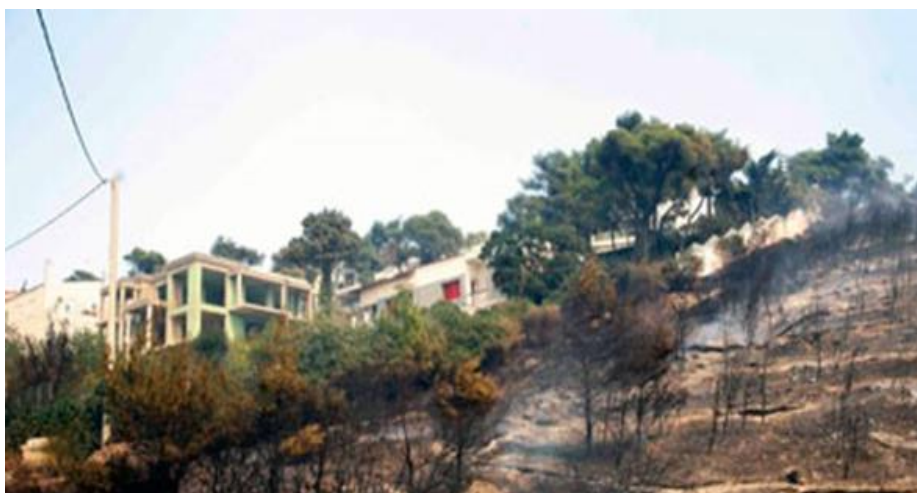
Εικόνα 2: Ανέγερση αυθαίρετων κατασκευών σε καμμένη περιοχή (2). Πηγή: www.dasarxeio.com
