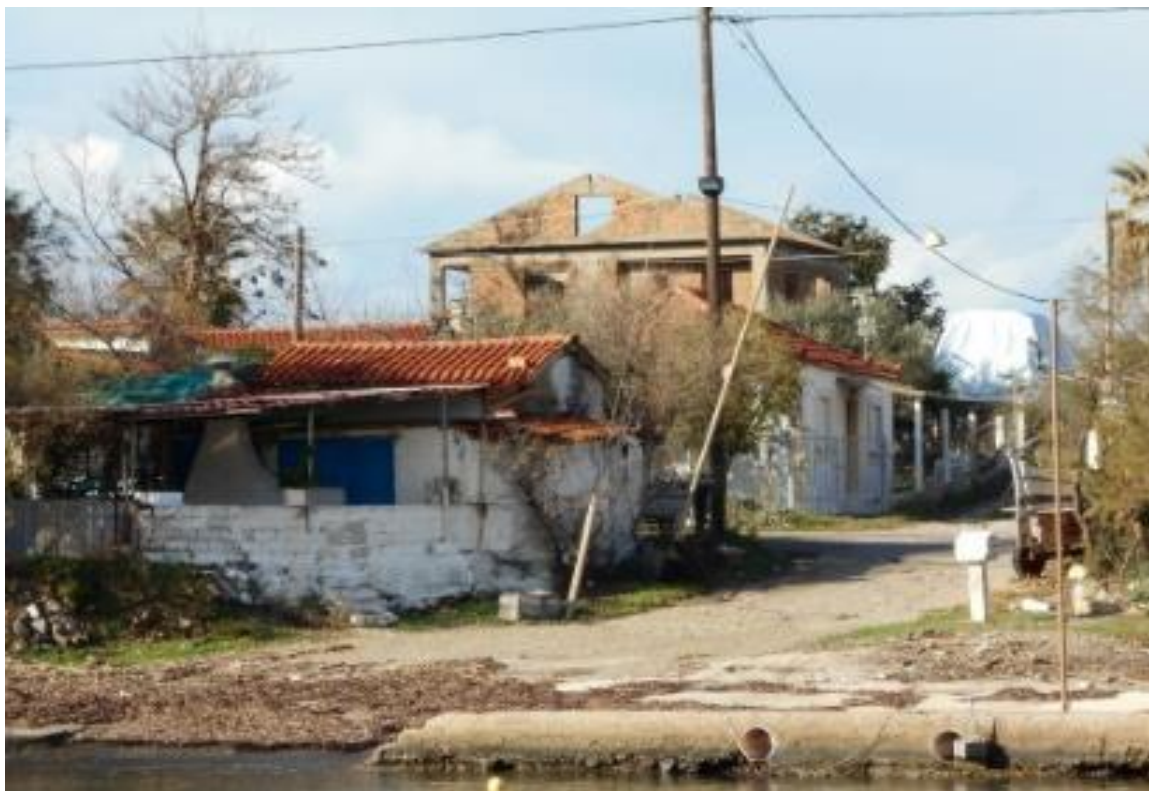
Εικόνα 26 Ανέγερση νέων αυθαίρετων κατασκευών. Πηγή: φωτογράφιση ίδιας.
