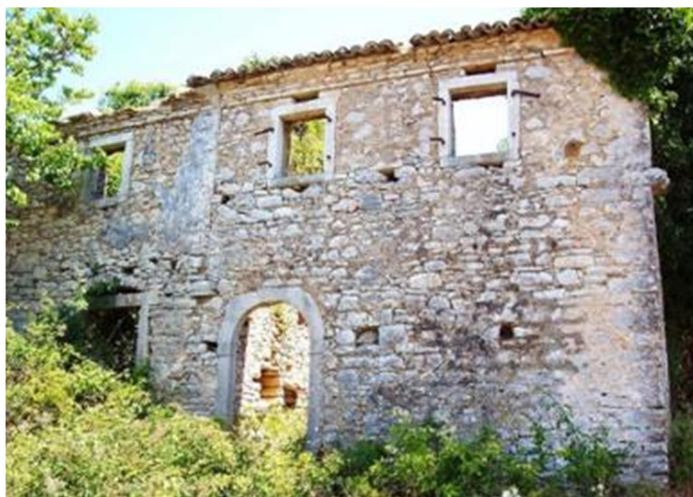
Εικόνα 1.2.1 Άοπλη τειχοποιία
