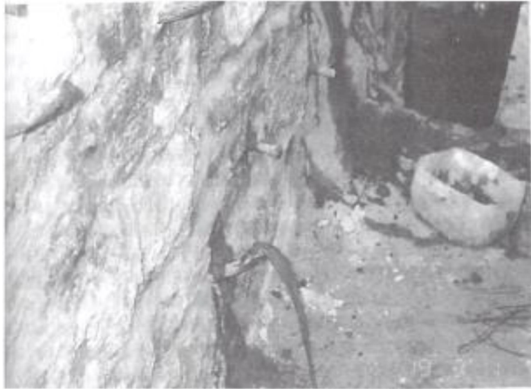
Εικόνα 6.3.3 : Ένεμα εξερχόμενο από σωληνίσκο
