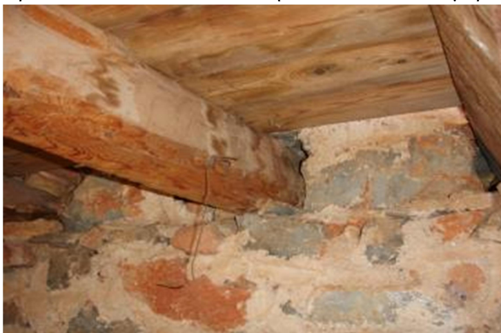
Εικόνα 5.3.2 Ενδεικτική εικόνα πατώματος
