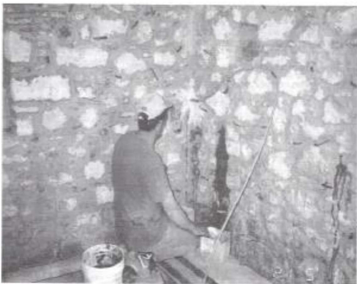
Εικόνα 6.3.1 : Τσιμεντενέσεις σε αργολιθοδομή
