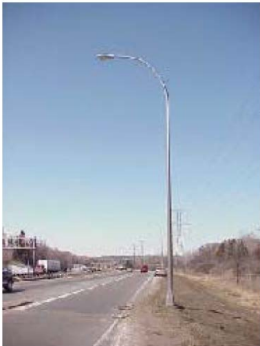
Σχήμα 115. Στύλος φωτισμού με καμπύλο βραχίονα
