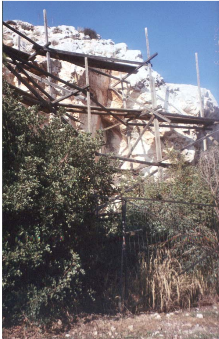
Εικόνα 38. Η στήριξη στο σημείο της κατολίσθησης
