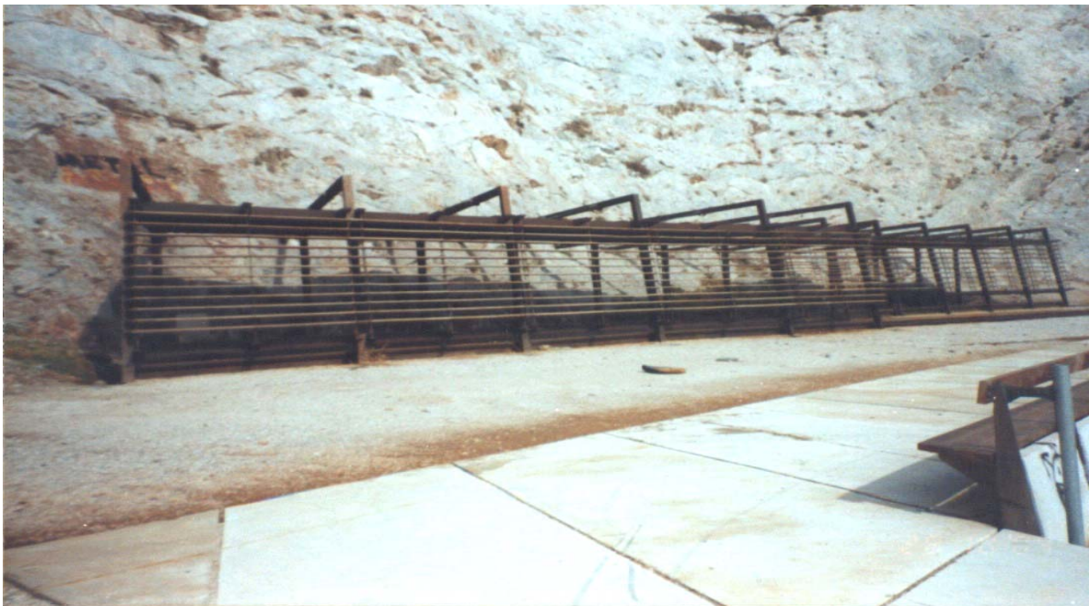
Εικόνα 7. Κατασκευές για τη λειτουργία έκθεσης γλυπτικής στο χώρο του λατομείου
