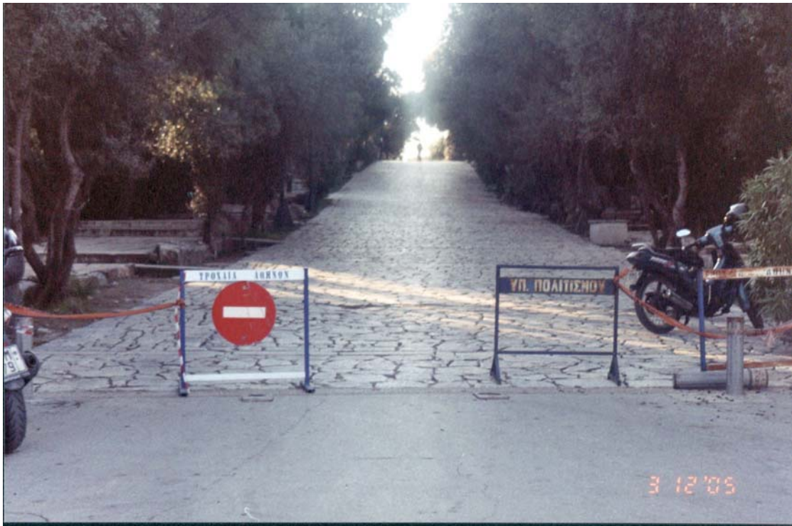
Εικόνα 34. Τα ελλιπή μέτρα προστασίας του πλακόστρωτου από τη διέλευση των τροχοφόρων
