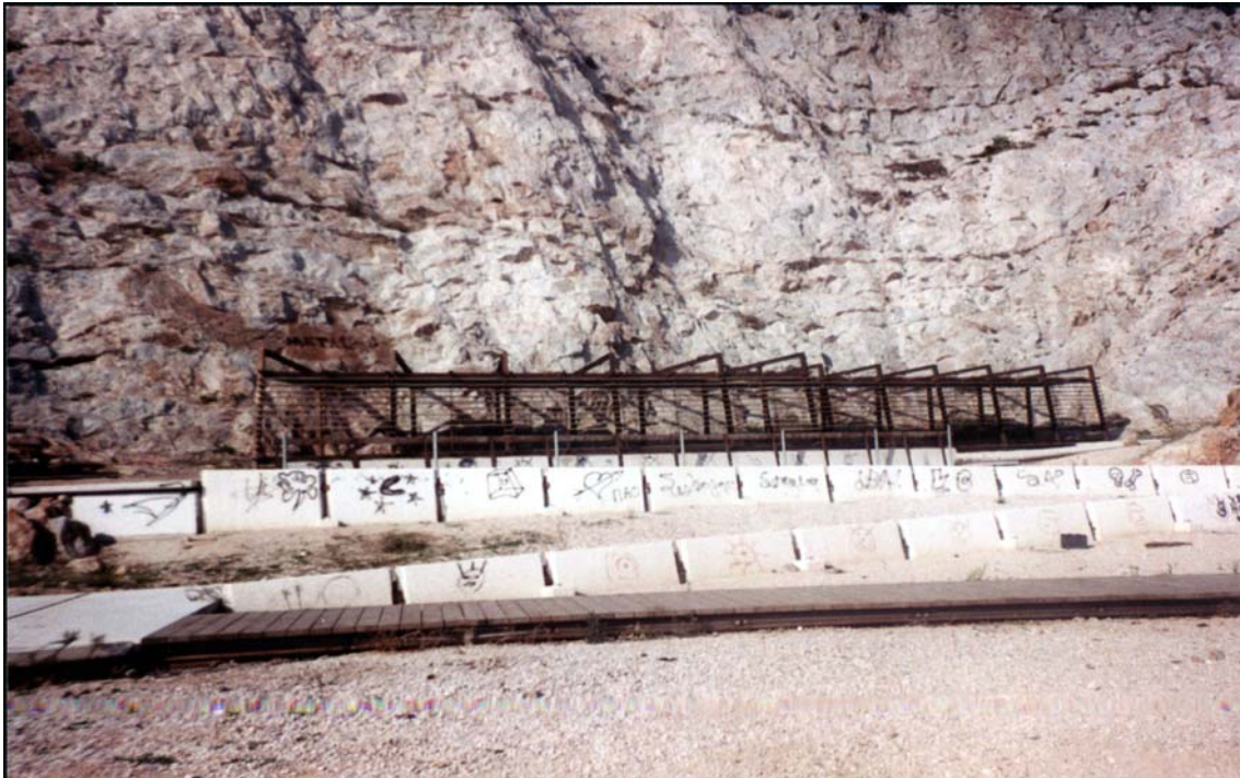
Εικόνα 6. Κατασκευές για τη λειτουργία έκθεσης γλυπτικής στο χώρο του λατομείου
