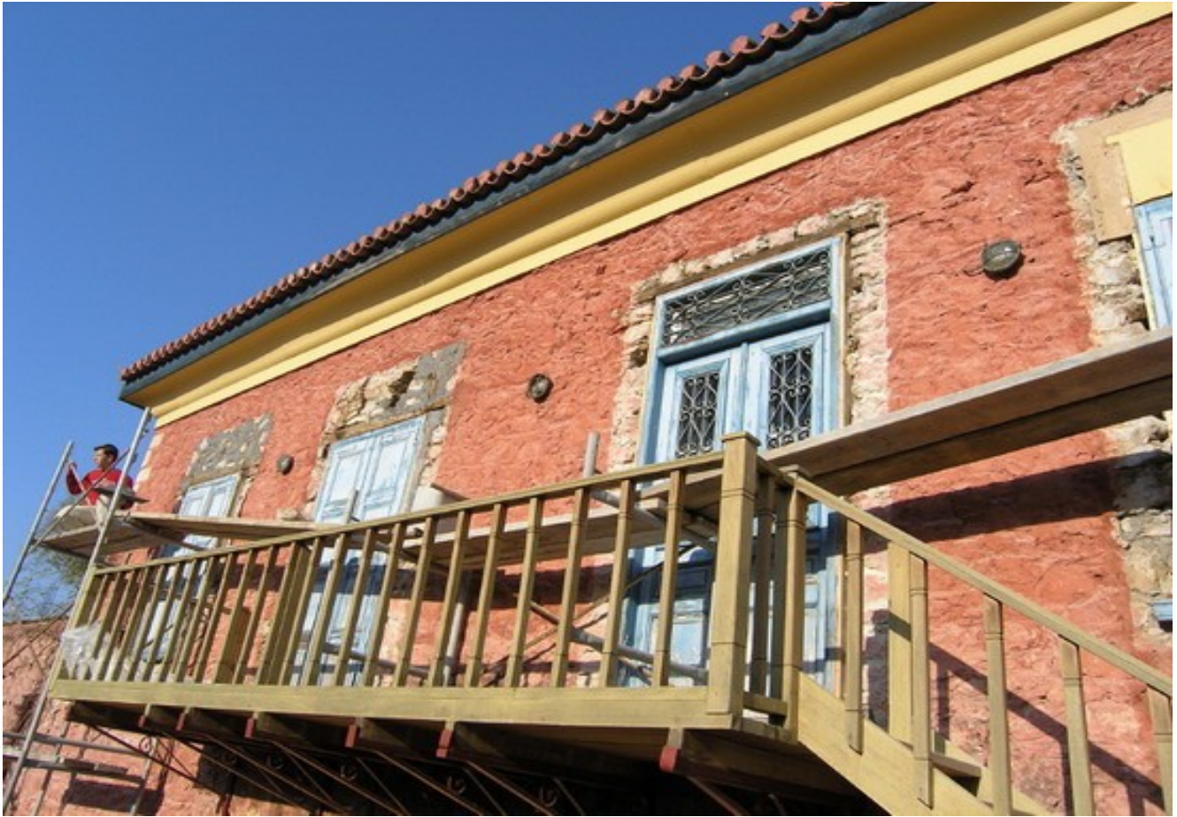
Εικόνα 73 : Εικόνα της οικίας κατά της διαδικασίες αποκαταστάσεως της. Πηγή : http://atreas-ate.gr
