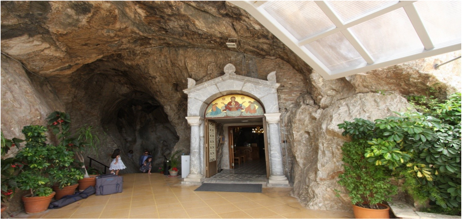
Εικόνα 196 : Είσοδος Ιερού Ναού Ζωοδόχου πηγής Κεφαλαρίου
