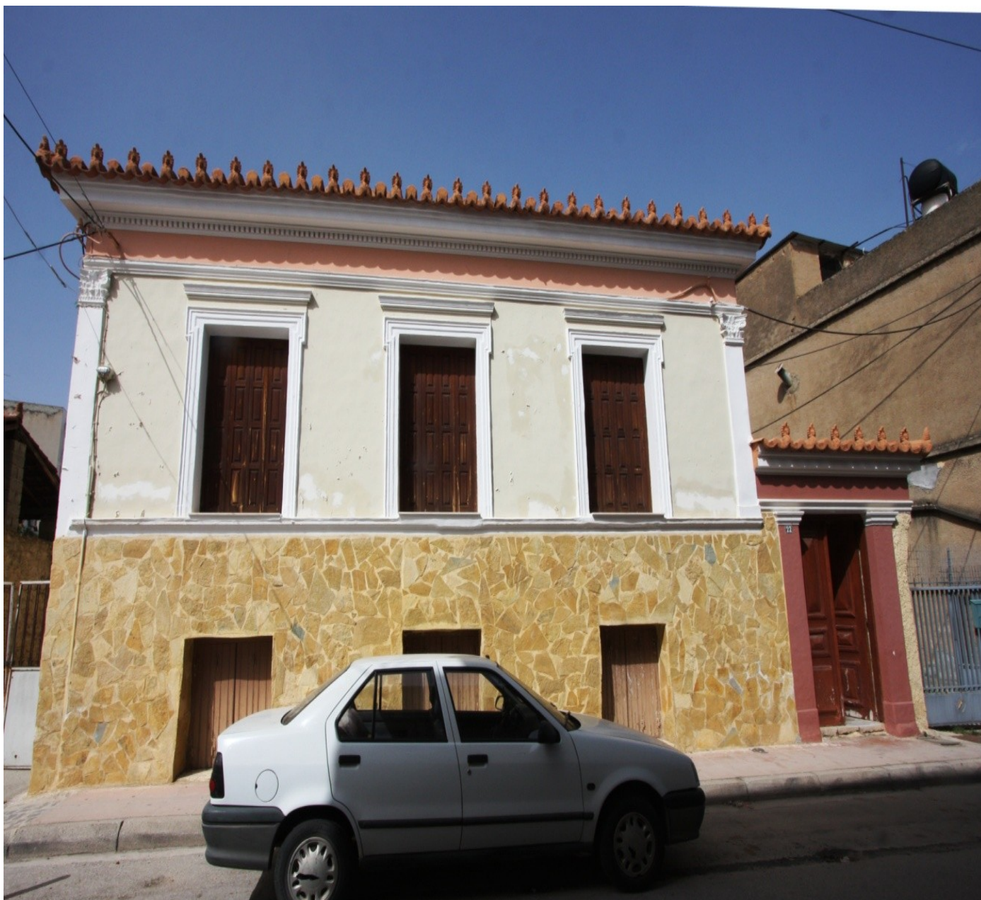
Εικόνα 82 : Όψη επί της οδού Περούκα.
