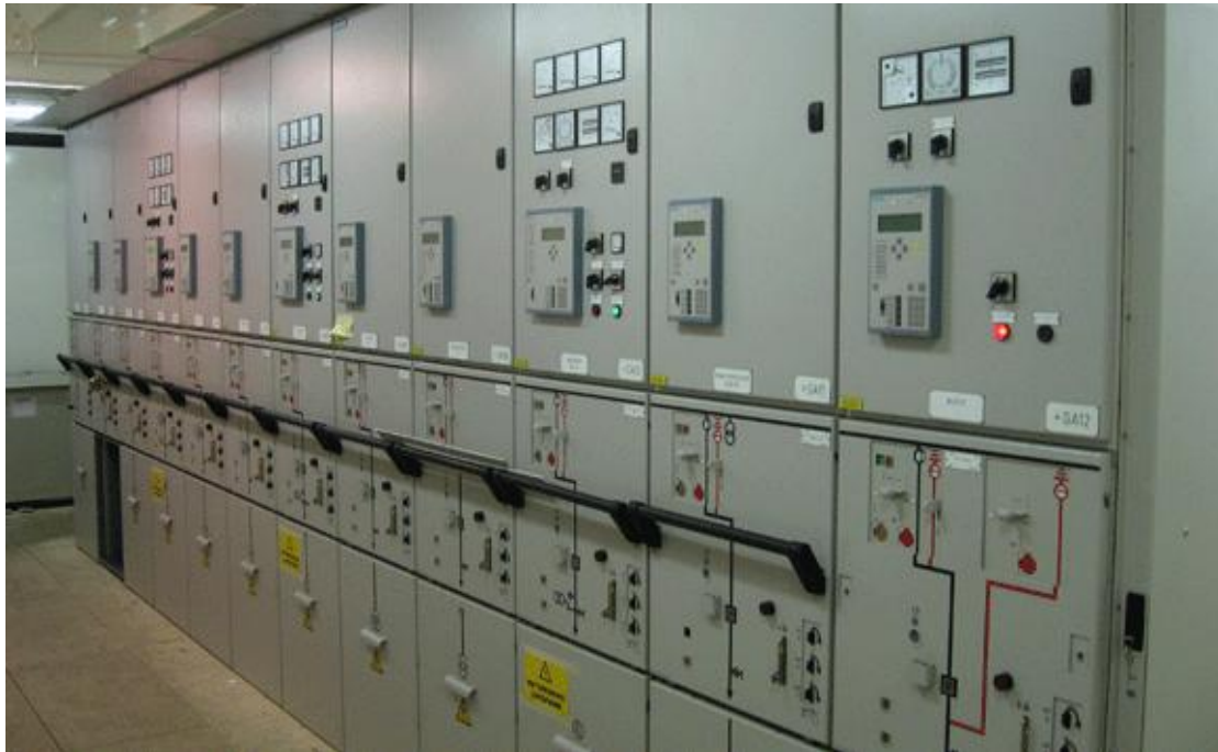
Εικόνα 9. Το ταμπλό ασφαλείας
