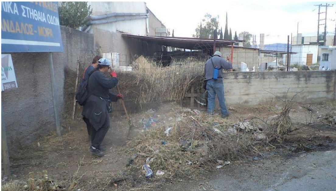
Εικόνα 12 Εργασίες αποκατάστασης προβλημάτων και αναβάθμισης της βιομηχανικής περιοχής
