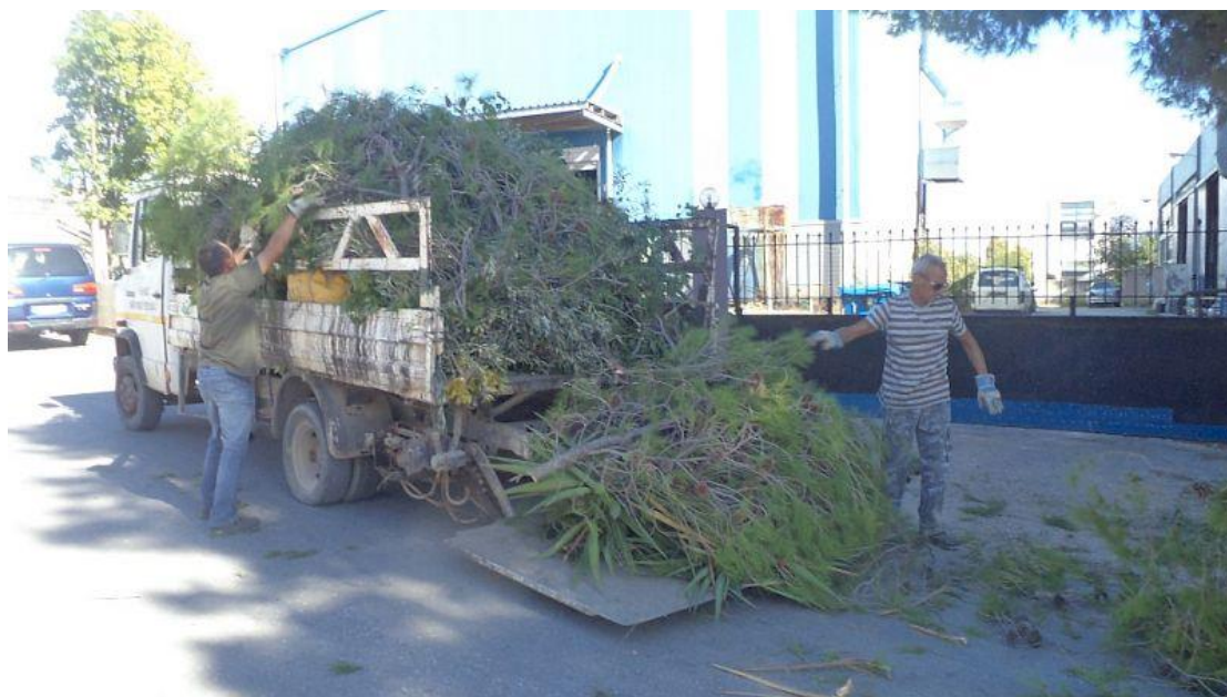
Εικόνα 11 Εργασίες αποκατάστασης προβλημάτων και αναβάθμισης της βιομηχανικής περιοχής
