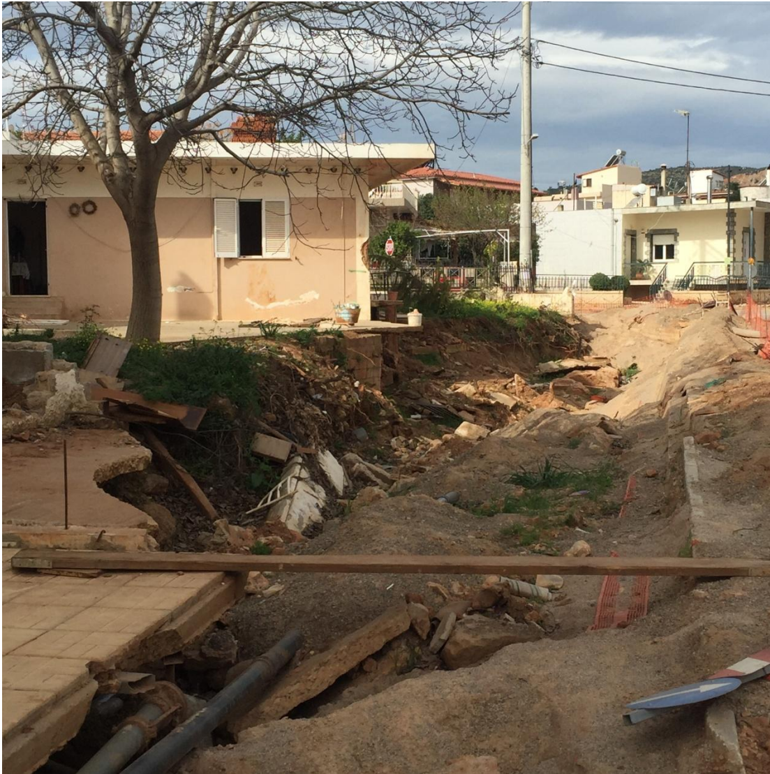
Εικόνα 43 Εργασίες συντήρησης δικτύου ύδρευσης
