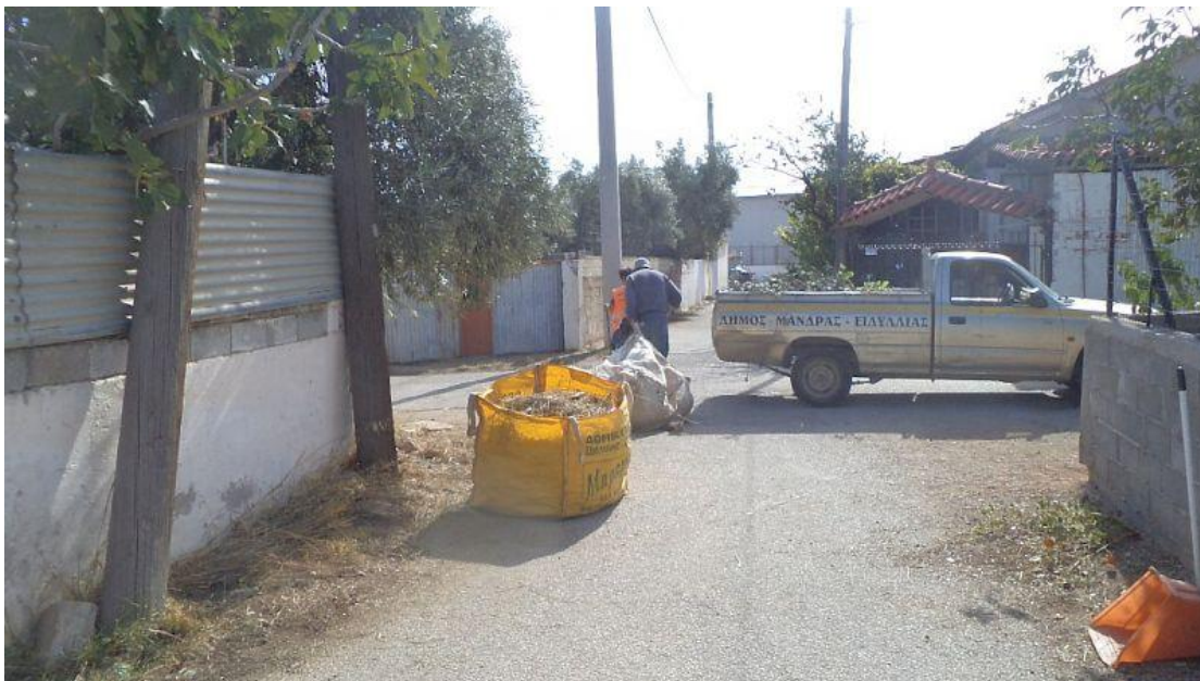
Εικόνα 13 Εργασίες αποκατάστασης προβλημάτων και αναβάθμισης της βιομηχανικής περιοχής
