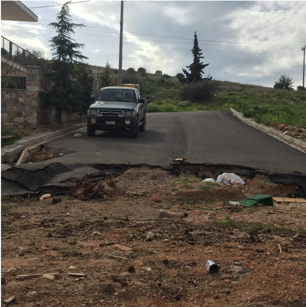
Εικόνα 42 Στοιχεία κακοτεχνίας οδικού δικτύου
