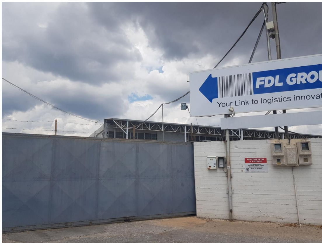
Εικόνα 10 Οι εγκαταστάσεις της εταιρείας FDLGroup βόρεια της ΠΕΟΑΚ
