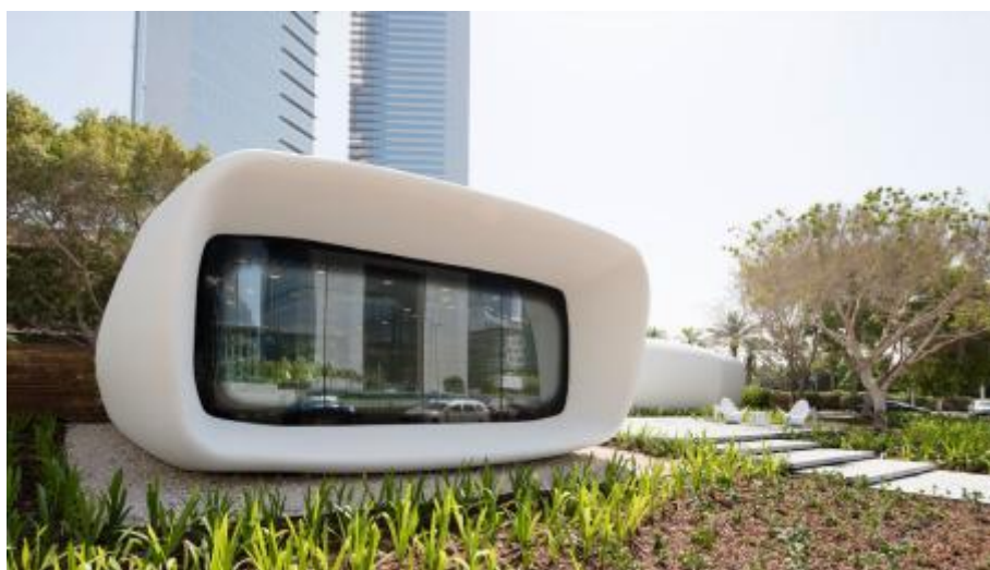
Εικόνα 43. Κατασκευή γραφείων στο Dubai από την εταιρεία Winsun
