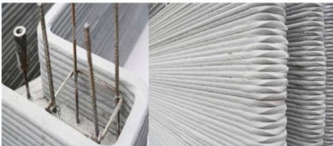
Εικόνα 33. Λεπτομέρεια όπλισης –σύνδεσης επί μέρους στοιχείων και στρώσεις εκτύπωσης πηγή: https://3dprint.com/38144/3d-printed-apartment-building/
