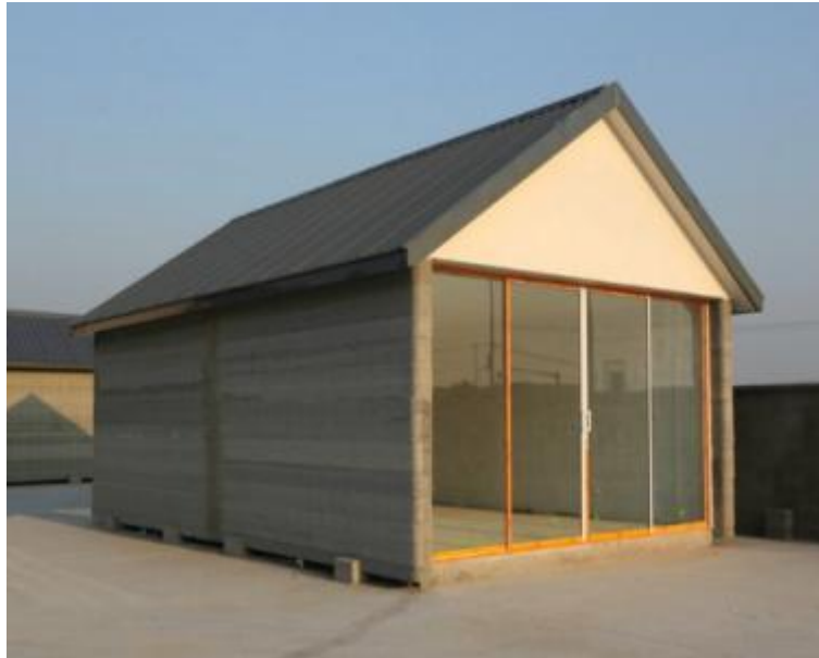
Εικόνα 38. Το πρώτο κτίριο από την εταιρεία Winsun το 2014 πηγή: https://www.treehugger.com/modular-design/more-detail-those-chinese-3d-printed-houses.html
