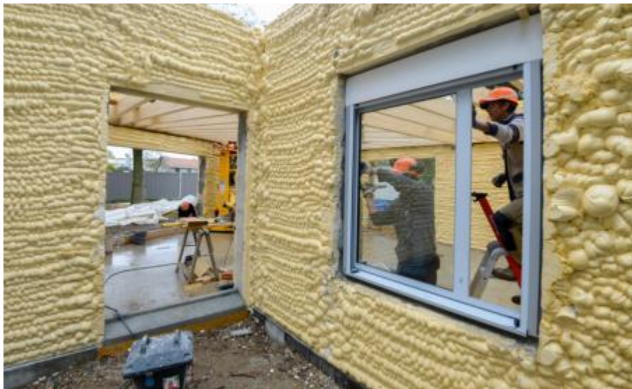
Εικόνα 59-60. Κατοικία κατά τη διάρκεια της κατασκευής στο Nantes της Γαλλίας (Μάρτιος 2018) πηγή: http://www.batiweb.com/actualites/vie-des-societes/nantes-inaugure-une-maison-construite-par-un-robot-imprimante-3d-22-03-2018-32262.html
