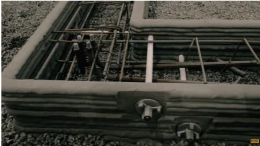
Εικόνα 49. Λεπτομέρεια όπλισης θεμελίωσης
