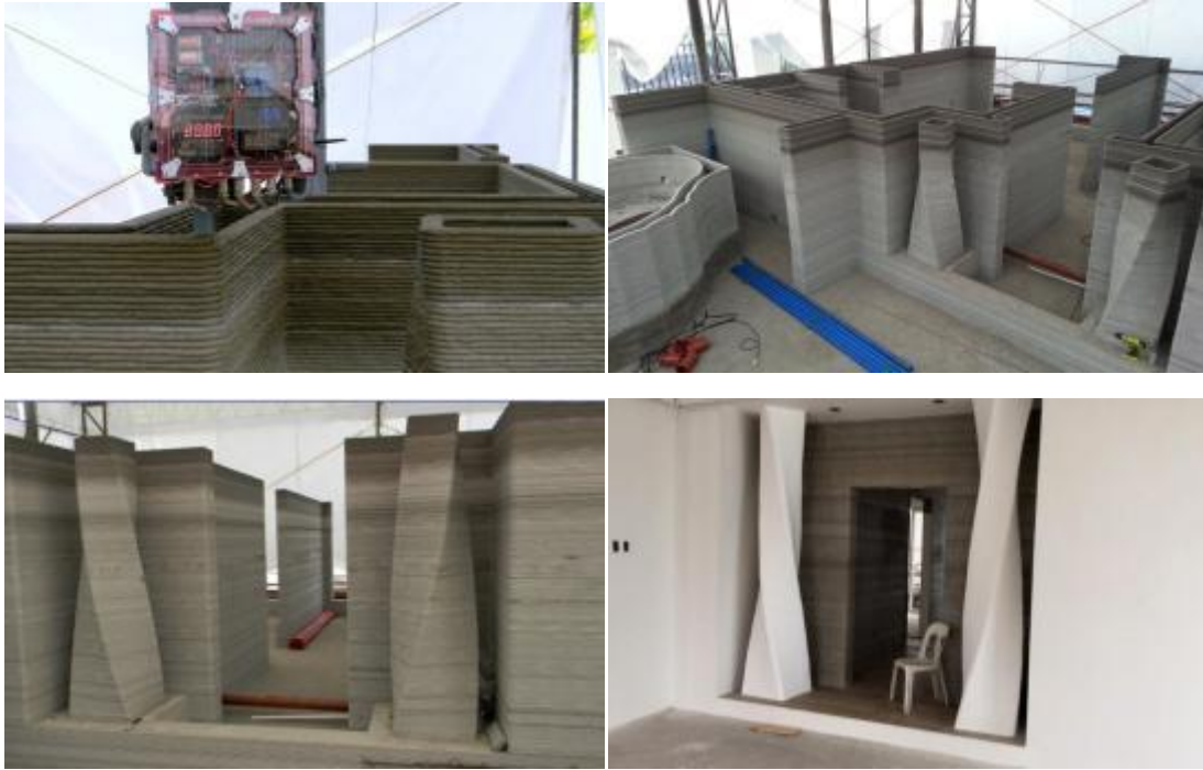
Εικόνα 26-29. Lewis Grand Hotel κατά τη διάρκεια κατασκευής από τον Andrey Rudenko πηγή: http://www.totalkustom.com/
