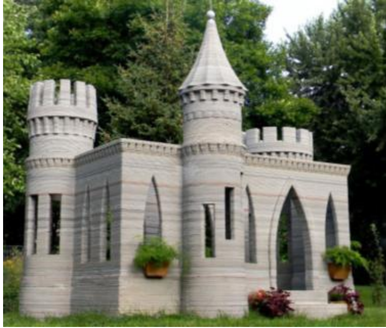
Εικόνα 25. Κατασκευή - εκτύπωση κάστρου από σκυρόδεμα ( Andrey Rudenko) πηγή: http://www.totalkustom.com/
