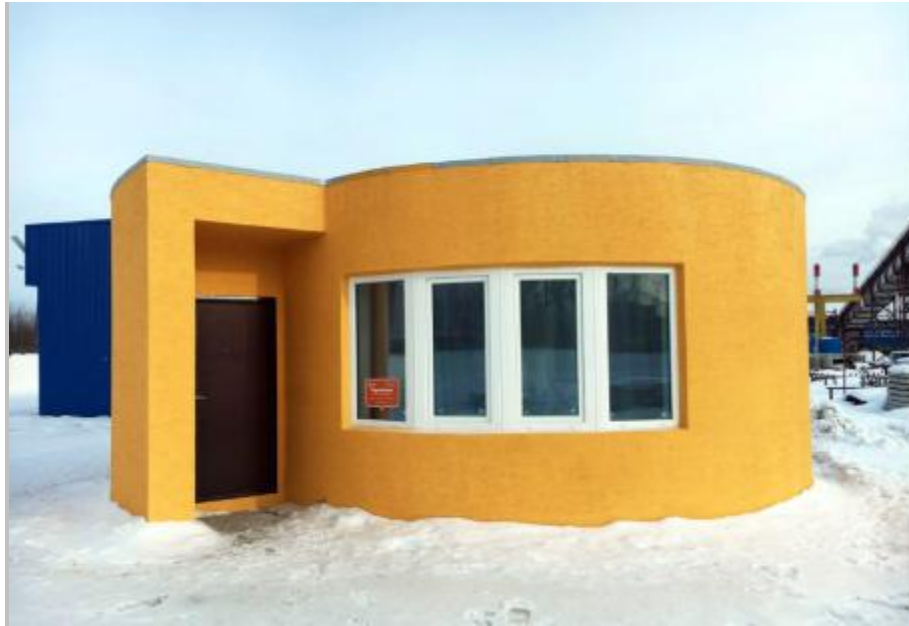
Εικόνα 56. Κατοικία στη Μόσχα μετά την ολοκλήρωση της κατασκευής Πηγή: http://www.ert.gr/eidiseis/epistimi/rosia-3d-ektypotis-echtise-spiti-se-24-ores-video/
