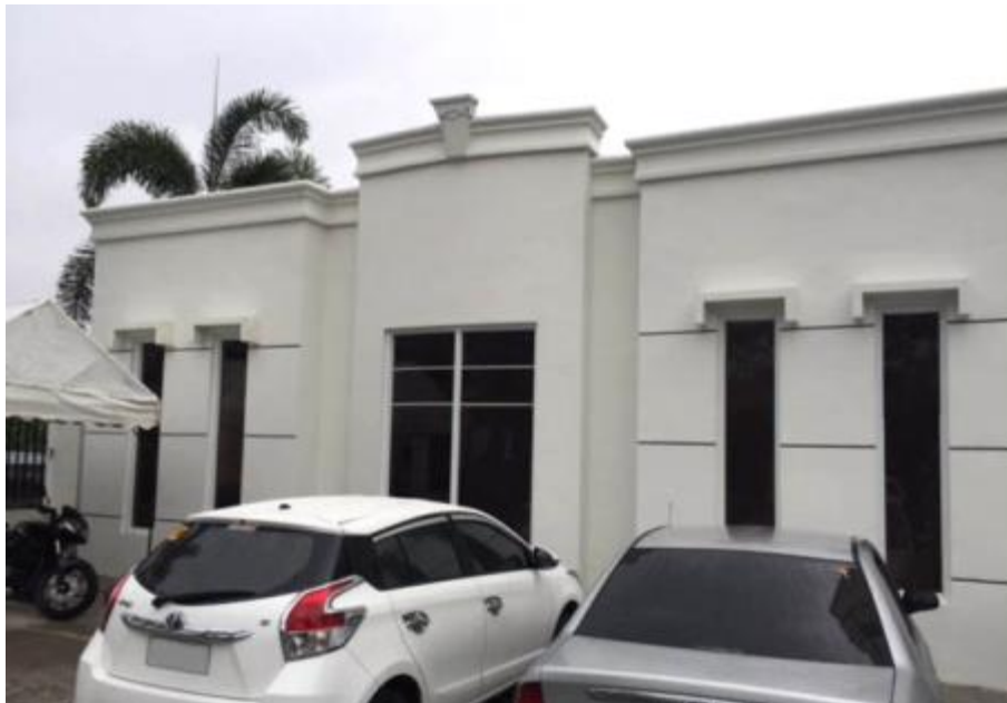
Εικόνα 30. Lewis Grand Hotel μετά την ολοκλήρωση της κατασκευής πηγή: http://www.totalkustom.com/
