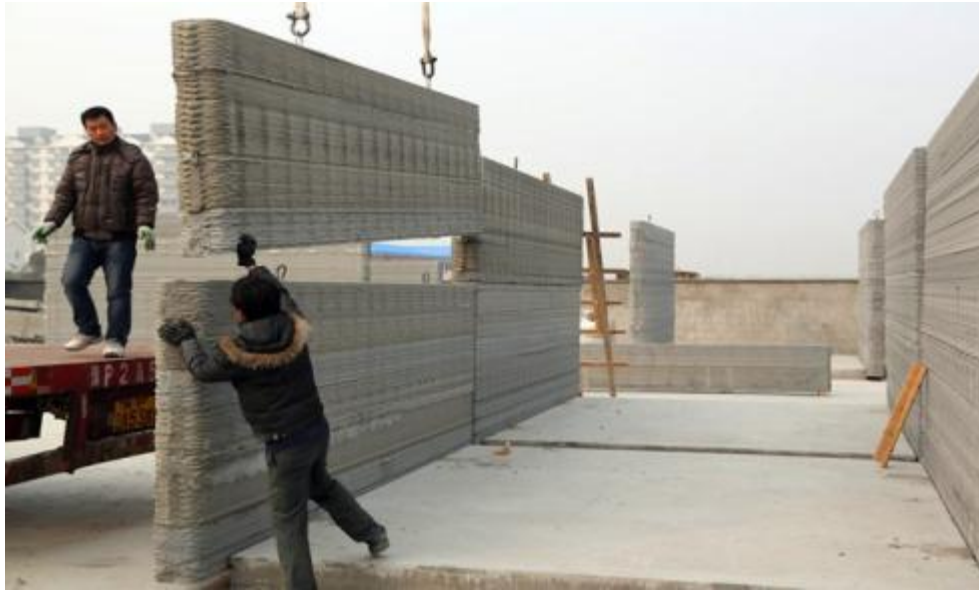
Εικόνα 35. Συναρμολόγηση επί μέρους τμημάτων Πηγή: http://www.diaforetiko.gr/eteria-tiponi-10-trisdiastata-spitia-se-ligotero-apomia-mera-ke-me-kostos-psichoula/
