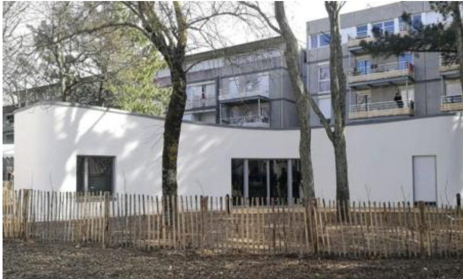
Εικόνα 61. Κατοικία μετά την ολοκλήρωση της κατασκευής στο Nantes της Γαλλίας (Μάρτιος 2018) Πηγή: http://tvxs.gr/news/eyropi-eop/proto-spiti-apo-rompotiko-3d-ektypoti-proorizetai-gia-koinoniki-stegasi-binteo
