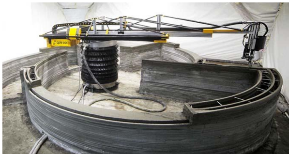
Εικόνα 15. Συναρμολόγηση σπιτιού με 3d εκτυπωτή Πηγή: https://www.otherside.gr/2017/03/etaireia-kataskeuase-spiti-me-3d-ektypwsi-mesa-se-24-wres/
