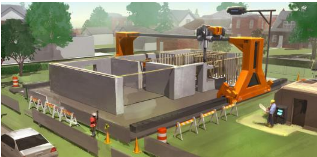
Εικόνα 24. Μέθοδος Contour Crafting για κατασκευή κτιρίων πηγή: http://contourcrafting.com/building-construction/
