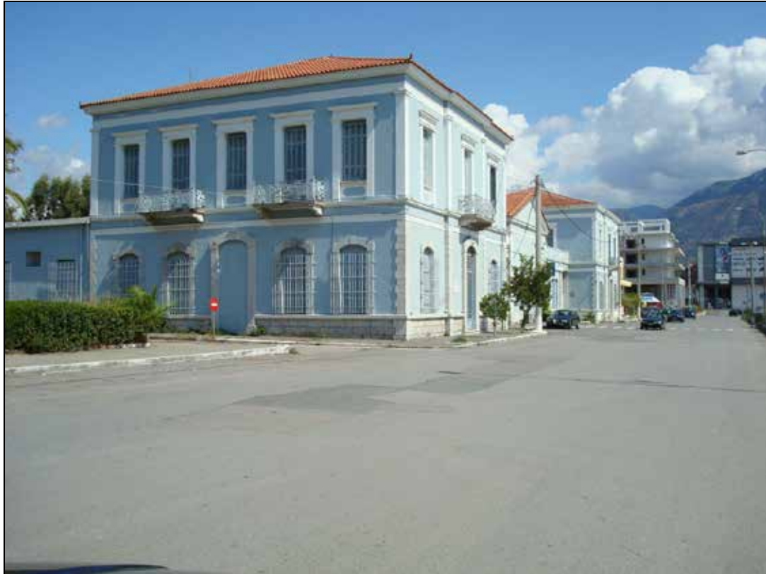
5.2 Το Λιμεναρχείο Καλαμάτας ,ακριβώς μπροστά στο Λιμάνι
