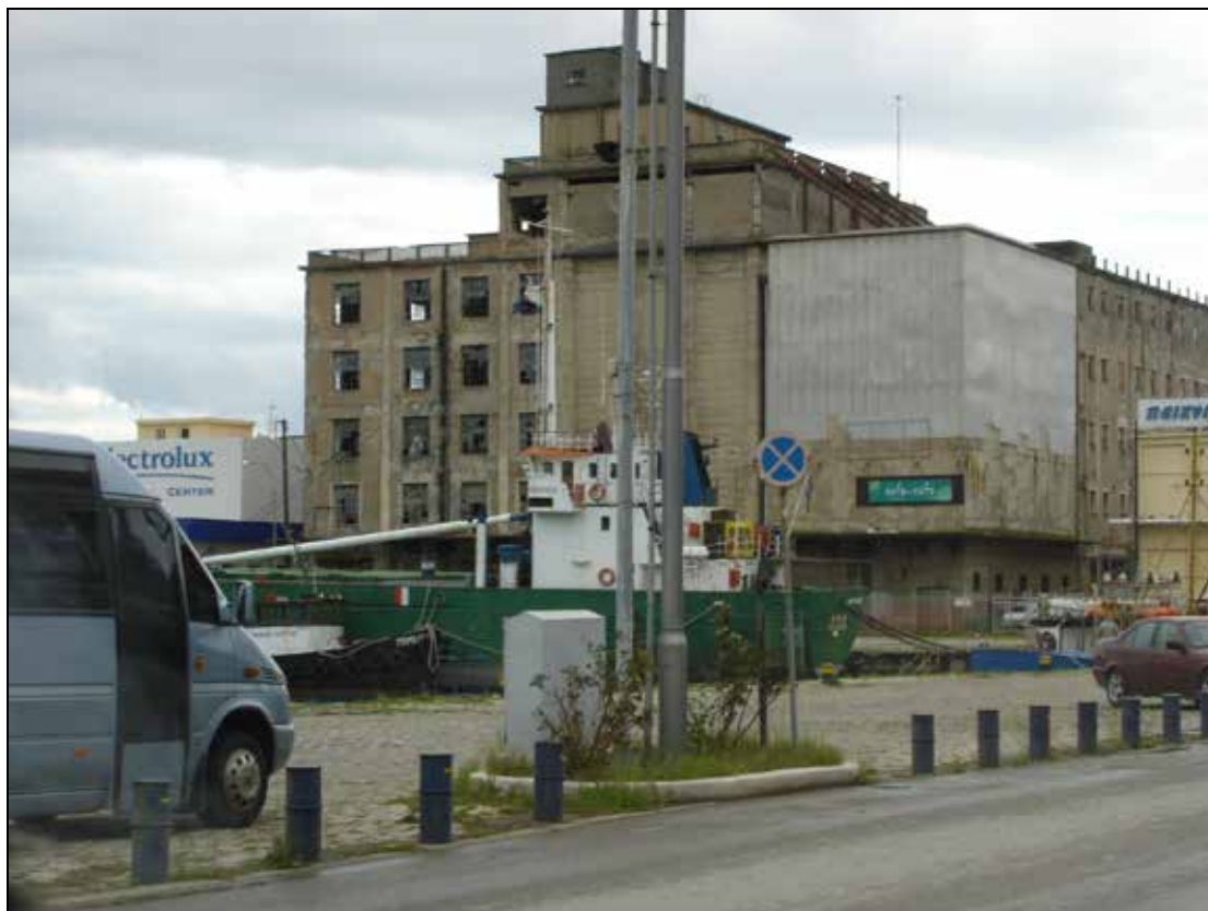
4.7 Εγκαταλλελημένα κτίρια μπροστά στο χώρο του Λιμανιού
