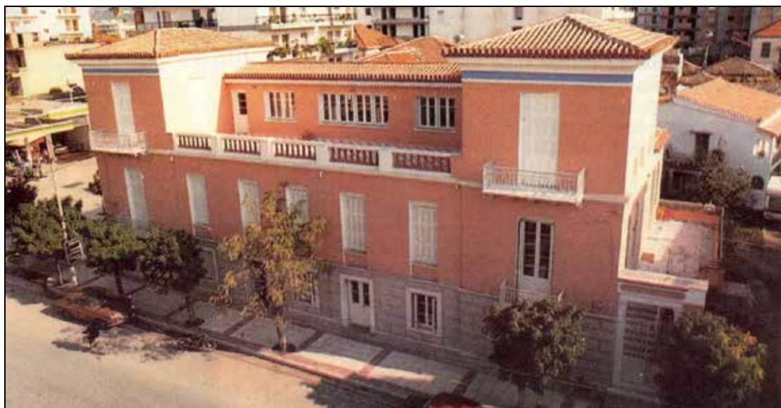
4.3 το κτίριο Κοτταρόπουλου, που στεγάζει πλέον την Δημοτική Σχολή Εικαστικών
