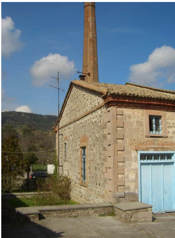
Εικόνα52. Διακρίνεται η «στέψη» στη στέγη, στα παράθυρα και στην πόρτα, όπως επίσης και οι πωρόλιθοι στις γωνίες του κτιρίου.
