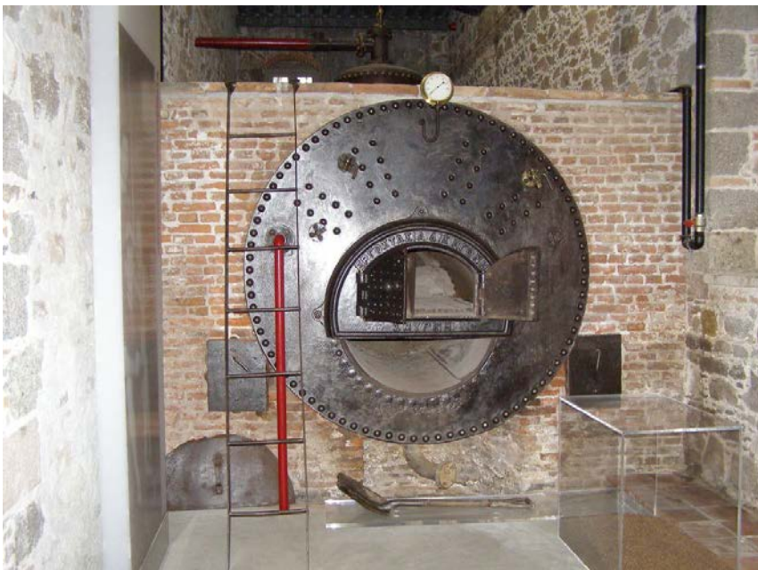
Εικόνα36. Το καζάνι, ο λέβητας στο ανακαινισμένο Κοινοτικό ελαιοτριβείο Αγίας Παρασκευής, Λέσβου
