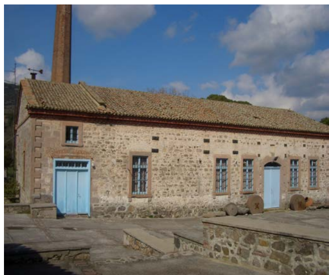
Εικόνα54. Η δίριχτη στέγη του κεντρικού κτιρίου.
