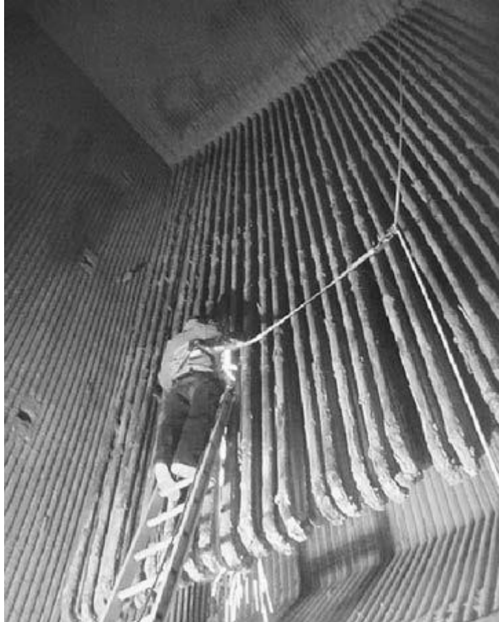
XIII Εικόνα 3.11 Λέβητας κατά τη συντήρηση (Ε. Kalogirou, 2017)
