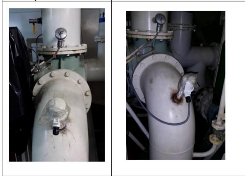
Σχήμα 5.4 ε Σημείο εγκατάστασης αισθητήρα θερμοκρασίας.
