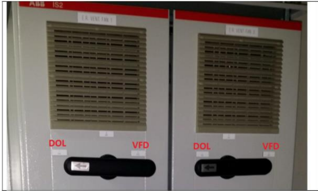
Σχήμα 5.5 π Διακόπτης καμπίνας για την επιλογή λειτουργίας.
