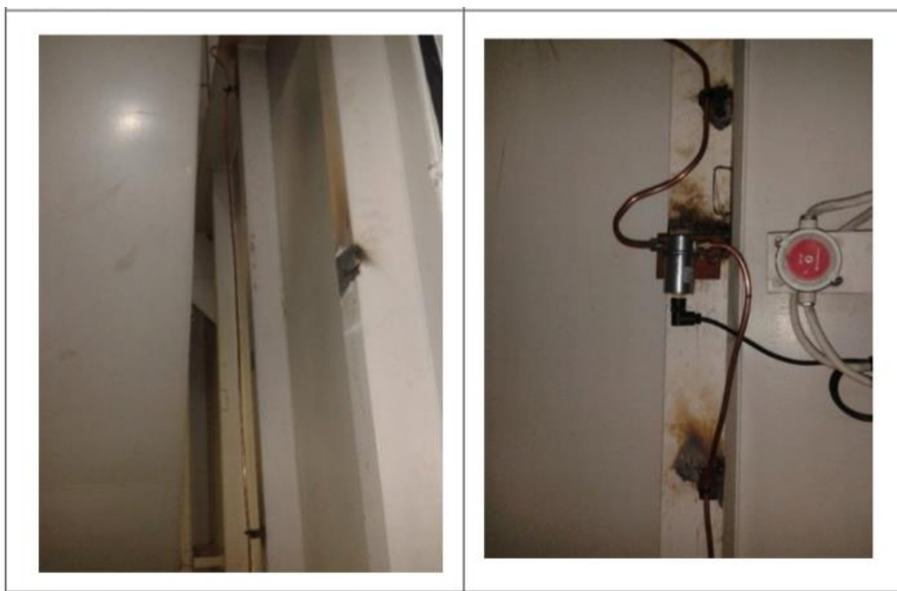
Σχήμα 5.4 ς Σημείο εγκατάστασης αισθητήρα διαφορικής πίεσης μηχανοστασίου.
