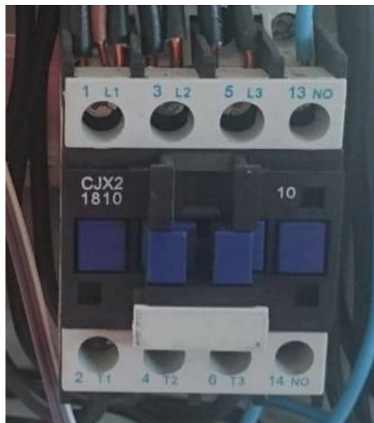
Εικόνα 2.4.4: Ρελέ εκκίνησης κινητήρα
