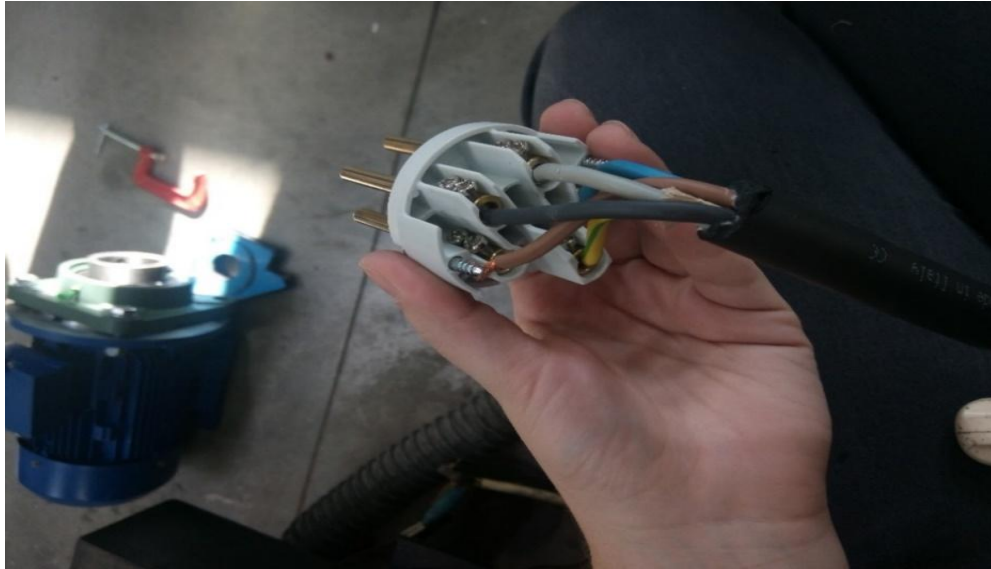
Εικόνα 3.3.1: Συνδεσμολογία φάσεων στο τριφασικό φις
