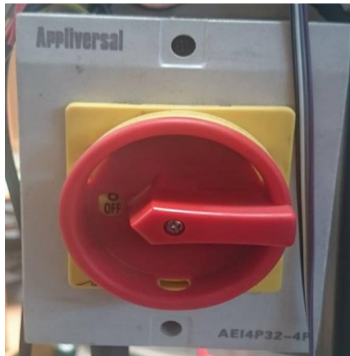
Εικόνα 2.4.6: Γενικός διακόπτης ρεύματος
