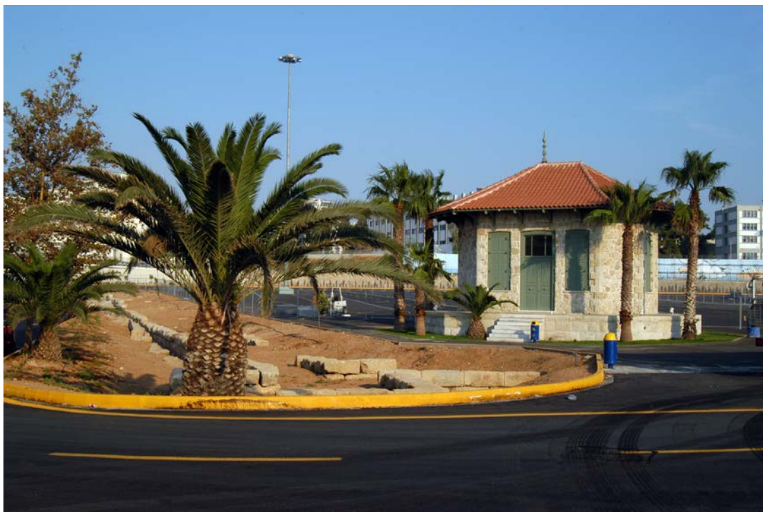
Εικόνα78:Τελική διαμόρφωση Βασιλικού Περιπτέρου. Προέλευση εικόνας: Οργανισμός Λιμένος Πειραιά. Λήψη εικόνας:άγνωστη ημερομηνία.
