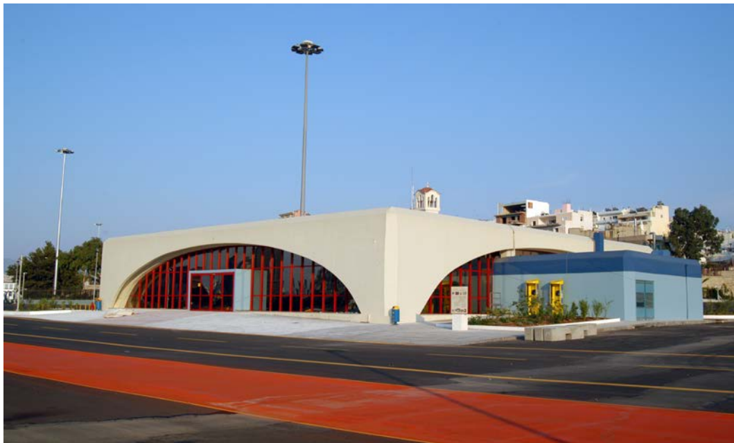
Εικόνα75:Επιβατικός σταθμός Ξαβερίου – τελική διαμόρφωση. Προέλευση εικόνας: Οργανισμός Λιμένος Πειραιά.
