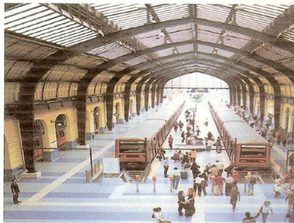
Εικόνα 37:Η ανακαίνιση του σταθμού του Πειραιά το 2000 με μελέτη του αρχιτέκτονα Κ. Μωραΐτη.
