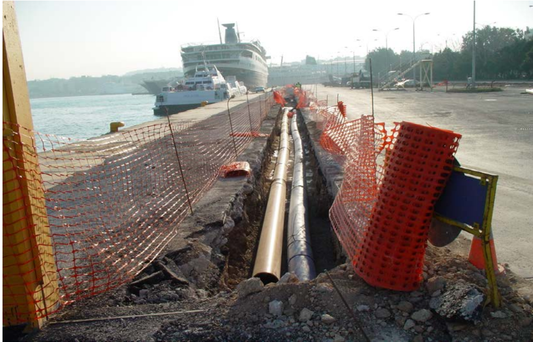
Εικόνα 53: Δίκτυο ύδρευσης–αποχέτευσης–πυρόσβεσης υπό κατασκευή. Προέλευση εικόνας: Οργανισμός Λιμένος Πειραιά. Λήψη εικόνας: άγνωστη ημερομηνία.
