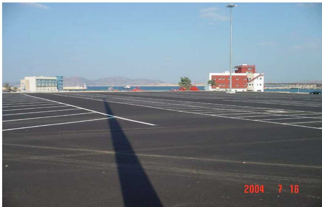
Εικόνα82:Πυροσβεστικός και Πλοηγικός Σταθμός στο Παλατάκι. Προέλευση εικόνας: Οργανισμός Λιμένος Πειραιά. Λήψη εικόνας:Ιούλιος 2004.
