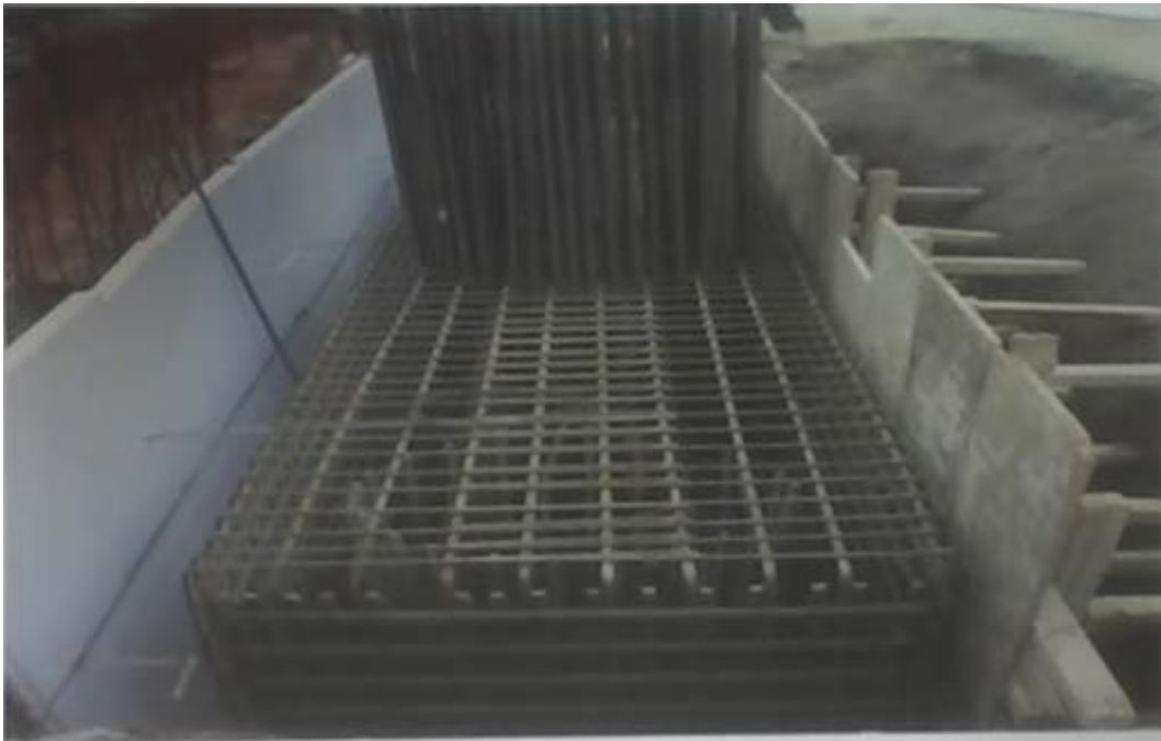
Εικόνα 19:Ενίσχυση τοίχου-βάθρου υφιστάμενης γέφυρας, επί της οδού Μ. Ασίας . Προέλευση εικόνας:Υ.ΠΕ.ΧΩ.ΔΕ. Λήψη εικόνας:άγνωστη ημερομηνία
