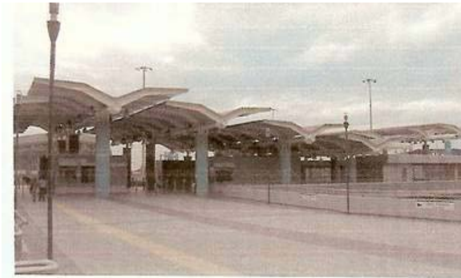
Εικόνα 41:Βορινή όψη στέγαστρου σταθμού Φαλήρου από την πλευρά του Σταδίου Καραϊσκάκη. Προέλευση εικόνας:Μεταλλικές Κατασκευές, Τεχνικό Επιστημονικό Περιοδικό για Μεταλλικές & Σύμμεικτες Κατασκευές Κωδ. 7574/τεύχος 2ο σελ.29 Λήψη εικόνας:άγνωστη ημερομηνία
