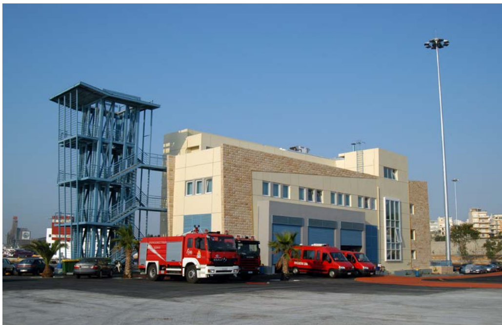
Εικόνα79:Πυροσβεστικός Σταθμός υπό κατασκευή. Προέλευση εικόνας: Οργανισμός Λιμένος Πειραιά. Λήψη εικόνας:άγνωστη ημερομηνία.
