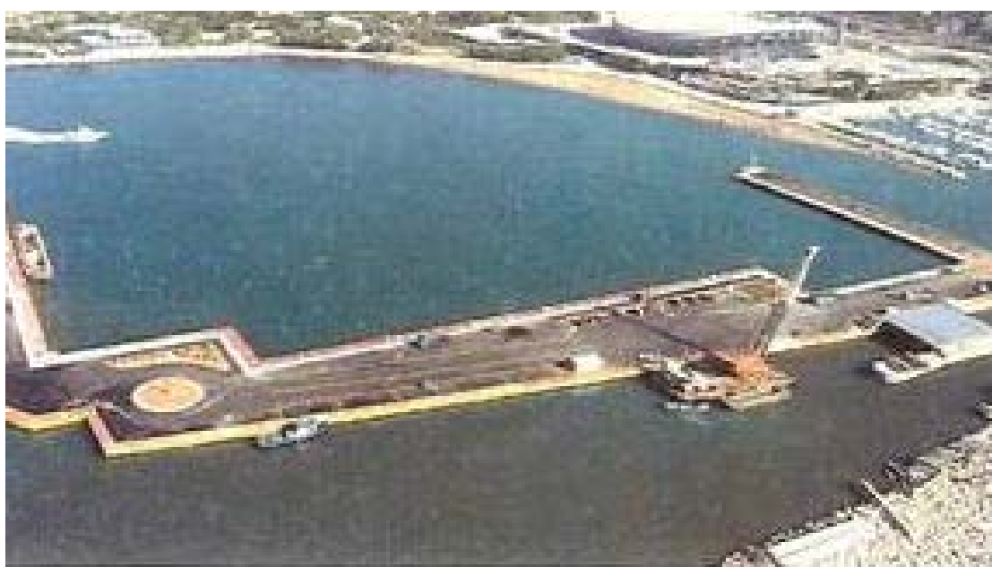
Εικόνα87:Εικόνα από την εξωτερική λιμενολεκάνη. Προέλευση εικόνας: Denco Σύμβουλοι Μηχανικοί Ε.Π.Ε. Λήψη εικόνας:άγνωστη ημερομηνία.
