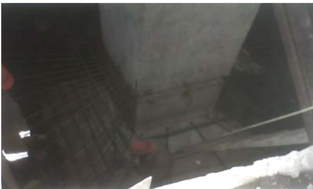
Εικόνα 17:Ενίσχυση θεμελίων υφιστάμενης γέφυρας, επί της Γρ.Λαμπράκη. Προέλευση εικόνας:Υ.ΠΕ.ΧΩ.ΔΕ. Λήψη εικόνας:άγνωστη ημερομηνία
