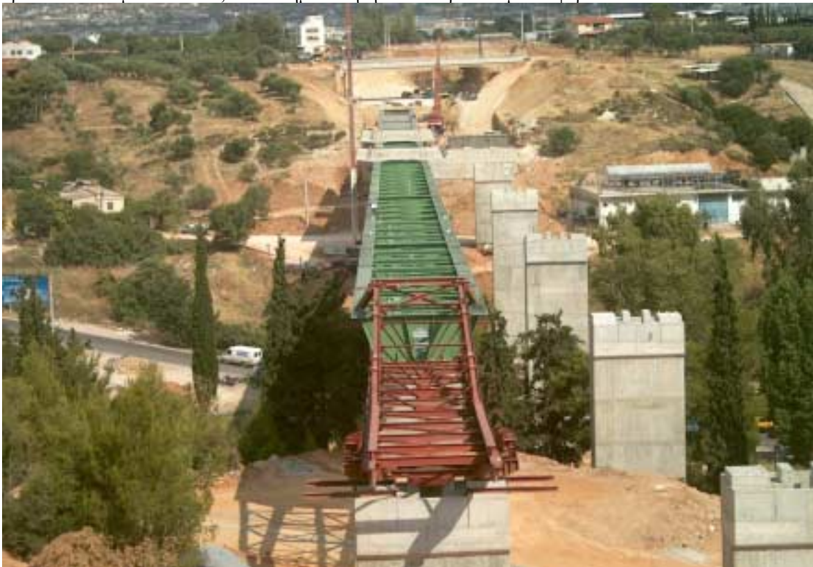
Φωτογραφία 6. Γενική άποψη φορέα Λ. Κύμης σε φάση προώθησης. Διακρίνεται μέρος των προκατασκευασμένων δοκών, τοποθετημένων ήδη επί του προωθούμενου φορέα.
