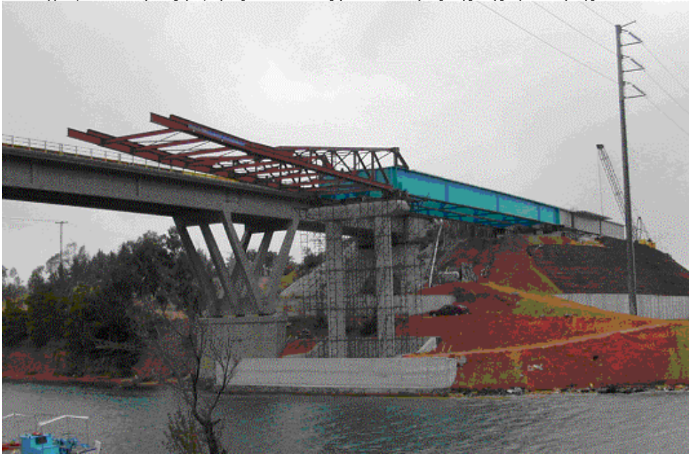
Φωτογραφία 6. Γενική άποψη φορέα Λ. Κύμης σε φάση προώθησης. Διακρίνεται μέρος των προκατασκευασμένων δοκών, τοποθετημένων ήδη επί του προωθούμενου φορέα.
