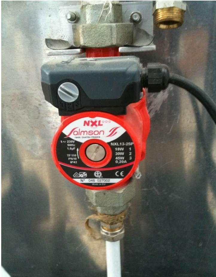
Σχήμα 2.9: Αντλία παροχής νερού συνδεδεμένη σε κύκλωμα.
