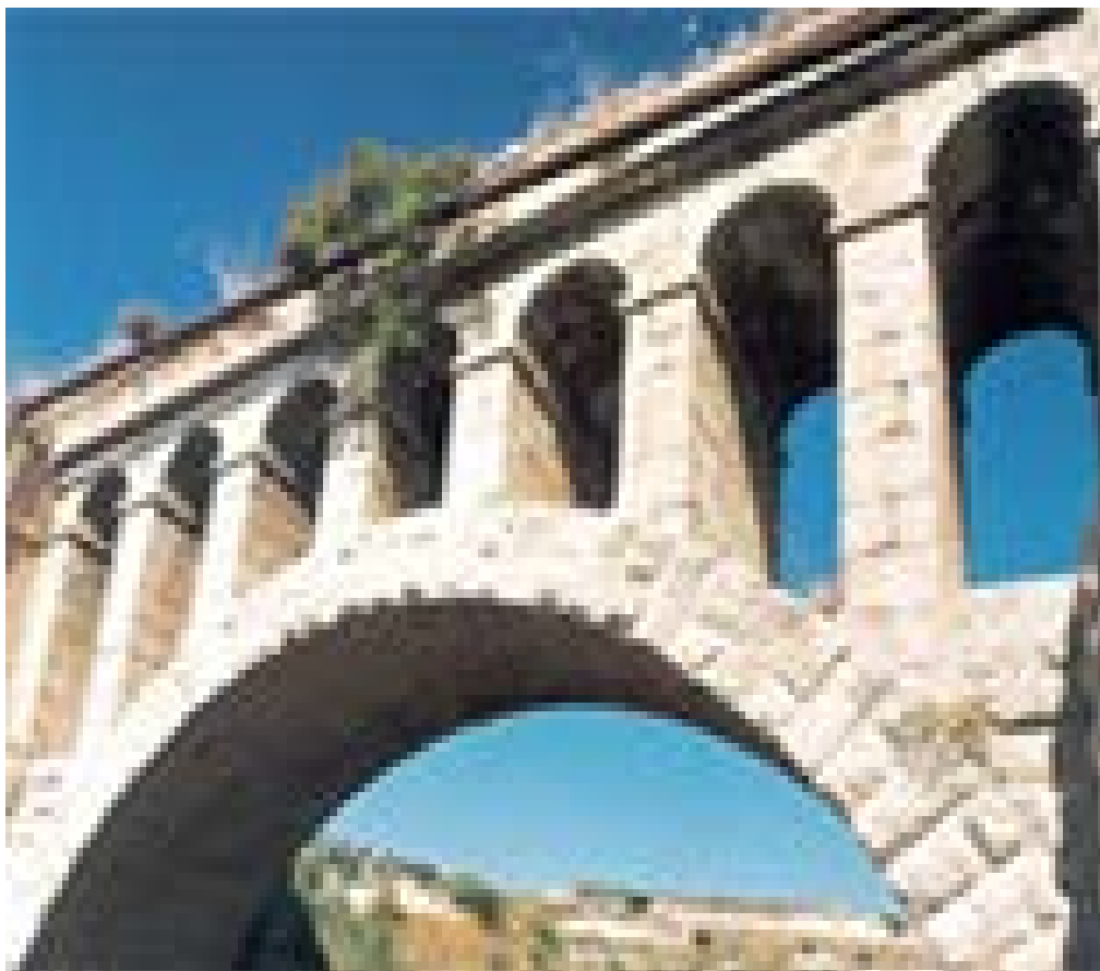
Η υδατογέφυρα στον Λογγοπόταμο Λεχαίου
