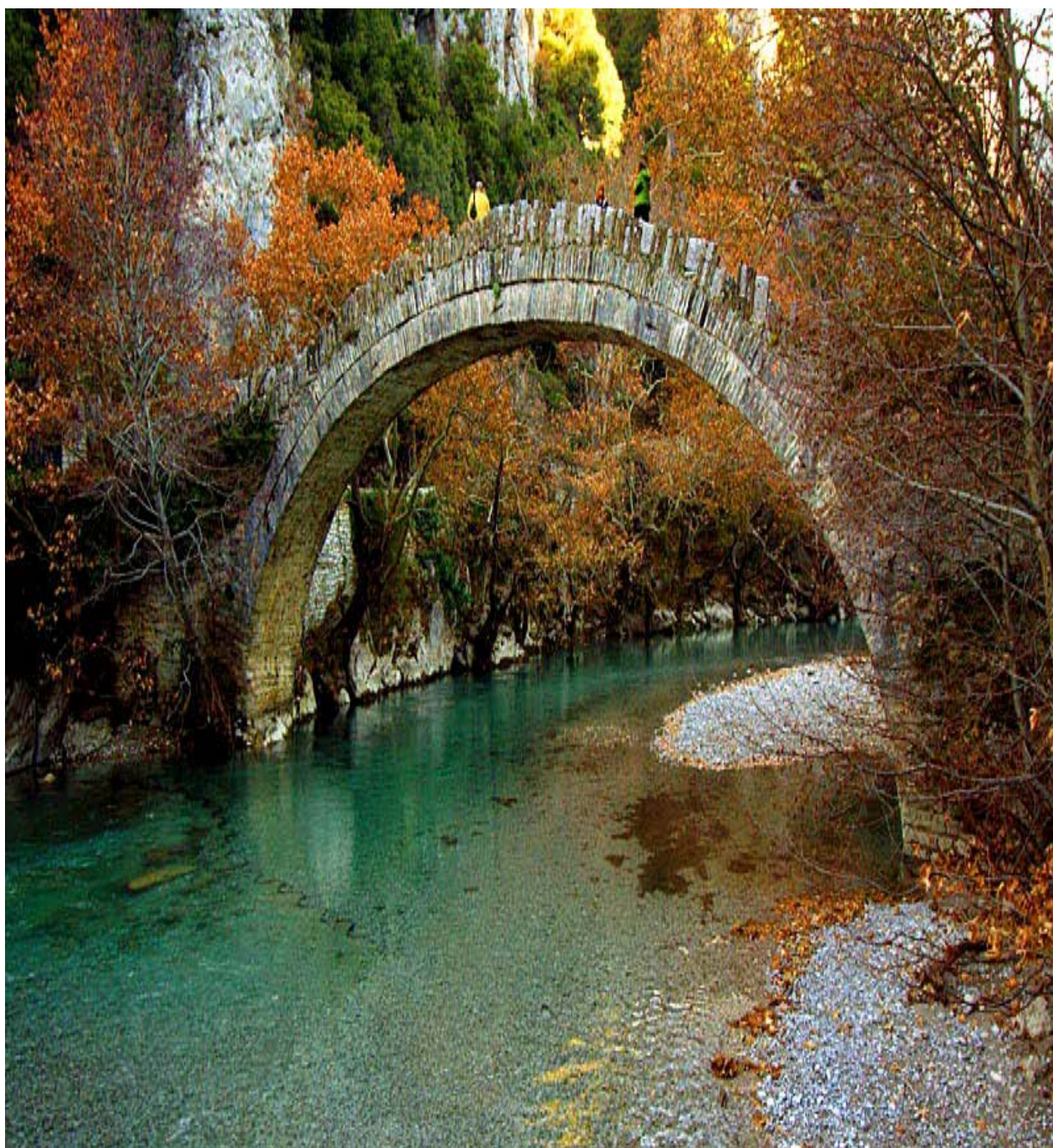
Η γέφυρα Κλειδωνιάς στον Βοϊδομάτη
