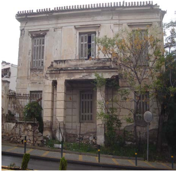
Εικόνα 26: Δυτική πλευρά κτιρίου
