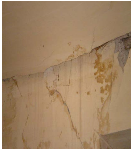
Εικόνες 30&31: Αποκολλήσεις σοβάδων και ρηγματώσεις στην τοιχοποιία στα δωμάτια του ισογείου.
