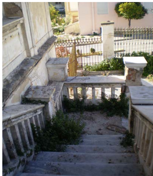
Εικόνα 50: Δεξιά σκάλα Ά ορόφου
