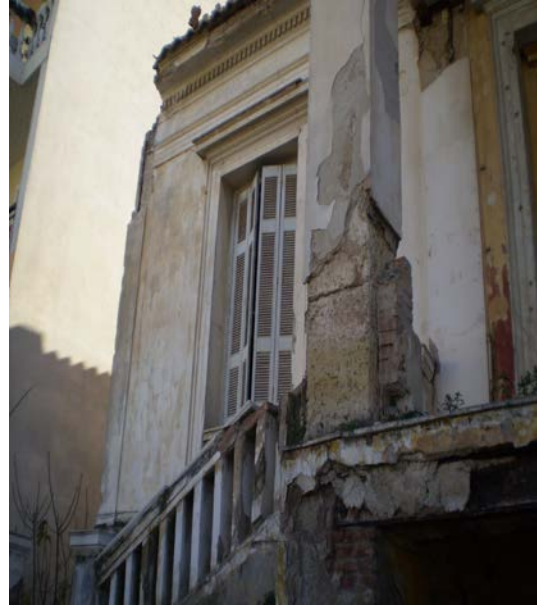
Εικόνα 42: Κατεστραμμένο αέτωμα. Εικόνα 43: Αποκόλληση σοβάδων της κολώνας
