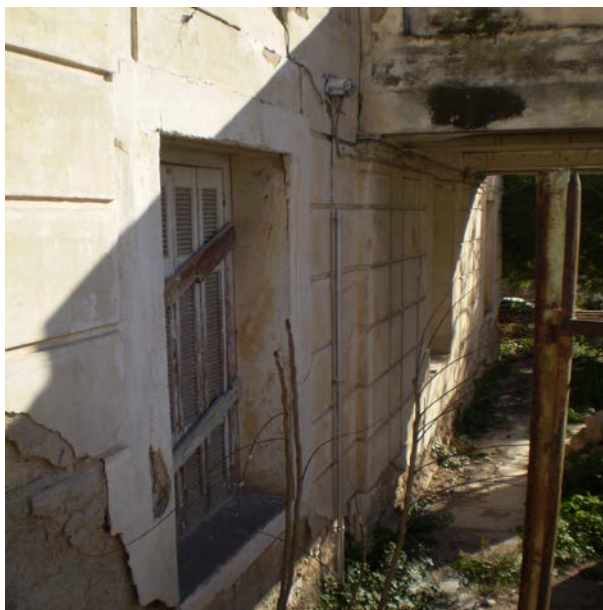
Εικόνα 44: Αποκόλληση σοβάδων και εμφάνιση υγρασίας .
