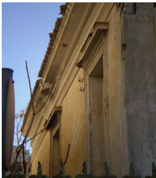
Εικόνα 48: Ανατολική πλευρά σπιτιού
