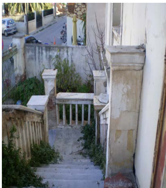
Εικόνα 49: Αριστερή σκάλα Ά ορόφου
