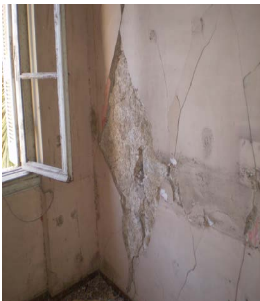
Εικόνες 32&33 :Ρηγματώσεις και αποκολλήσεις σοβάδων.
