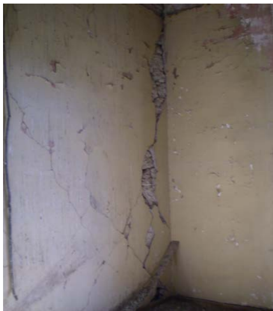
Εικόνες 32&33 :Ρηγματώσεις και αποκολλήσεις σοβάδων.
