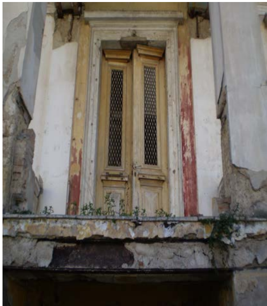
Εικόνα 1: Κύρια είσοδος Ά ορόφου
