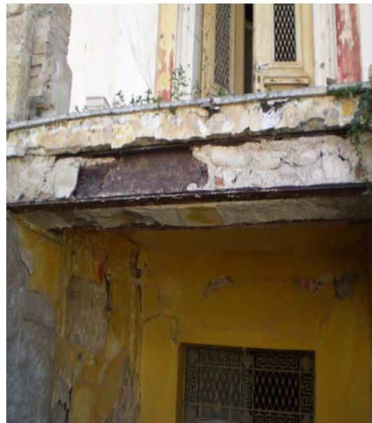
Εικόνα 41: Απογύμνωση του δοκαριού του πλατύσκαλου
