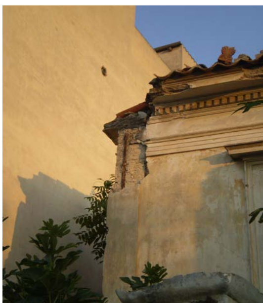
Εικόνα 47: Αποκόλληση στέγης
