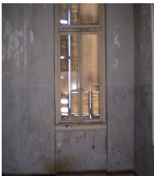
Εικόνα 34: Κατεστραμμένα κουφώματα.
