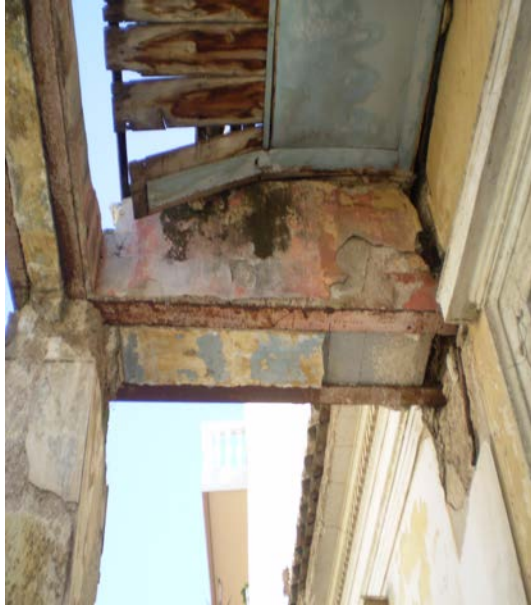
Εικόνα 42: Κατεστραμμένο αέτωμα. Εικόνα 43: Αποκόλληση σοβάδων της κολώνας
