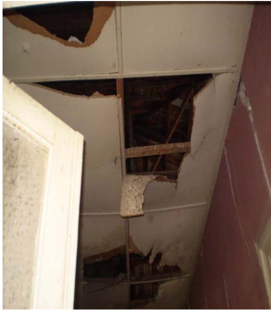
Εικόνες 37,38&39: Αποκόλληση ξύλινης στέγης
