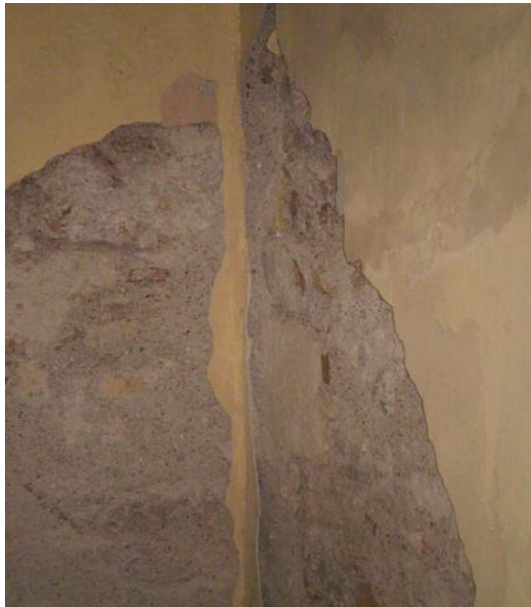
Εικόνες 30&31: Αποκολλήσεις σοβάδων και ρηγματώσεις στην τοιχοποιία στα δωμάτια του ισογείου.
