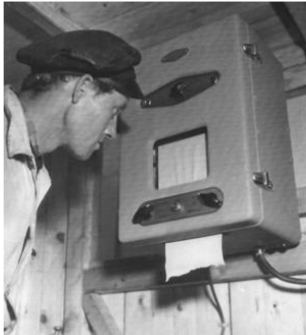
Εικόνα 28: One of Simrad's first echo sounders
