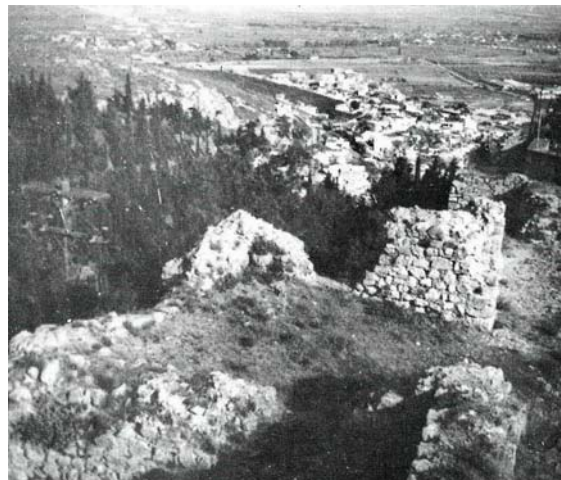
Δώμα πυργοειδούς προβολής εσωτερικά κατά την Β.Α. πλευρά.
