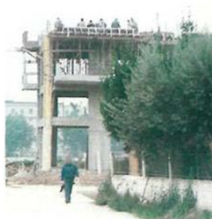
Αριστερά: Προστασία περάτων πλακών. Ασφαλής μετακίνηση από όροφο σε όροφο. Κλίμακες προστατευμένες έναντι πτώσης με κουπαστές Πάνω: Διάλειμμα στα άκρα ξυλότυπου.
