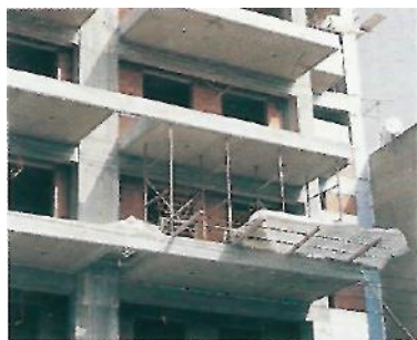
Απαράδεκτο προστατευτικό προστέγασμα (ακατάλληλη κλίση και υλικά, περιορισμένο μήκος).
