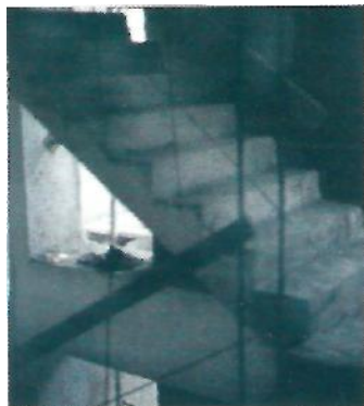
Κλιμακοστάσιο με προστασία έναντι πτώσης. Απαιτούνται κουπαστές και στο πλατύσκαλο.
