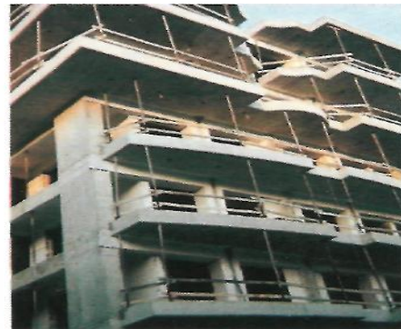
Ασφαλής προστασία στα πέρατα των εξωστών με πατοκολώνες και οικοδομικό πλέγμα/ σανίδα
