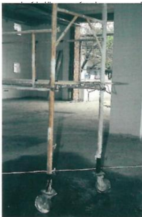
Οι τροχοί στους πύργους πρέπει να έχουν φρένα σε καλή λειτουργία.
