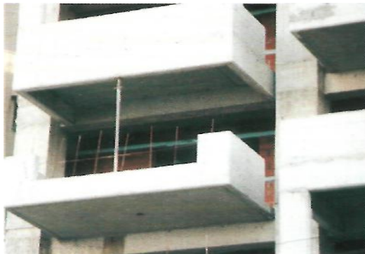
Ασφαλής προστασία στα πέρατα των εξωστών με πατοκολώνες και οικοδομικό πλέγμα/ σανίδα
