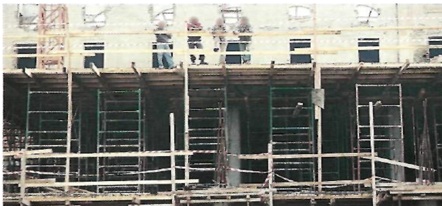
Ασφαλής προστασία και σήμανση στα πέρατα ξυλότυπου.
