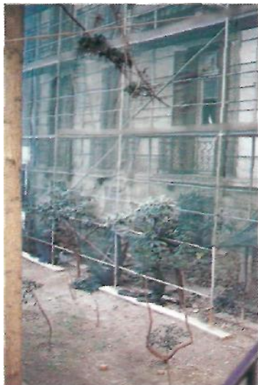
Ορθή έδραση σκαλωσιάς σε έδαφος (το μαδέρι μπορεί να παραλειφθεί σε σκληρή επιφάνεια έδρασης).
