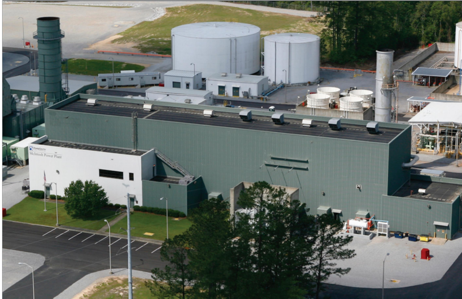
Εικόνα 3.12 Μονάδα αποθήκευσης ενέργειας με συμπιεσμένο αέρα στο McIntosh, Alabama στις ΗΠΑ. (Πηγή: Διαδίκτυο)
